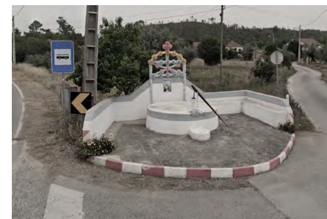
Fig. 89. Fonte de água com bomba manual
