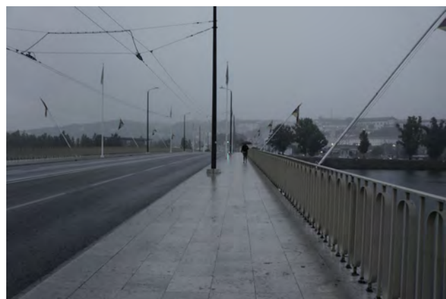
Fig. 41. Ponte de Santa Clara
