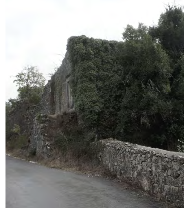
Fig. 64. Edifício devoluto perto de Alvorge
