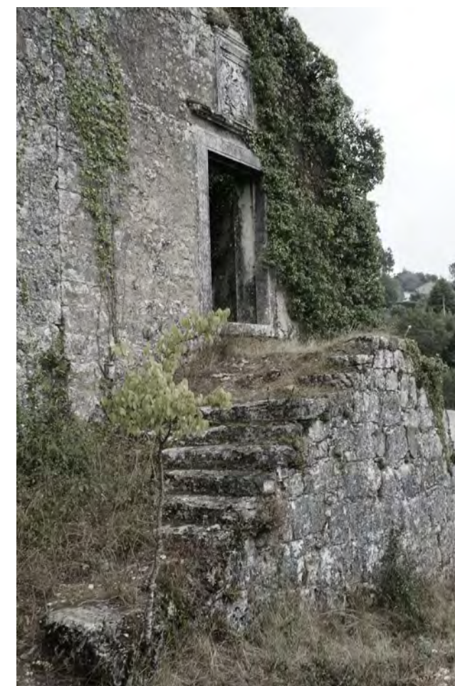
Fig. 66. Edifício devoluto perto de Alvorge
