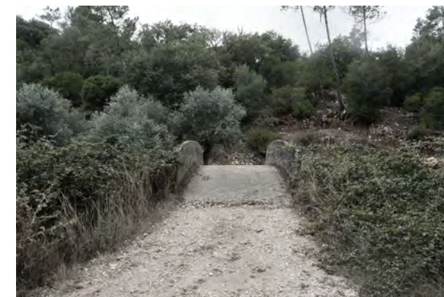
Fig. 87. Pequena ponte sobre o Rio Nabão (seco)
