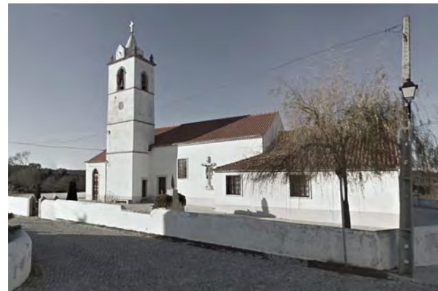
Fig. 72. Igreja da Nossa Senhora da Conceição em Alvorge
