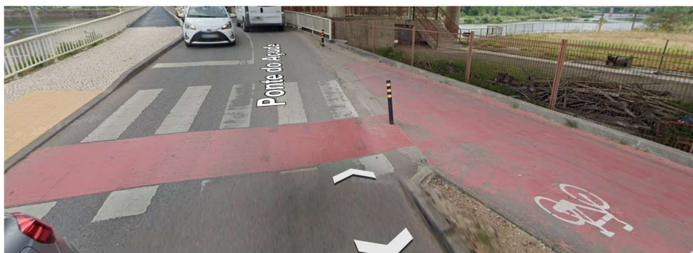
Figura 5.13 - Descontinuidade da linha, interrupção inesperada, obstáculo, atravessamento da Rua Ponte do Açude (Fonte: Google Earth, 2023)
