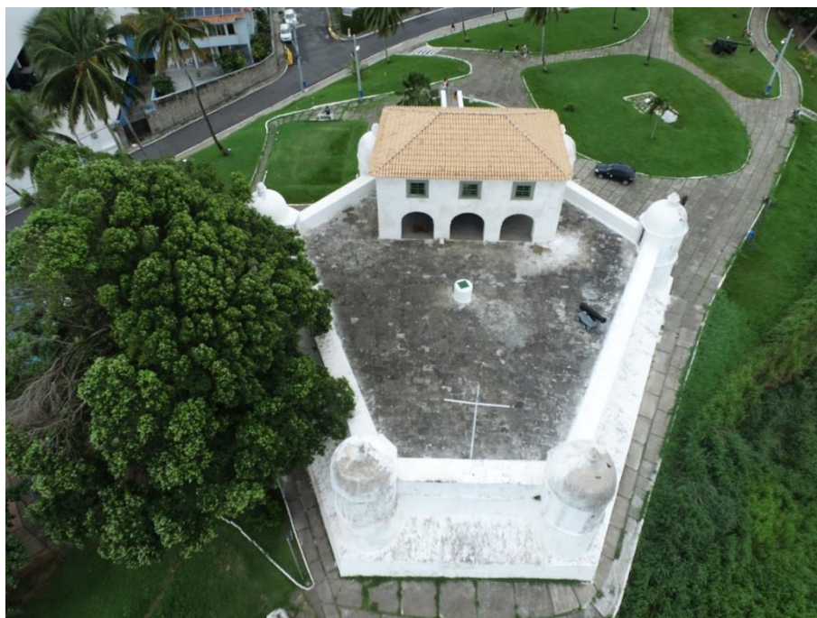
Figura B 45 - Foto aérea com drone. (Fonte:SPIMA6)
