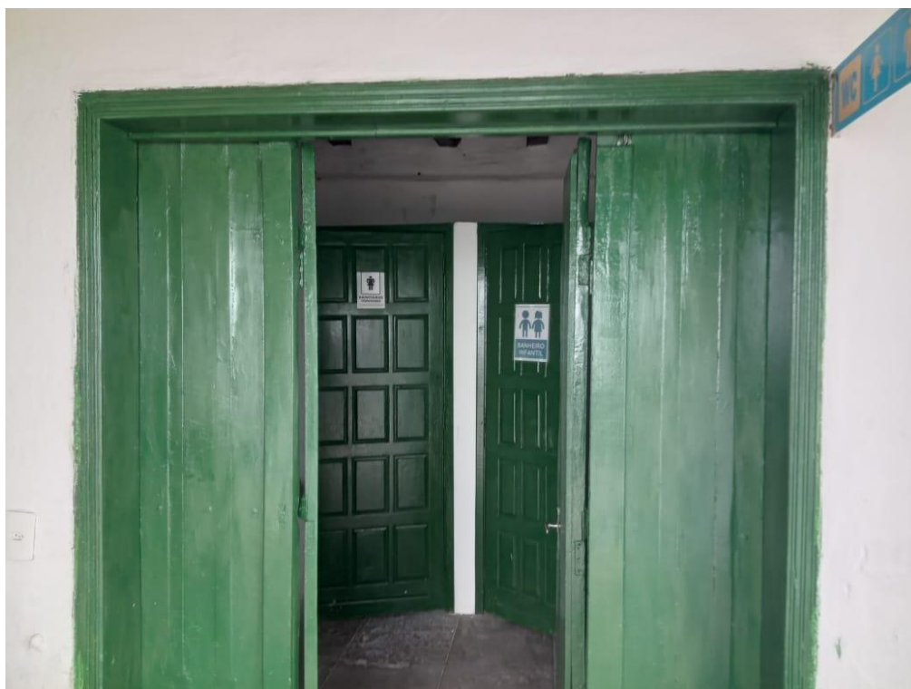
Figura B 22 - Porta de acesso aos banheiros. (Fonte: Eng. Daiane Montenegro)
