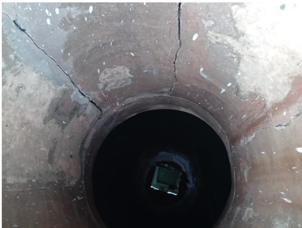
Figura B 10 - Acesso da Cisterna, internamente. (Fonte: Eng. Daiane Montenegro)
