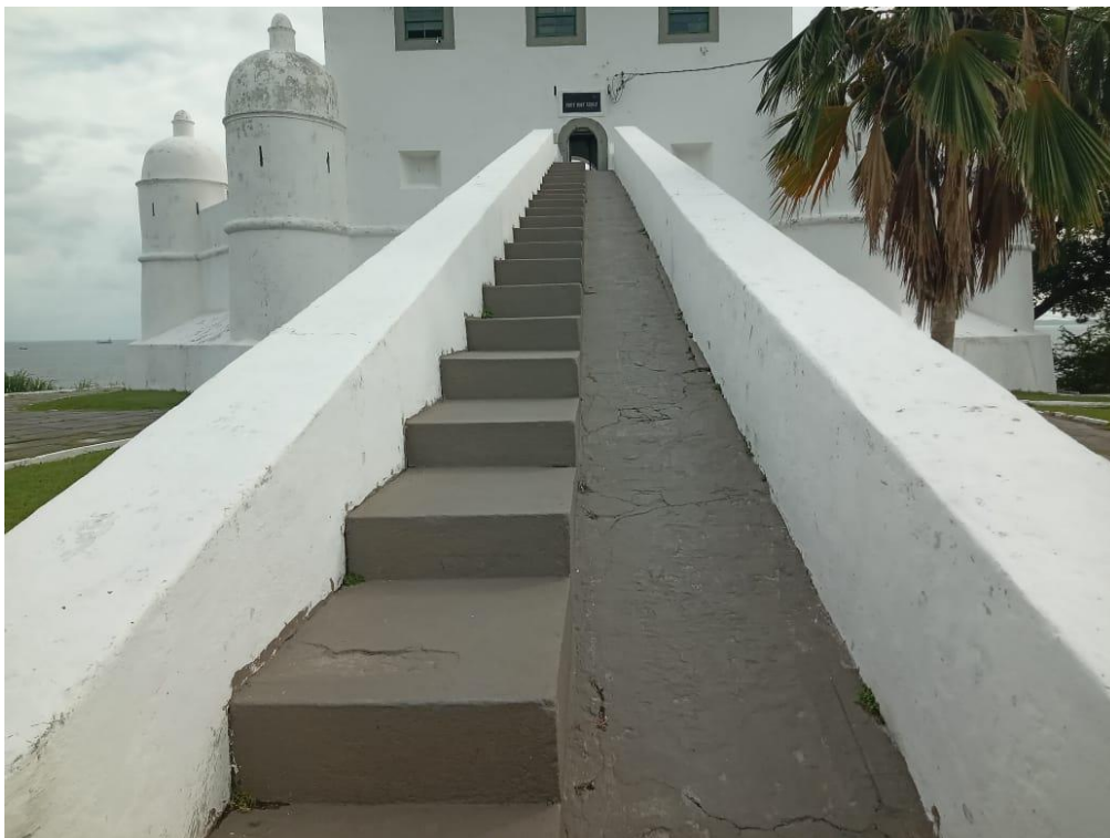
Figura B 3 - Escada e rampa de acesso. (Fonte: Eng. Daiane Montenegro)
