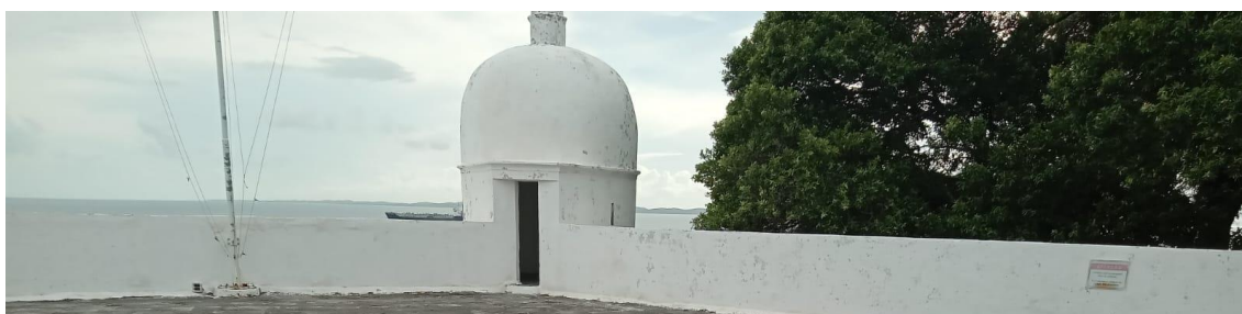
Figura B 16 - Vista interna da Muralha. (Fonte: Eng. Daiane Montenegro)
