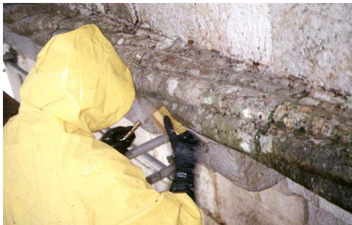
Figura 3-3 - Fase de Limpeza. (Fonte: https://www.ncrestauro.pt )
