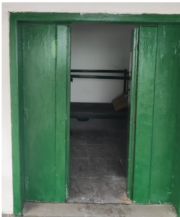
Figura B 18 - Porta de acesso ao alojamento. (Fonte: SPIMA6)
