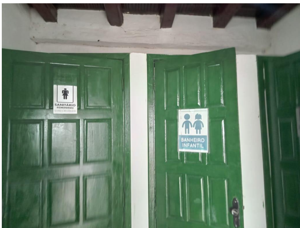
Figura B 23 - Portas das cabines do banheiro. (Fonte: Eng. Daiane Montenegro)
