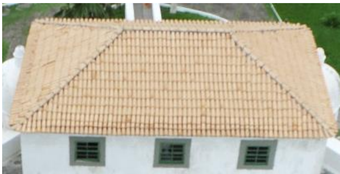
Figura B 43 - Cobertura. Foto aérea de drone. (Fonte SPIMA6)
