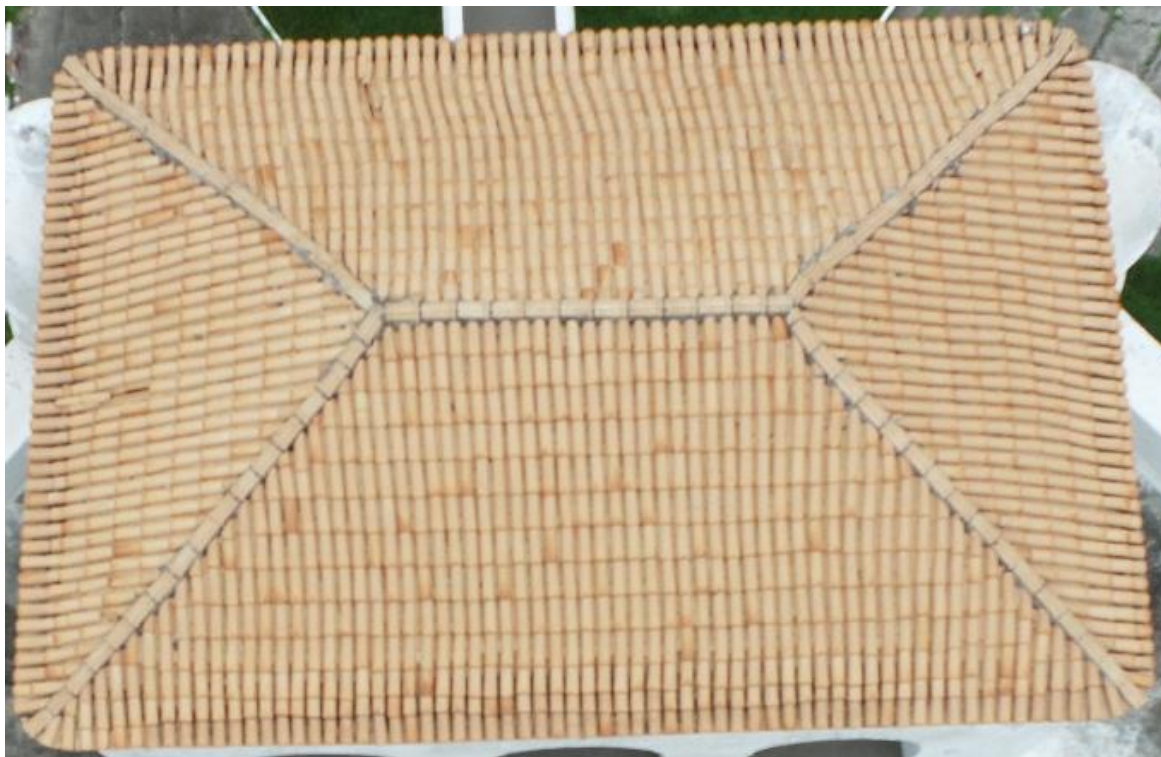
Figura B 42 - Cobertura. Foto aérea de drone. (Fonte: SPIMA6)
