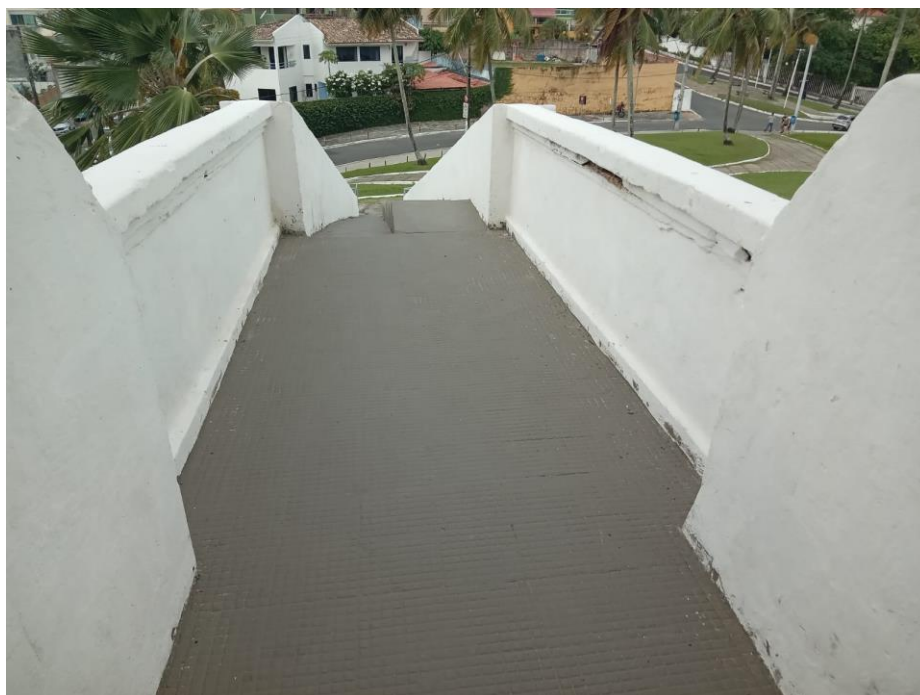
Figura B 4 - Escada e rampa. (Fonte: Eng. Daiane Montenegro)
