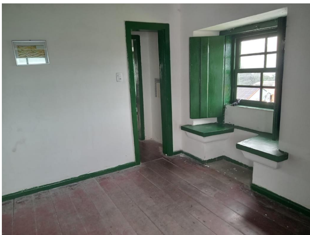
Figura B 39 - Sala 04. (Fonte: Eng. Daiane Montenegro)
