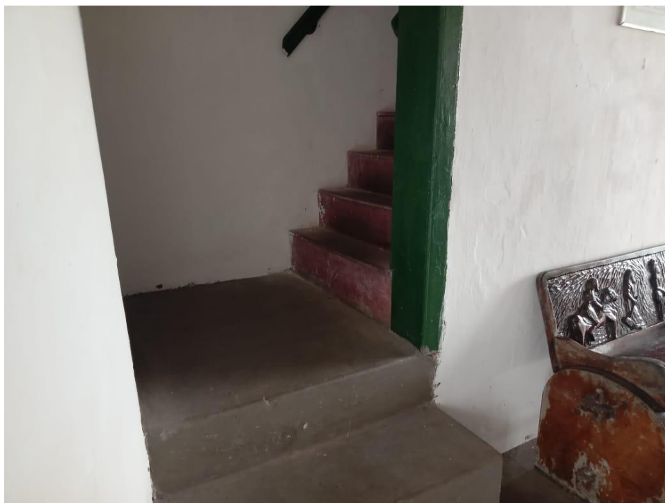
Figura B 34 - Escada interna. (Fonte: Eng. Daiane Montenegro)
