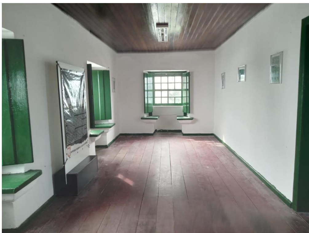
Figura B 36 - Sala 01 (Fonte: Eng. Daiane Montenegro)
