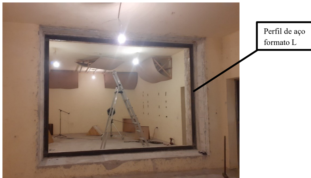
Figura 23- Câmaras acústicas durante preparo para montagem do ensaio (vista a partir da câmara emissora)
