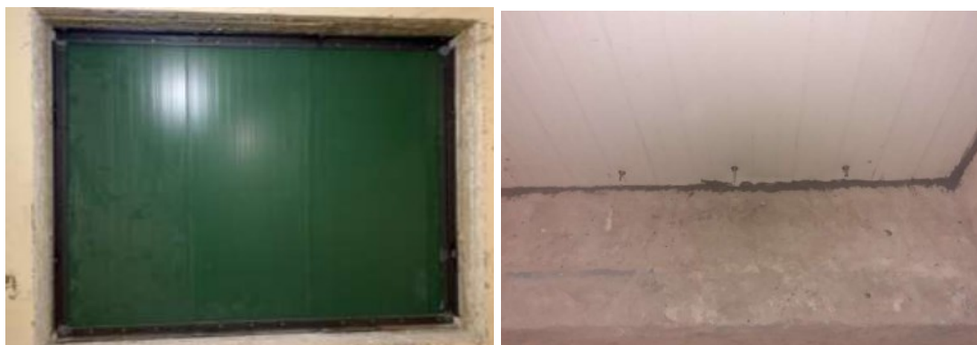
Figuras 24 e 25- Painel sanduíche de revestimento (P1) - Vista de ambas as faces
