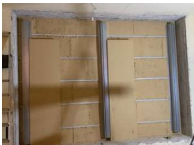
Figura 18- Montagem do sistema de revestimento duplo
