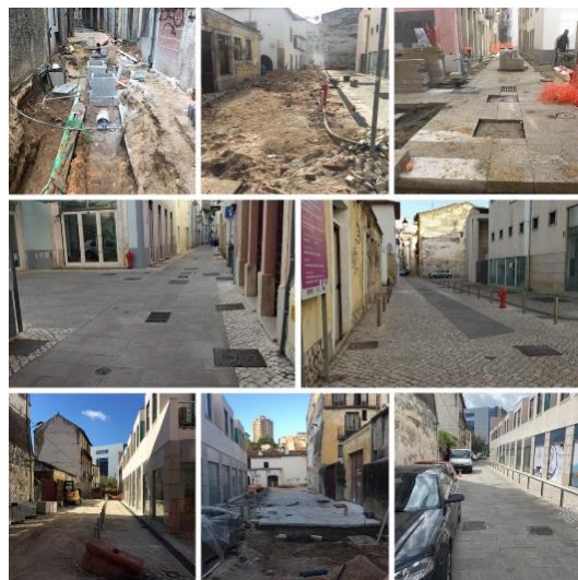
Figura 15 – Intervenções na Rua Direita e Rua da Nogueira.
