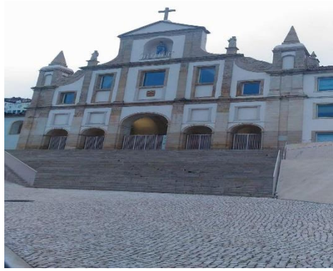
Figura 21 – Intervenção na Igreja do Convento de S. Francisco.
