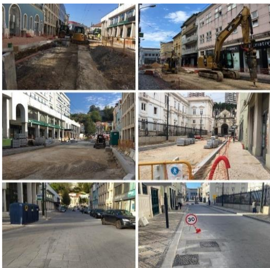
Figura 14 – Intervenções na Rua João Machado e Rua Dr. Manuel Rodrigues.
