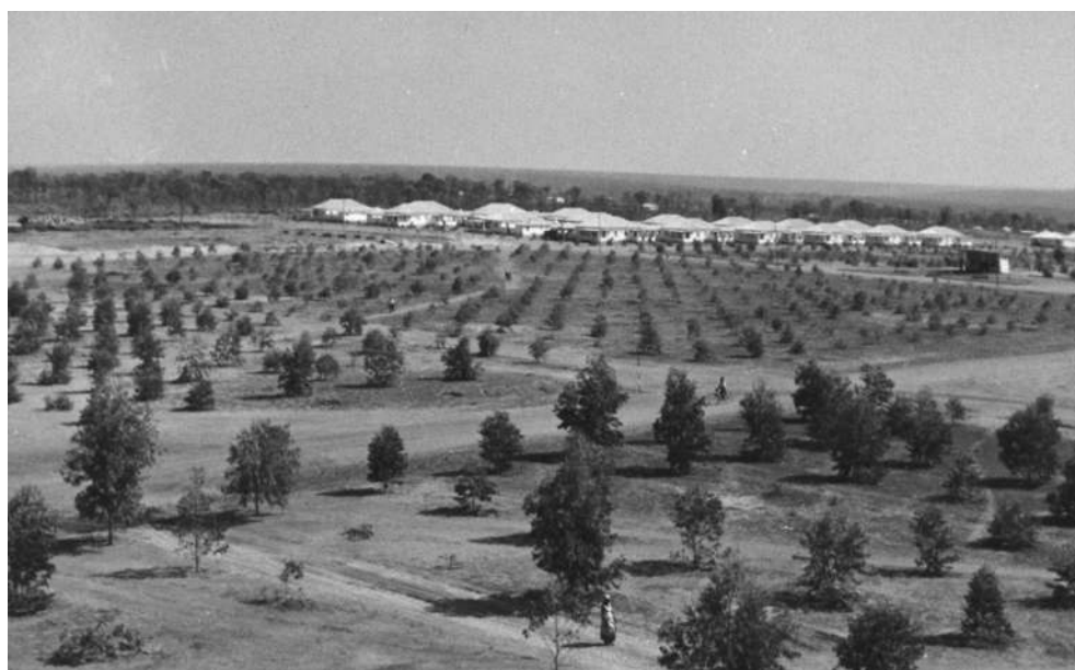
[37] Lançamento da povoação do Lucapa, com mata de eucaliptos envolvente, 1965 [Urbanização e Saneamento na Lunda, 1965-66, UC/AD]
