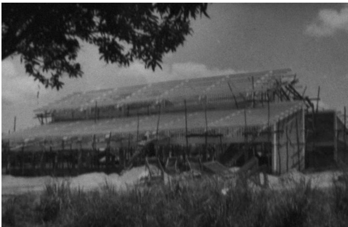
Oficina para a SMMM. Um aspecto da construção. Lado norte [Construção e Reparação de Edifícios, 1950-53. UC/AD]
