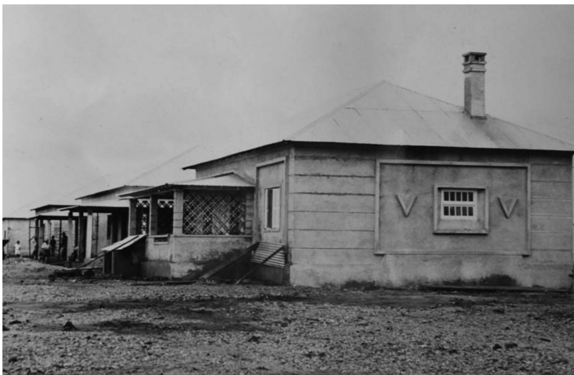
Casas de habitação no Lucapa [Relatório do Serviço de Construção Civil, 1960-63. UC/AD]
