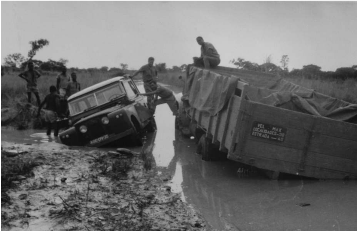
Estrada Cuango-longo. Aspecto normal de alguns troços na estação chuvosa, nas estradas de terra da área do Cuango [Relatório Anual da DSOVC, 1967. UC/AD]
