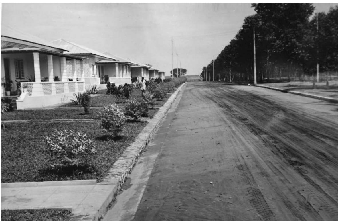
Bairro Sul, algum tempo depois dos trabalhos de urbanização concluídos [Relatório Anual da Concessão do Dundo, 1964. UC/AD]
