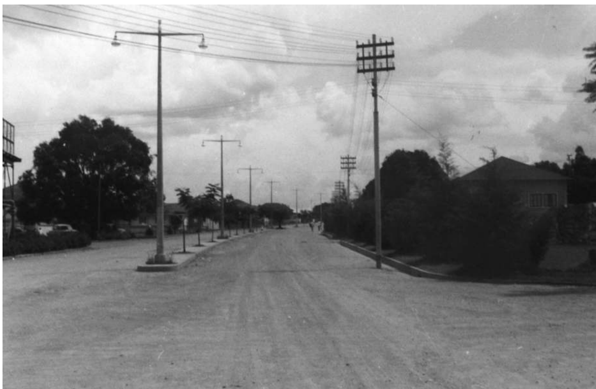
Estrada de “acesso secundário” à Central Luachimo, iluminação pública [Urbanização e Saneamento do Dundo, 1962. UC/AD]
