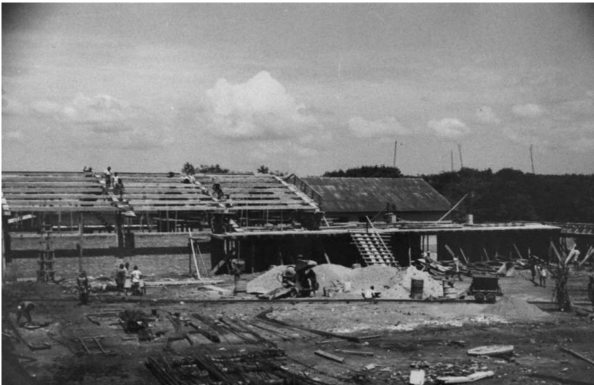
Novas instalações para a SAVM. Aspecto da construção do 1º corpo [Construção e reparação de edifícios, 1950-53. UC/AD]
