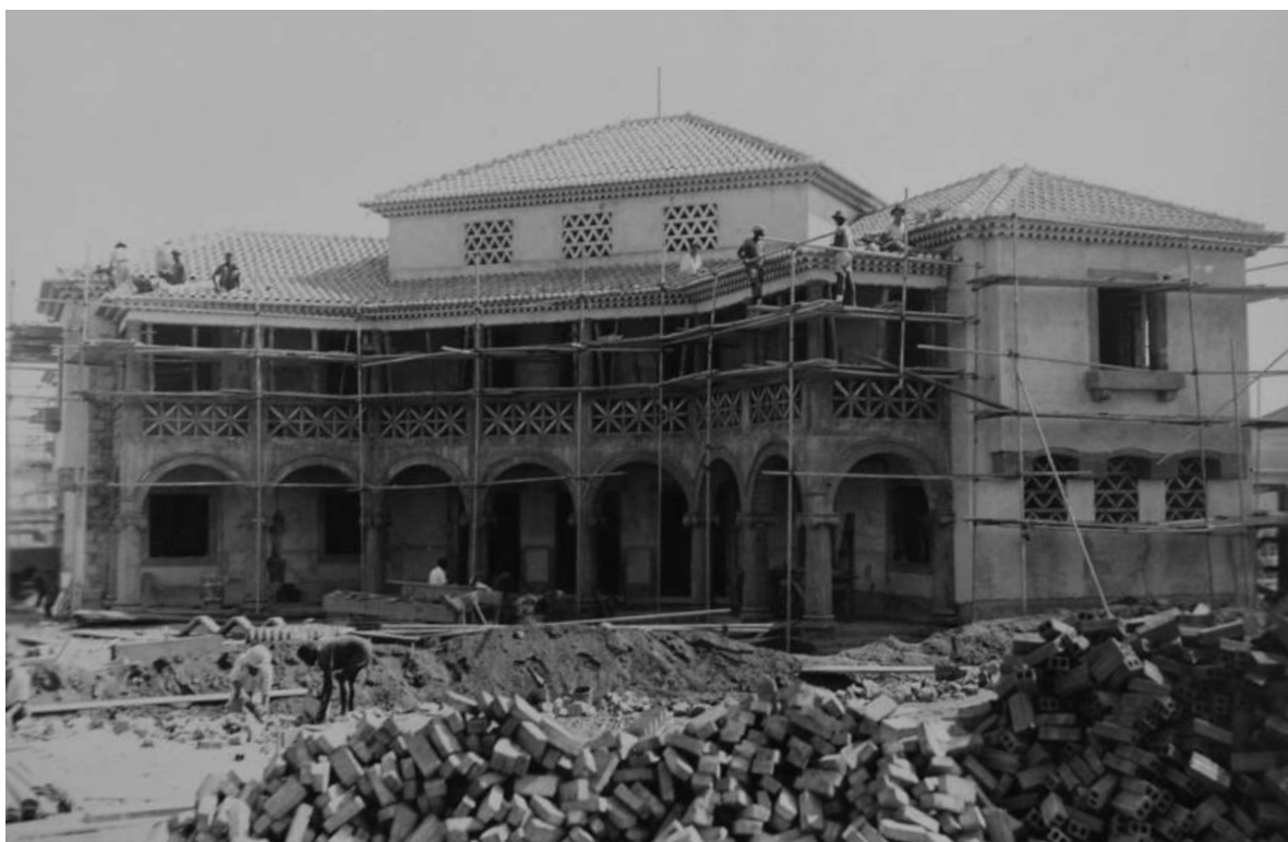
Bairro Residencial em Miramar, Casa tipo O (em construção) [Construções Luanda, 1952-1953. UC/AD]
