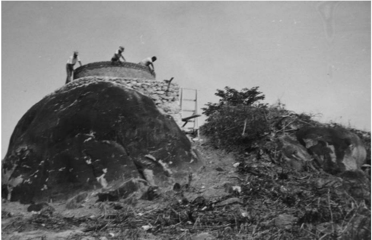
Sobre um alto bloco de granito, a construção da mais espaçosa torreta [Urbanização e Saneamento do Dundo, 1962. UC/AD]
