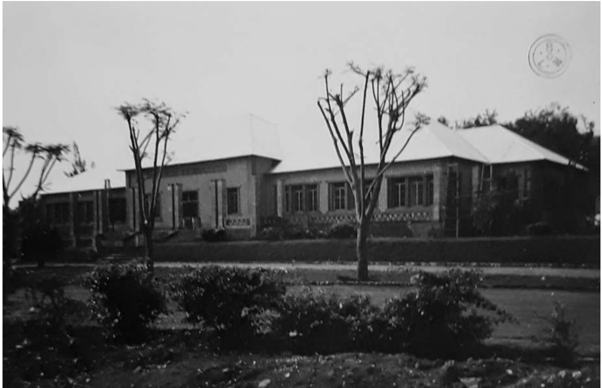
Hospital de Andrada em Construção [Viagem de Simões Neves, 1950. ANTT, AOS, Cx. 718]
