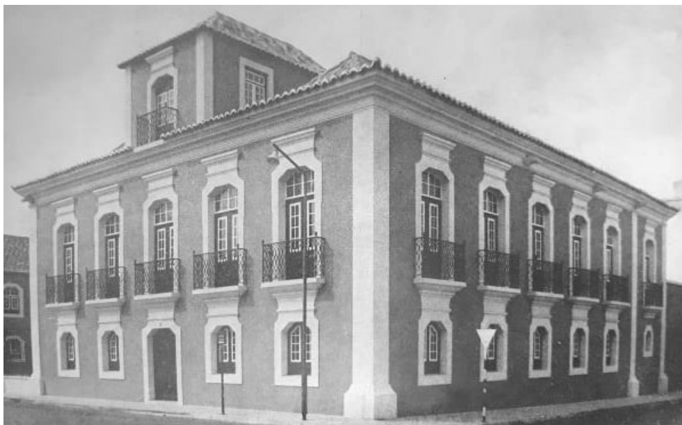
[191] Aspecto de conjunto da casa nobre setecentista restaurada pela Diamang, 1966 [Batalha (1966). Uma casa setecentista... ]
