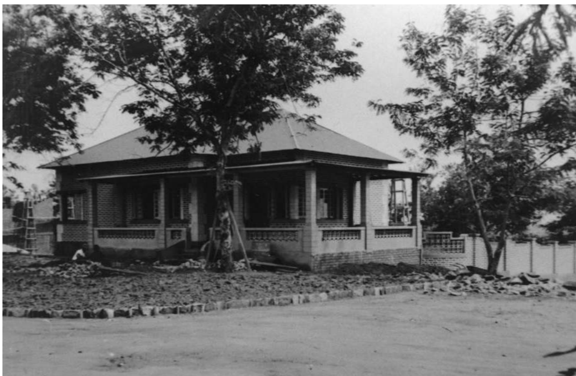
Futura habitação do Chefe do referido Posto, outro aspecto (casa nº K-158) [Construção e reparação de edifícios, 1950-53. UC/AD]
