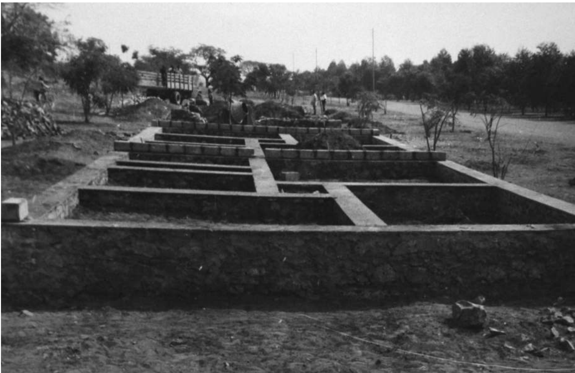
Aspectos da construção de casas geminadas mostrando a evolução dos trabalhos até à conclusão da primeira [Urbanização e Saneamento do Dundo, 1963-64. UC/AD]
