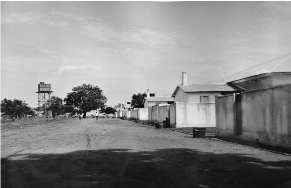
O mesmo local da fotografia anterior depois do trabalho concluído [Relatório Anual da Concessão do Dundo, 1964. UC/AD]
