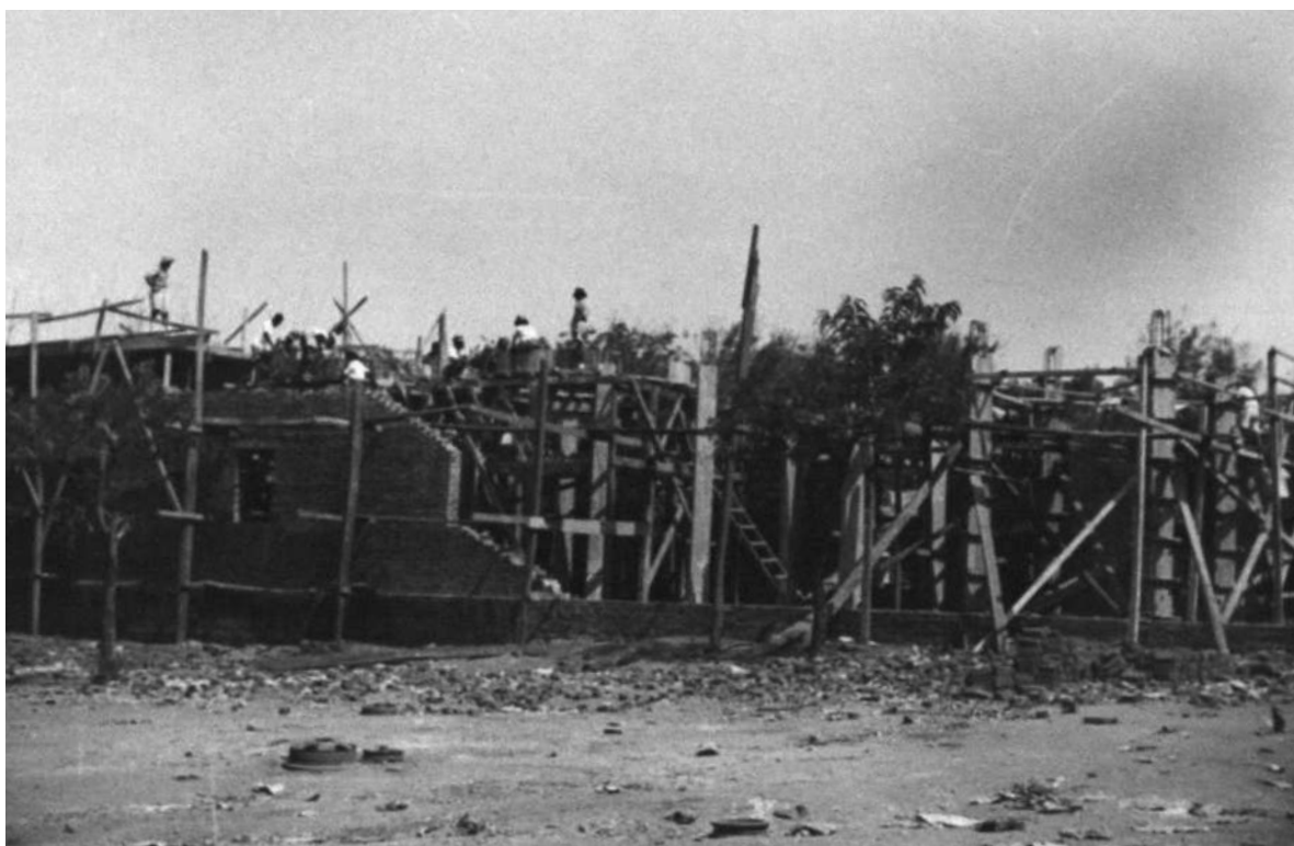
Dois aspectos da construção dos silos para milho e feijão [Construção e Reparação de Edifícios, 1950-53. UC/AD]
