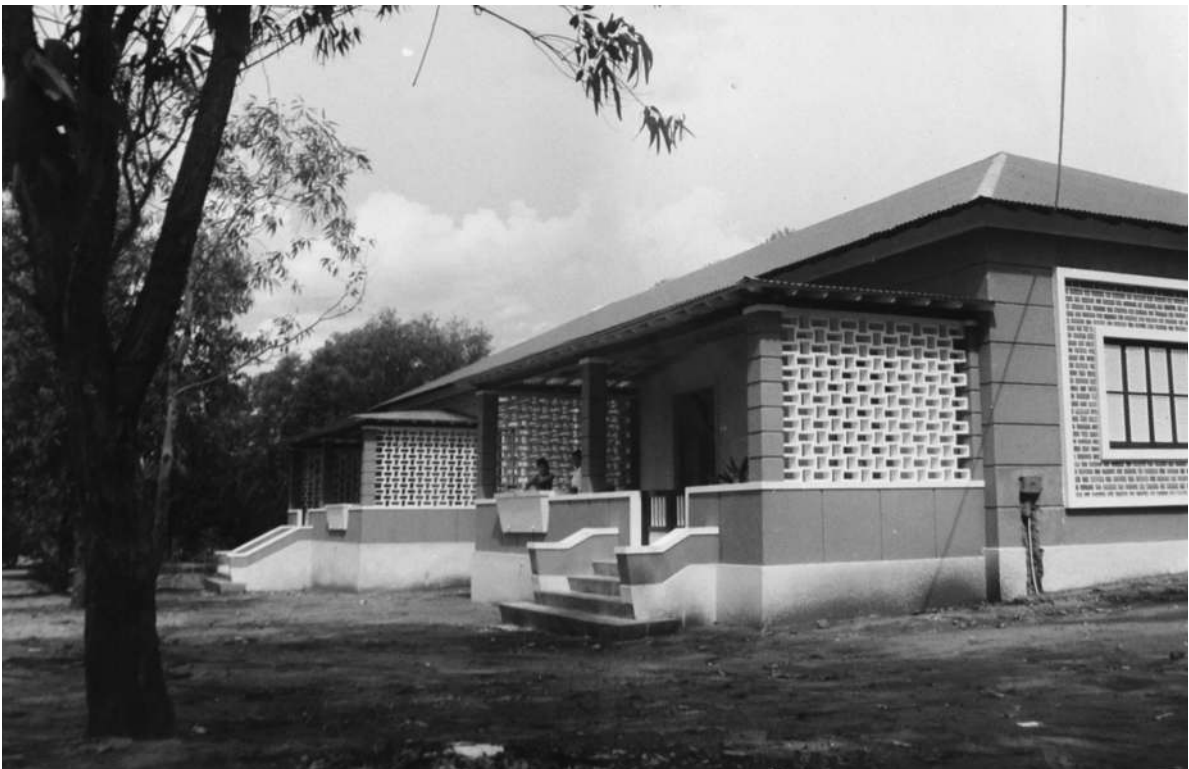
Casa de habitação geminada para empregado K-345 [Relatório Anual da DSOVC, 1967. UC/AD]
