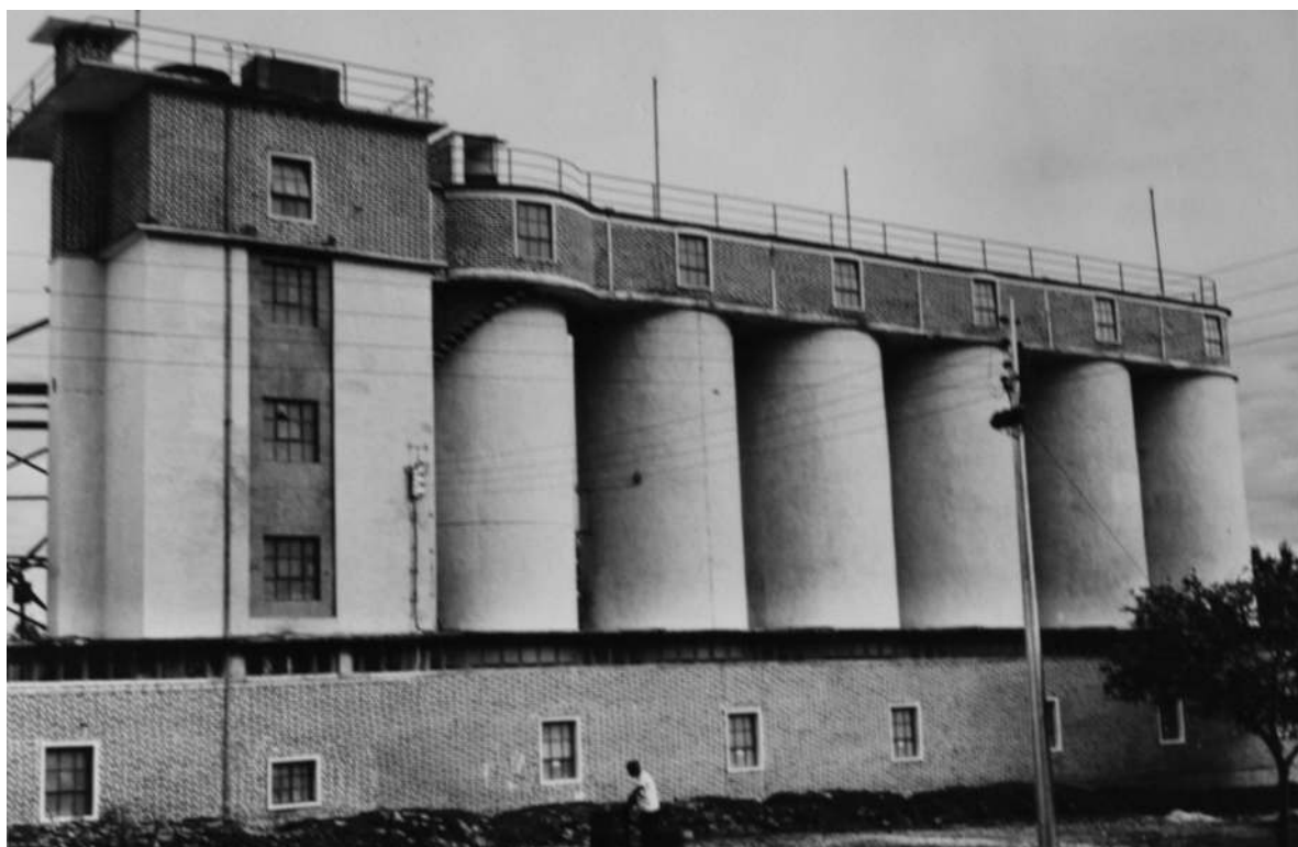
Silos de Andrada depois da construção da torre quadrangular e da cobertura-terraço. Deste terraço, a 17m de altura, observa-se o centro urbano de Andrada e arredores [Relatório do Serviço de Construção Civil, 1960-63. UC/AD]
