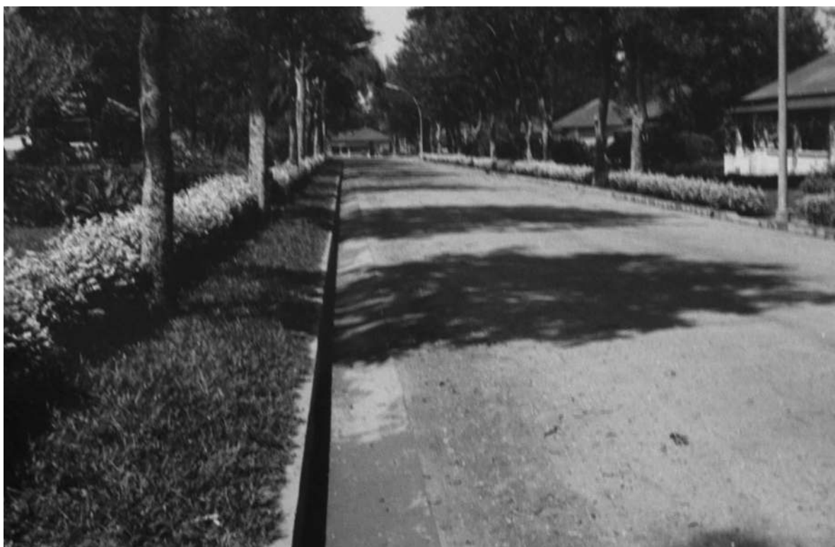
Aspecto actual do troço da rua nº 8 [Urbanização e Saneamento do Dundo, 1962. UC/AD]
