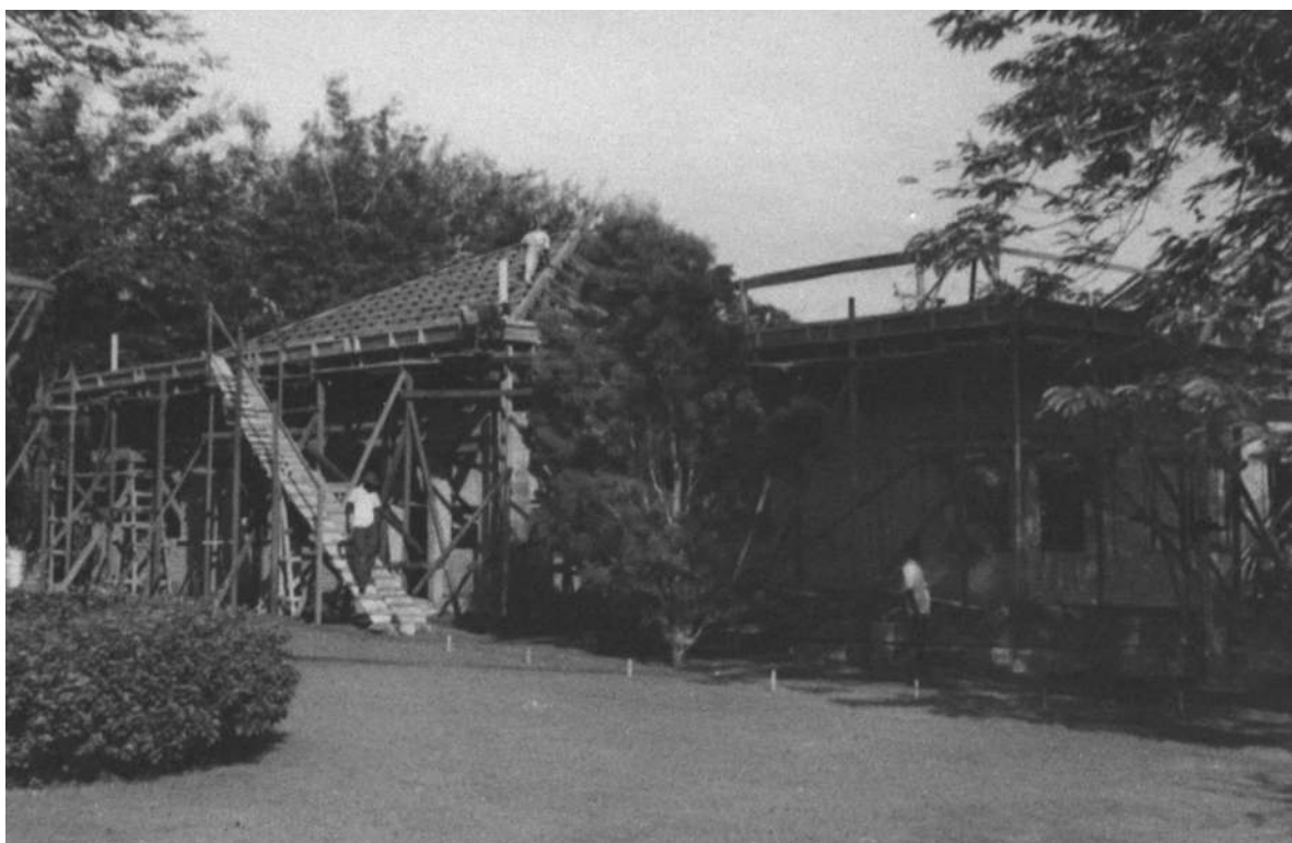
Remodelação da Casa da Representação. Aspecto das obras em curso. Fachada nascente [Construção e reparação de edifícios, 1950-53. UC/AD]
