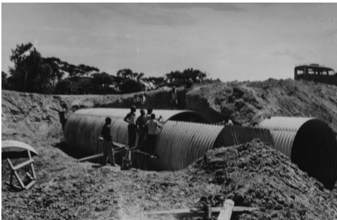
Estrada Luzamba-EN Malange/Henrique Carvalho. Montagem de um aqueduto 3x3, em tubos metálicos tipo ARMCO [Relatório Anual da DSOVC, 1967. UC/AD]
