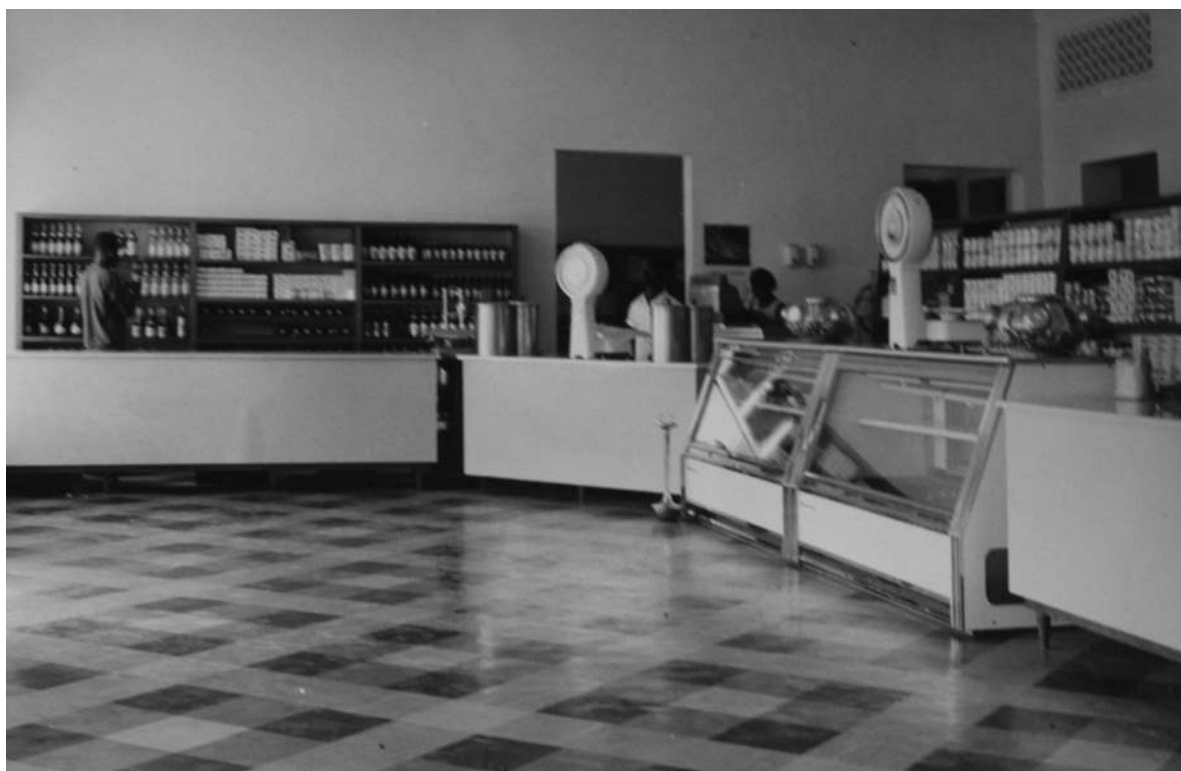
Armazém de Vendas a Europeus, em Andrada. Mercearia [Relatório do Serviço de Construção Civil, 1960-63. UC/AD]
