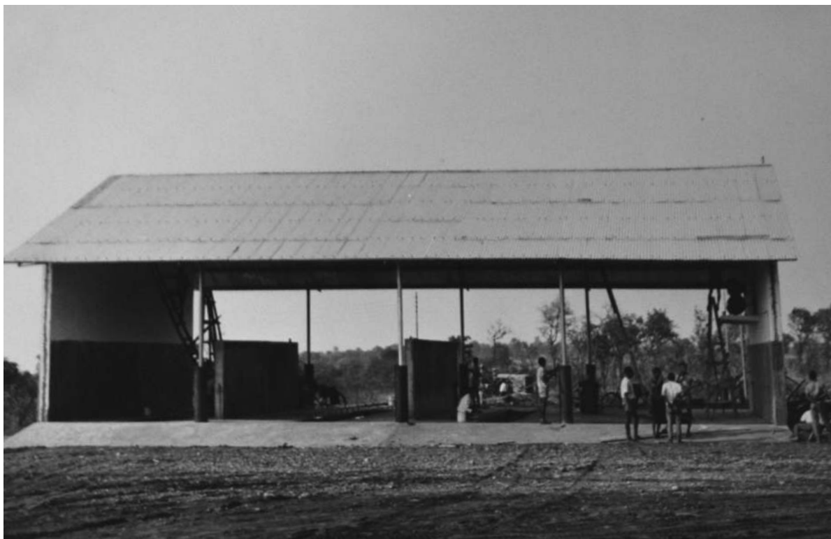
Estação de Serviço. Lucapa [Construção e Reparação de Edifícios, 1964-65. UC/AD]
