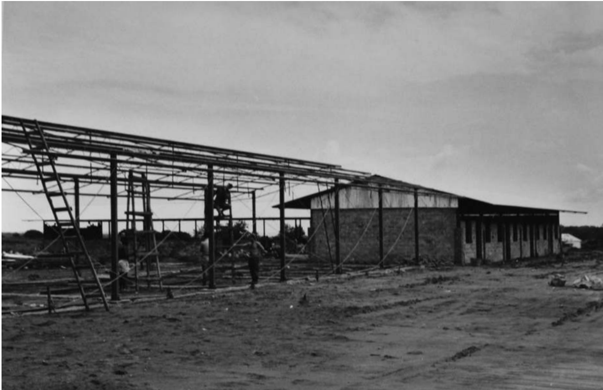
Construção de quartel MAGUE no Camaquenzo (Dundo) [Construção e Reparação de Edifícios, 1964-65. UC/AD]
