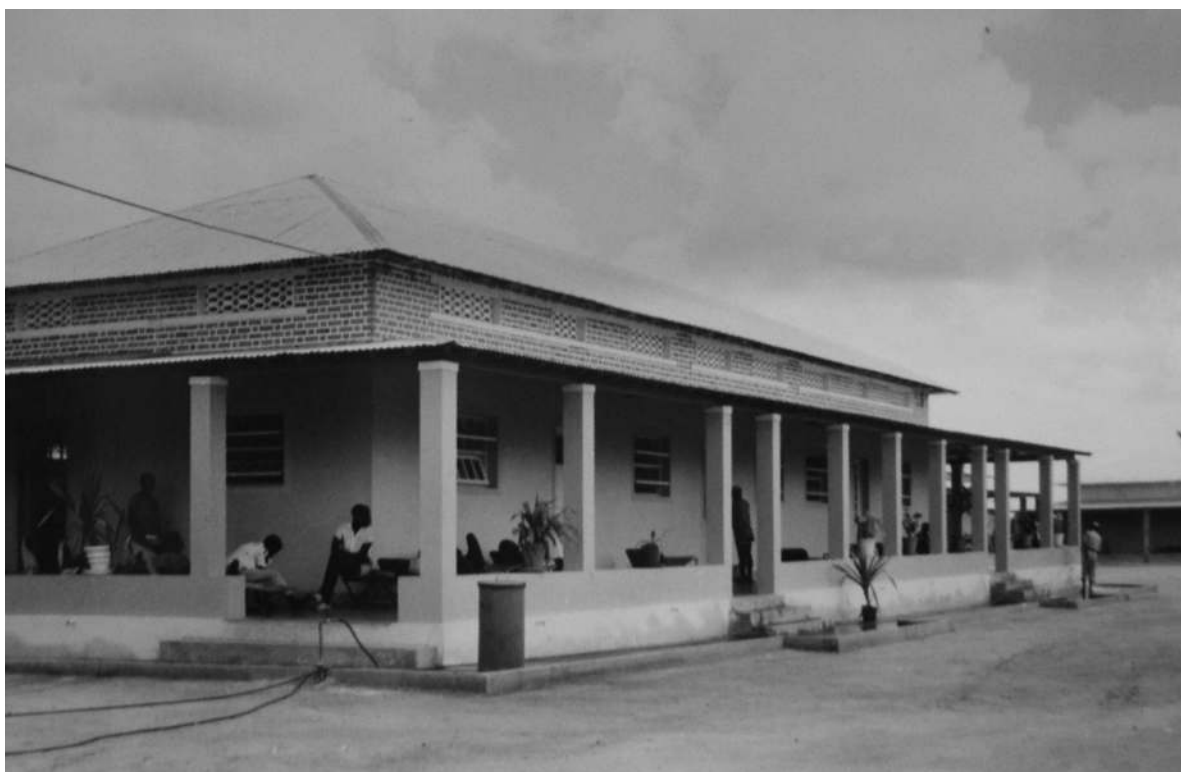
Vista de uma enfermaria para homens no Hospital-Isolamento do Sacavula [Construção e Reparação de Edifícios, 1965-66. UC/AD]
