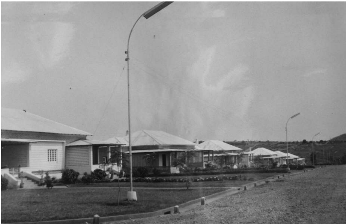
Conjunto de casas de habitação para empregados, em Andrada (concluídas) [Relatório do Serviço de Construção Civil, 1960-63. UC/AD]
