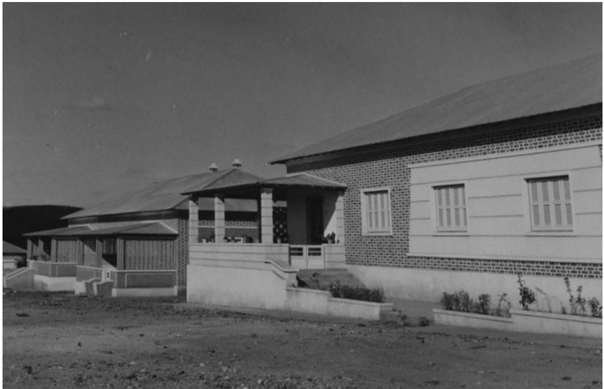
Casas geminadas para empregados em Andrada [Construção e Reparação de Edifícios, 1965-66. UC/AD]
