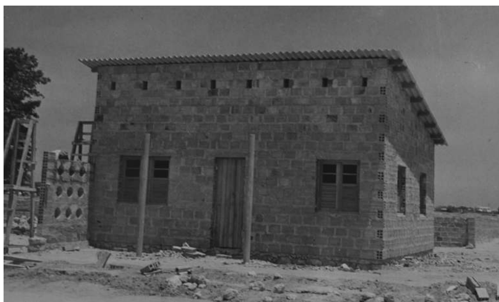
[184] Bairro indígena: Uma casa em construção (faltando-lhe ainda a varanda à frente), 1953 [Construções em Luanda, 1952-53, UC/AD]
