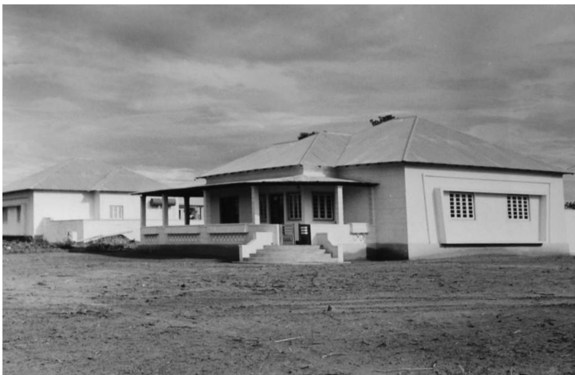
A primeira casa construída no Lucapa [Relatório do Serviço de Construção Civil, 1960-63. UC/AD]
