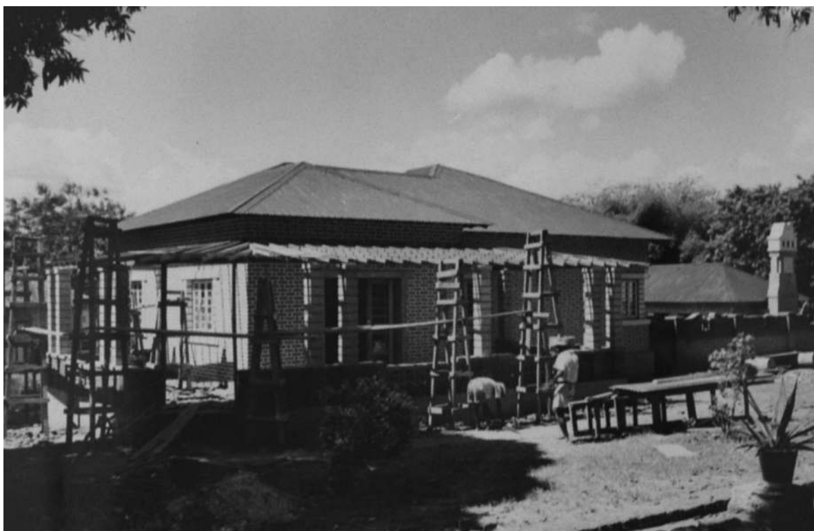
Casa de habitação K-184. Fachadas sul-poente [Construção e reparação de edifícios, 1950-53. UC/AD]
