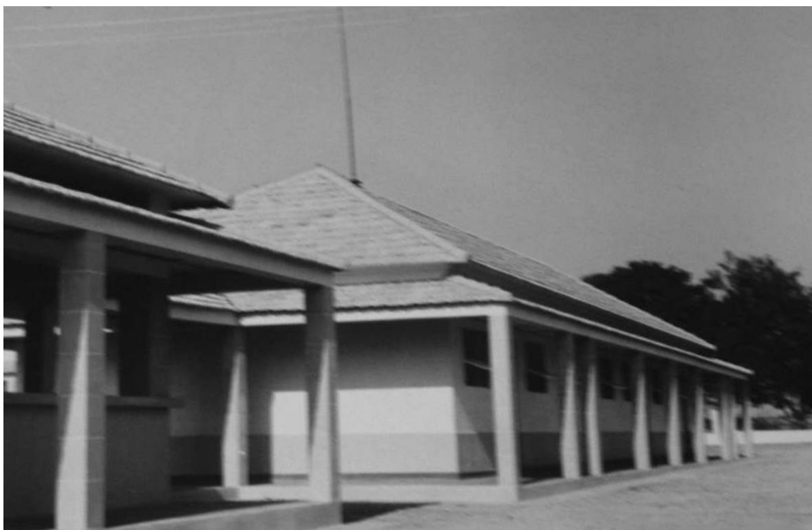
Instalações para trabalhadores em trânsito, Nova Gaia. Aspecto de uma cozinha e de uma camarata [Construção e Reparação de Edifícios, 1964-65. UC/AD]
