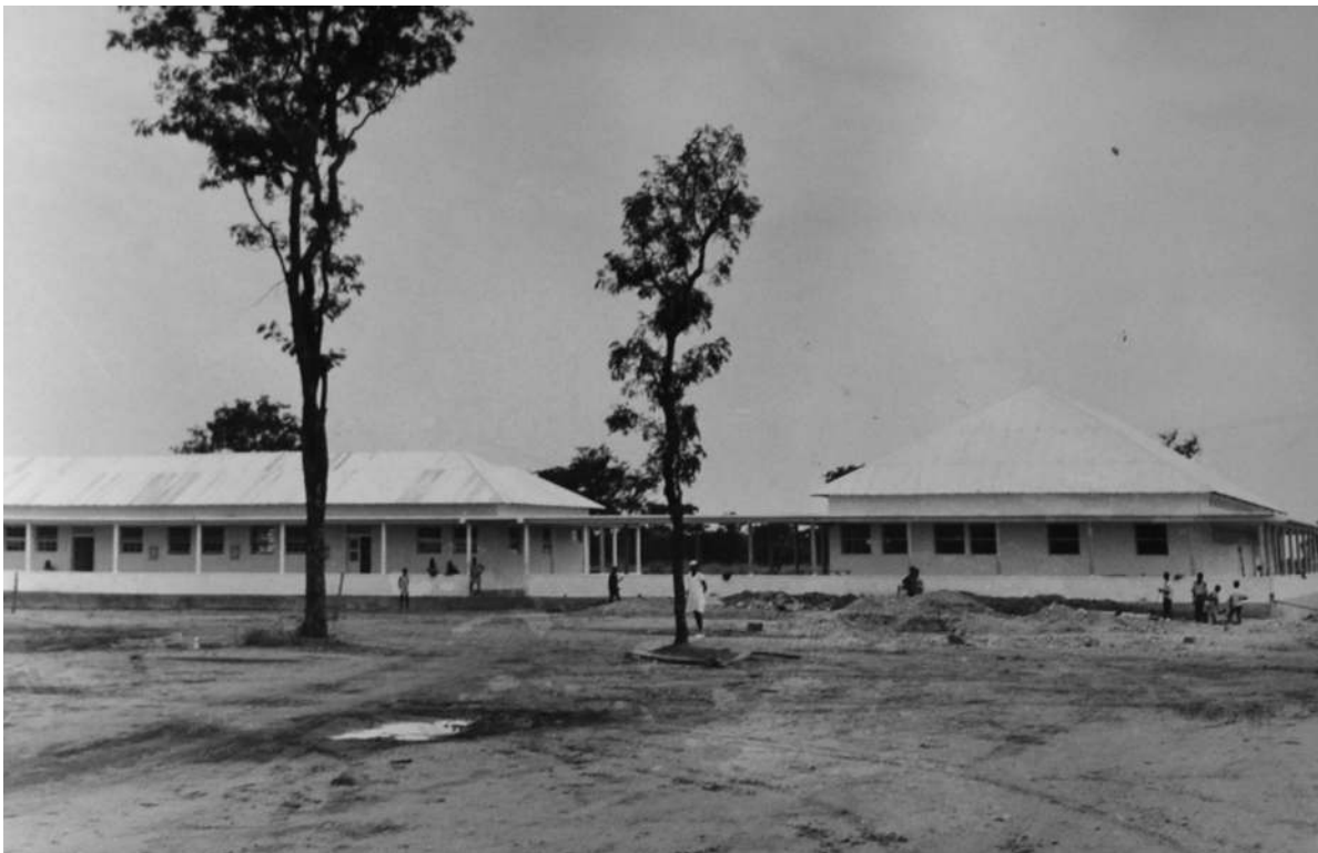
Bloco Hospitalar do Calonda. Refeitório (dir.) e uma das enfermarias [Relatório dos Serviços de Construção Civil, 1960-63. UC/AD]
