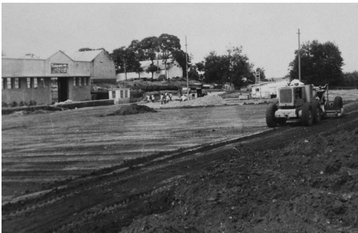
Parque de materiais dos novos armazéns [Urbanização e Saneamento do Dundo, 1963-64. UC/AD]
