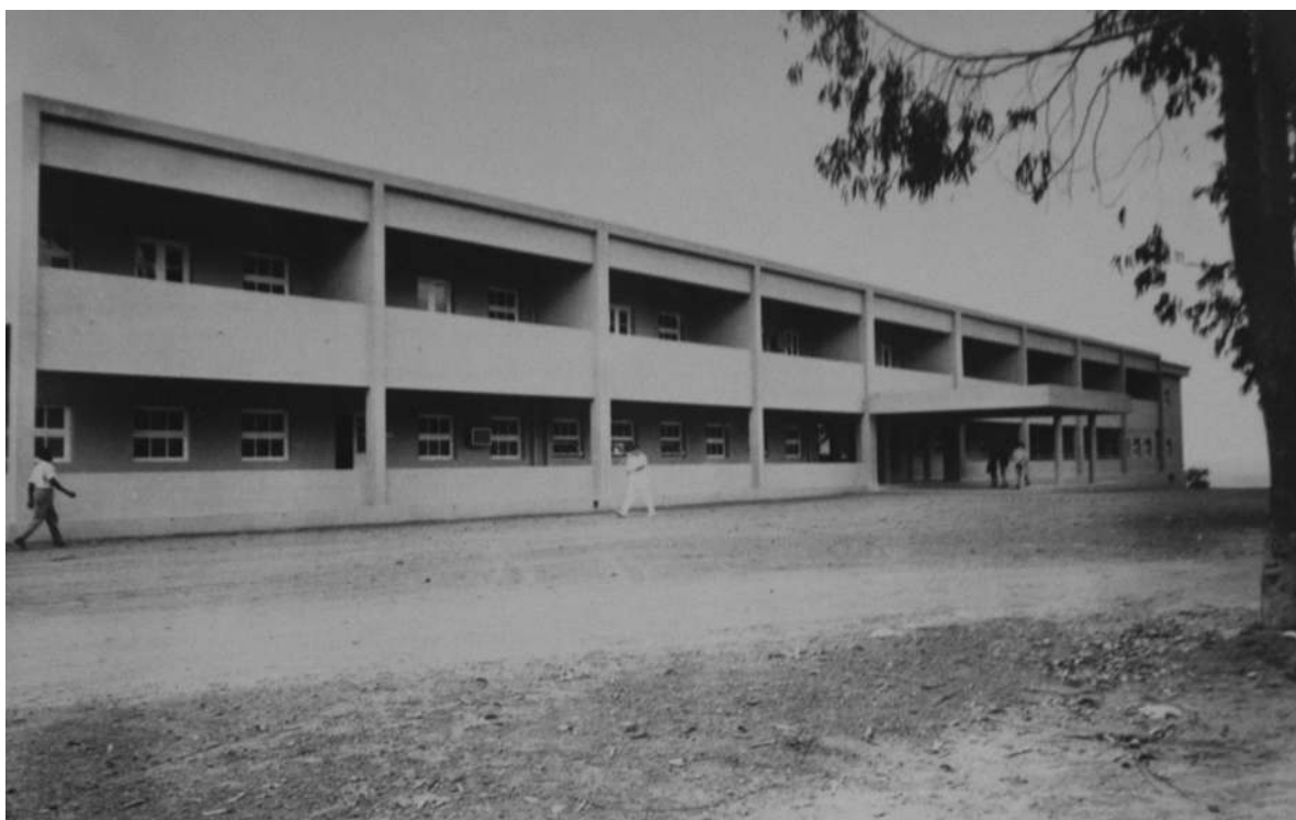
A fachada principal do bloco central do Hospital do Lucapa [Serviços de Saúde, 1972. UC/AD]
