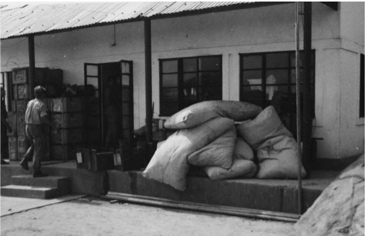
Aspetos da ocupação das instalações [Urbanização e Saneamento do Dundo, 1962. UC/AD]
