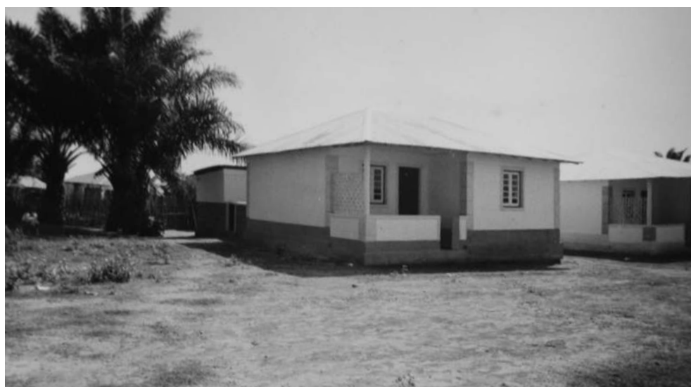
[220] Algumas das casas demolidas, 1973
