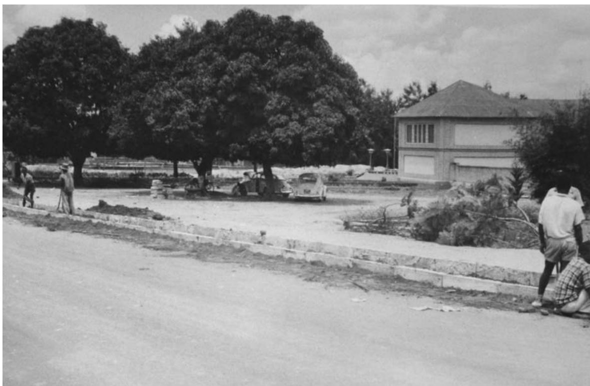
Levantamento do piso de um troço da rua nº 13, frente ao Museu, para se conseguir melhor drenagem [Urbanização e Saneamento do Dundo, 1962. UC/AD]
