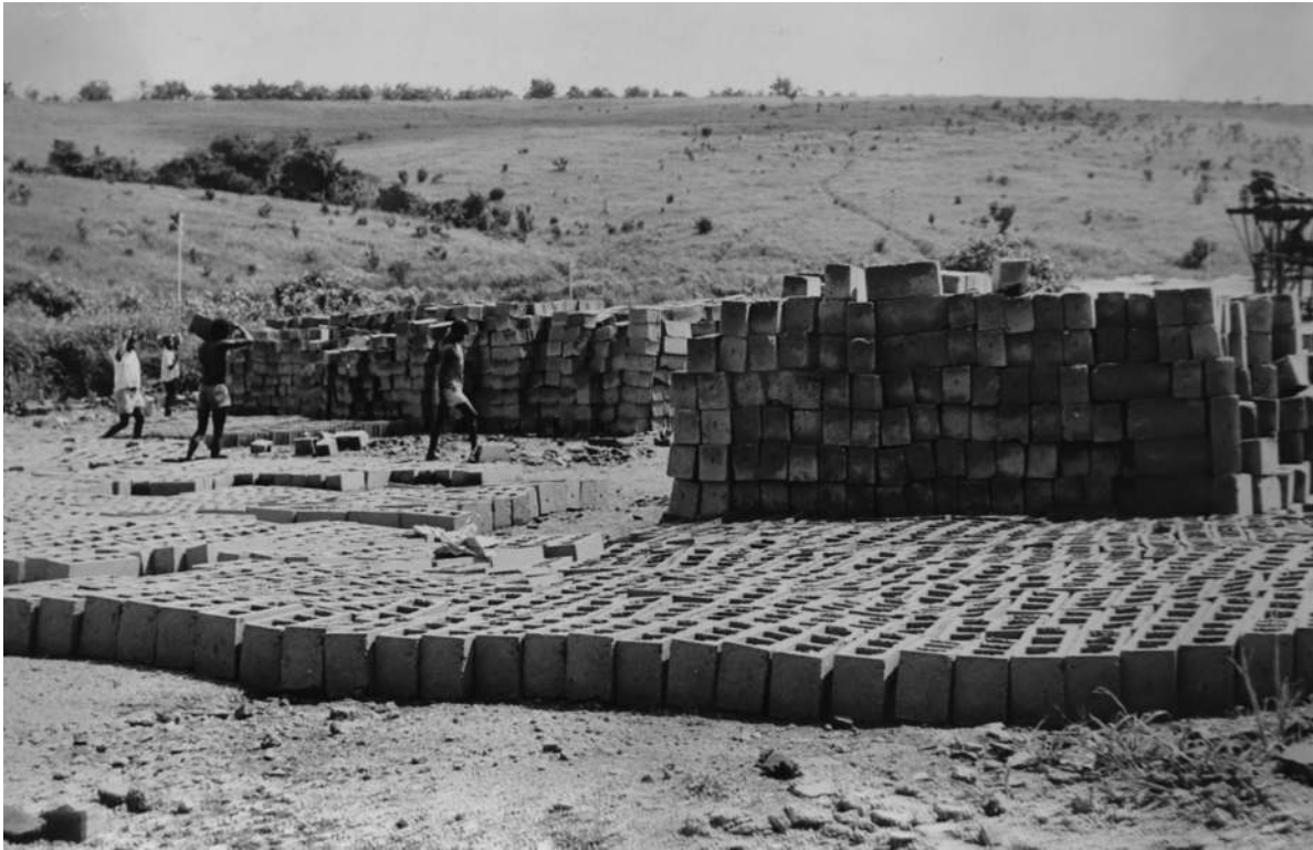
Fábrica de blocos em cimento. Reserva de blocos em cimento [Relatório da SPAMOI, 1961. UC/AD]
