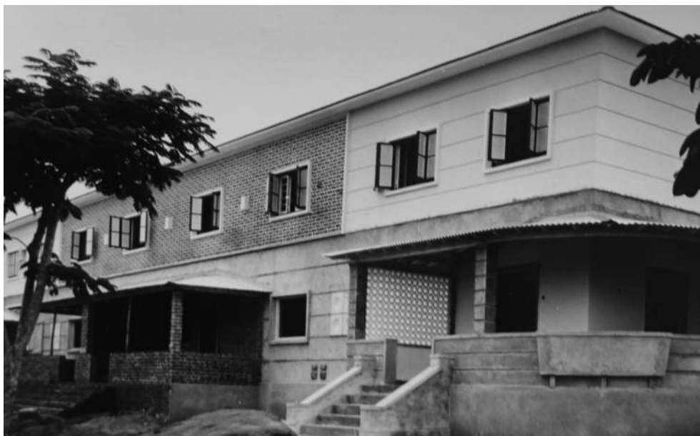
[160] Dundo: Blocos de habitação, de rés-do-chão e 1º andar, K-368, 1970 [Relatório Anual da DSOVC, UC/AD]
