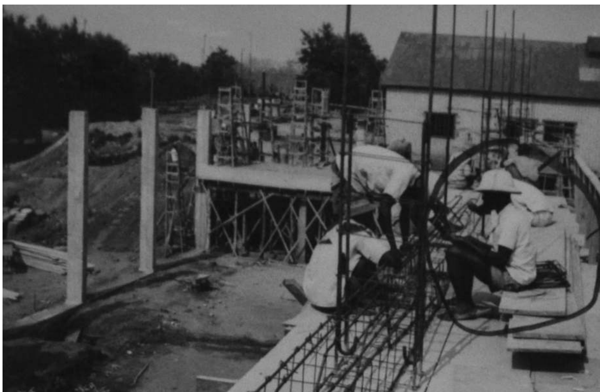
Oficina Geral de Mecânica. “Hall de montagem”. Aspecto das obras em curso (nota manuscrita, com balão que circunda trabalhador: “curioso”) [Construção e reparação de edifícios, 1950-53. UC/AD]
