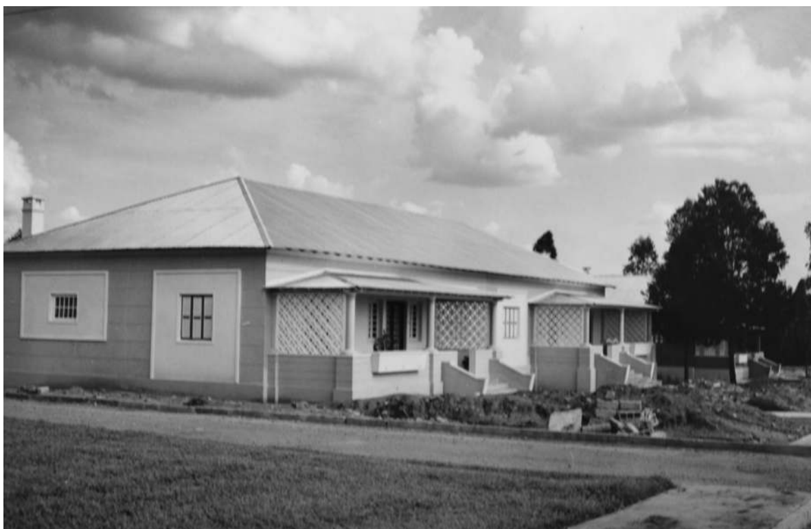
Casa de habitação, simples, de 3 quartos, para empregados K-71 [Relatório Anual da DSOVC, 1967. UC/AD]
