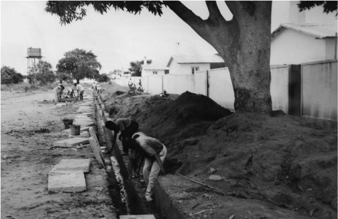
Urbanização do Bairro Sul. Construção de um dreno subterrâneo na traseira das habitações [Relatório Anual da Concessão do Dundo, 1964. UC/AD]
