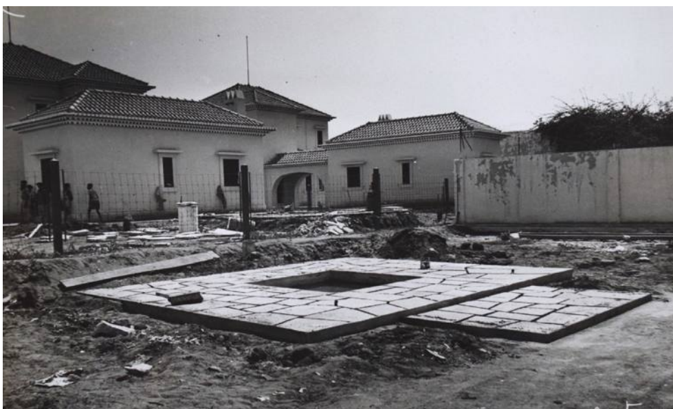
[179] Bairro residencial em Miramar (em construção), vista de conjunto, 1953 [180] Fachada principal da Casa tipo 3, depois de concluída, 1953 [181] Pátios e jardins interiores: zona do lago (em construção), 1954 [Construções em Luanda, 1952-54, UC/AD]
