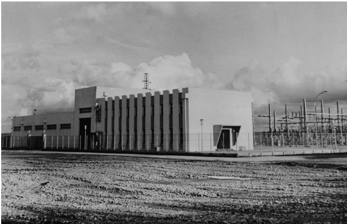
Subestação de Andrada II. Vista parcial do conjunto [Relatório Anual da DSOVC, 1967. UC/AD]
