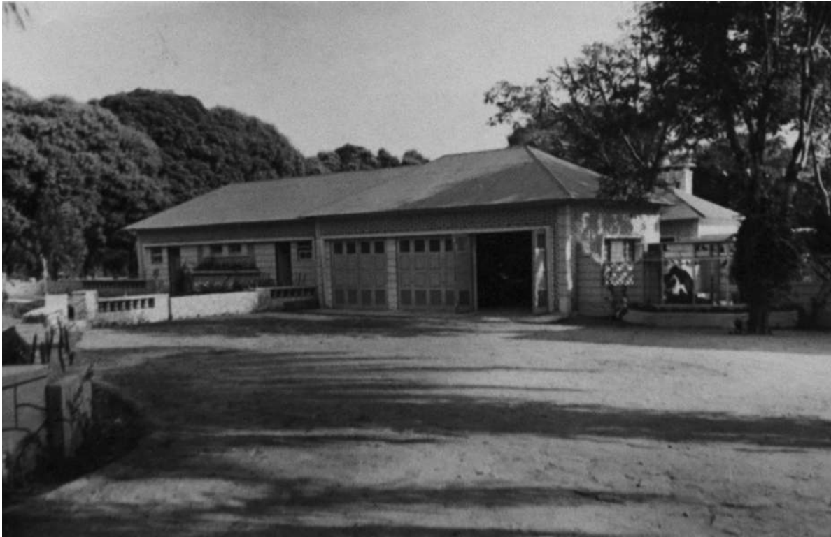
Casa da Representação e os novos anexos. Fachadas nascente e sul [Construção e reparação de edifícios, 1950-53. UC/AD]
