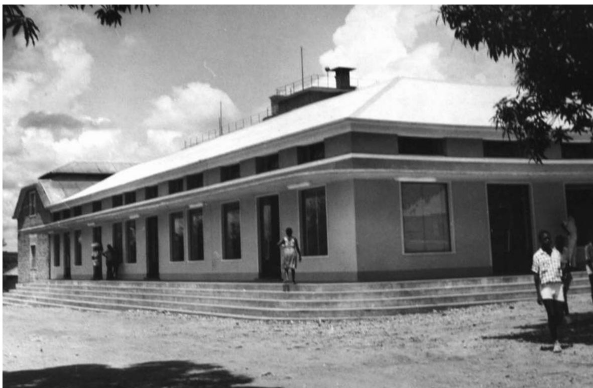
Armazéns de Vendas a Europeus em Andrada (fachada nascente) [Relatório do Serviço de Construção Civil, 1960-63. UC/AD]
