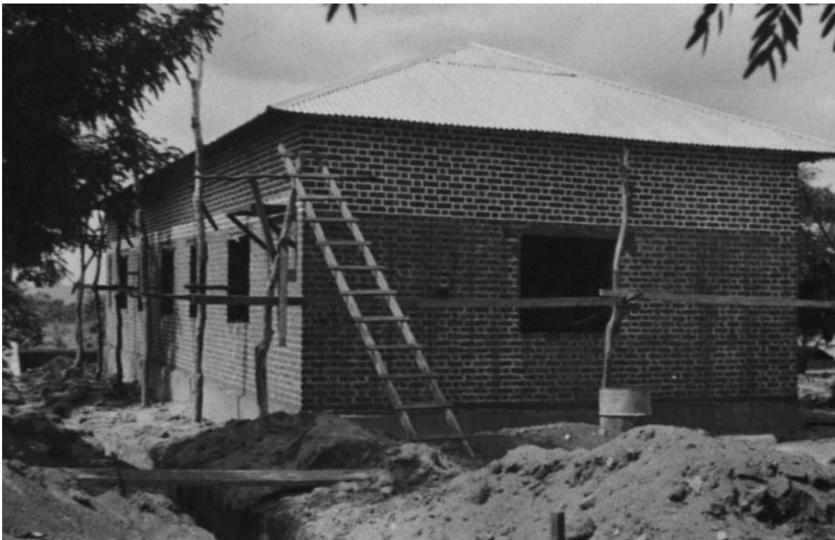
Sombo. Aspecto da construção da enfermaria do Hospital-Dispensário [Construção e Reparação de Edifícios, 1950-53.UC/AD]
