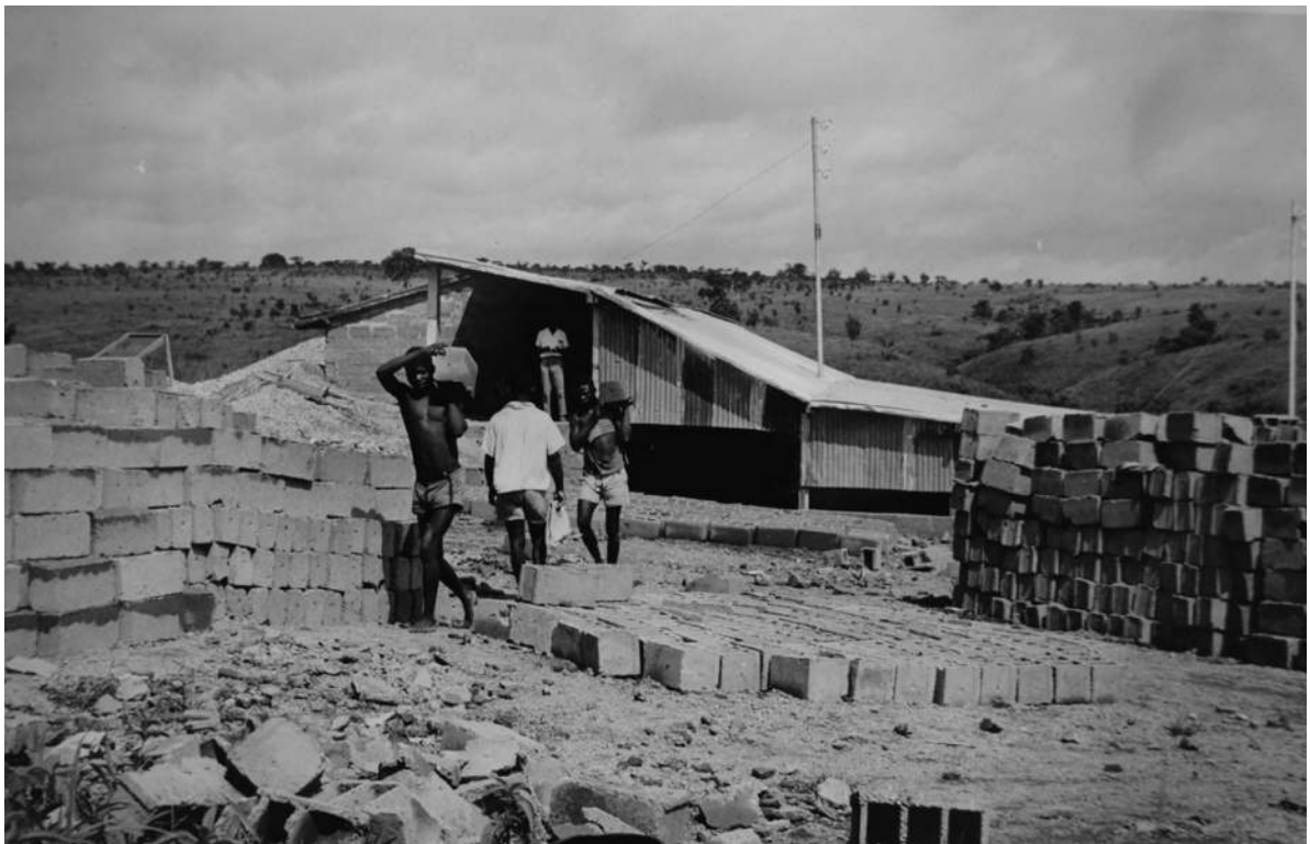
Fábrica de blocos em cimento. Empilhando os blocos que irão servir para novas construções [Relatório da SPAMOI, 1961. UC/AD]
