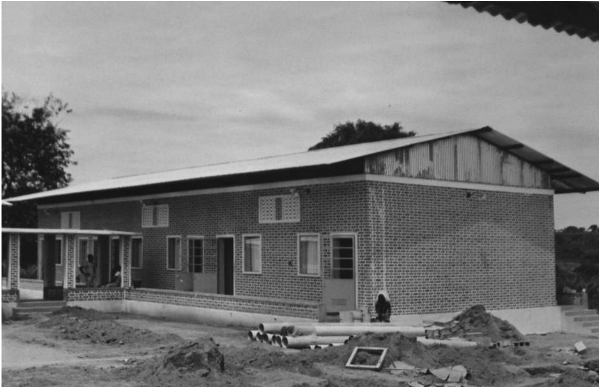
Hospital Isolamento do Sacavula (Dundo). Um aspecto da nova enfermaria [Construção e Reparação de Edifícios, 1964-65. UC/AD]
