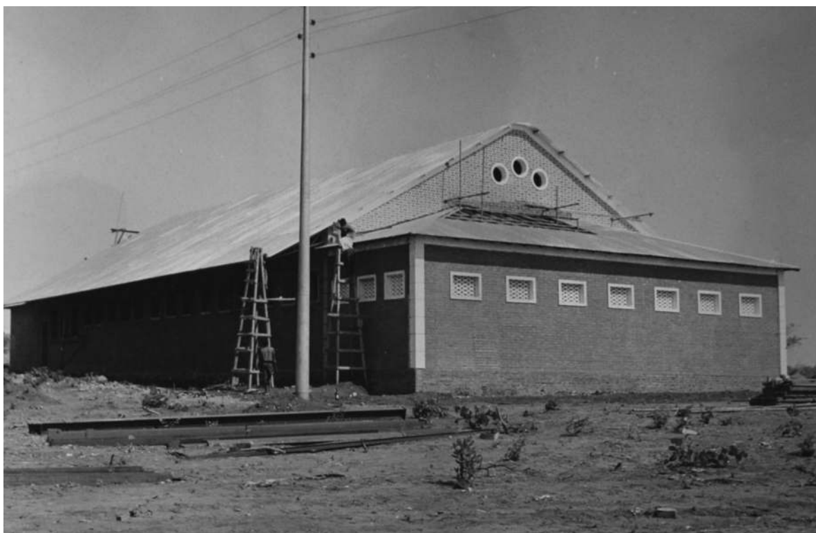
Aquartelamento do Cacanda [Construção e Reparação de Edifícios, 1964-65. UC/AD]
