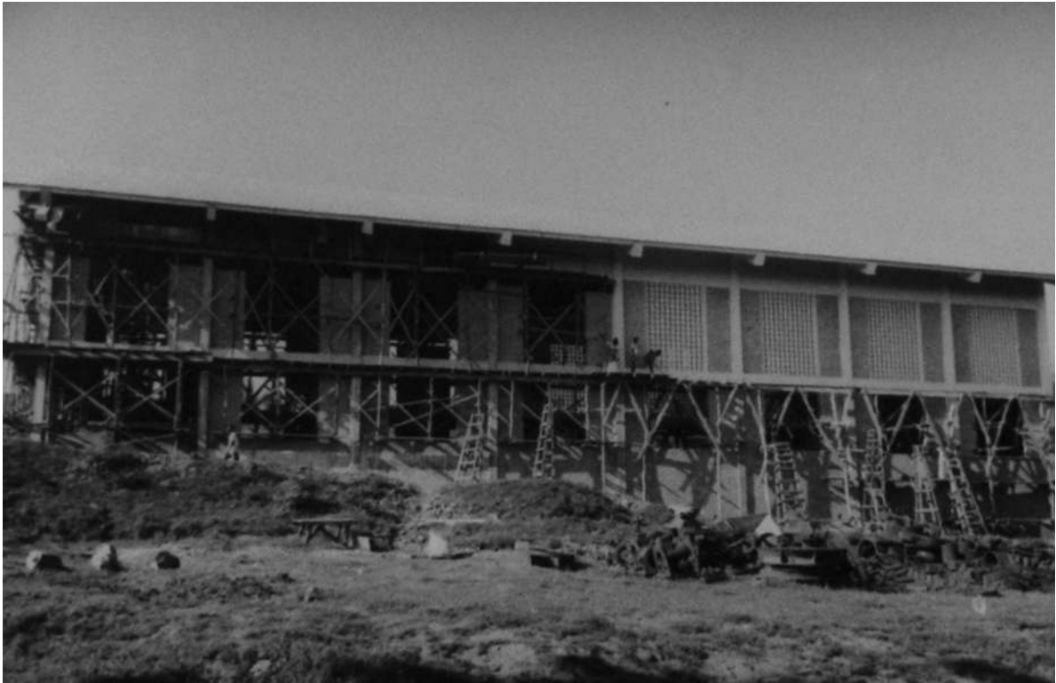
“Hall” de montagem. Fachada do lado norte [Construção e reparação de edifícios, 1950-53. UC/AD]
