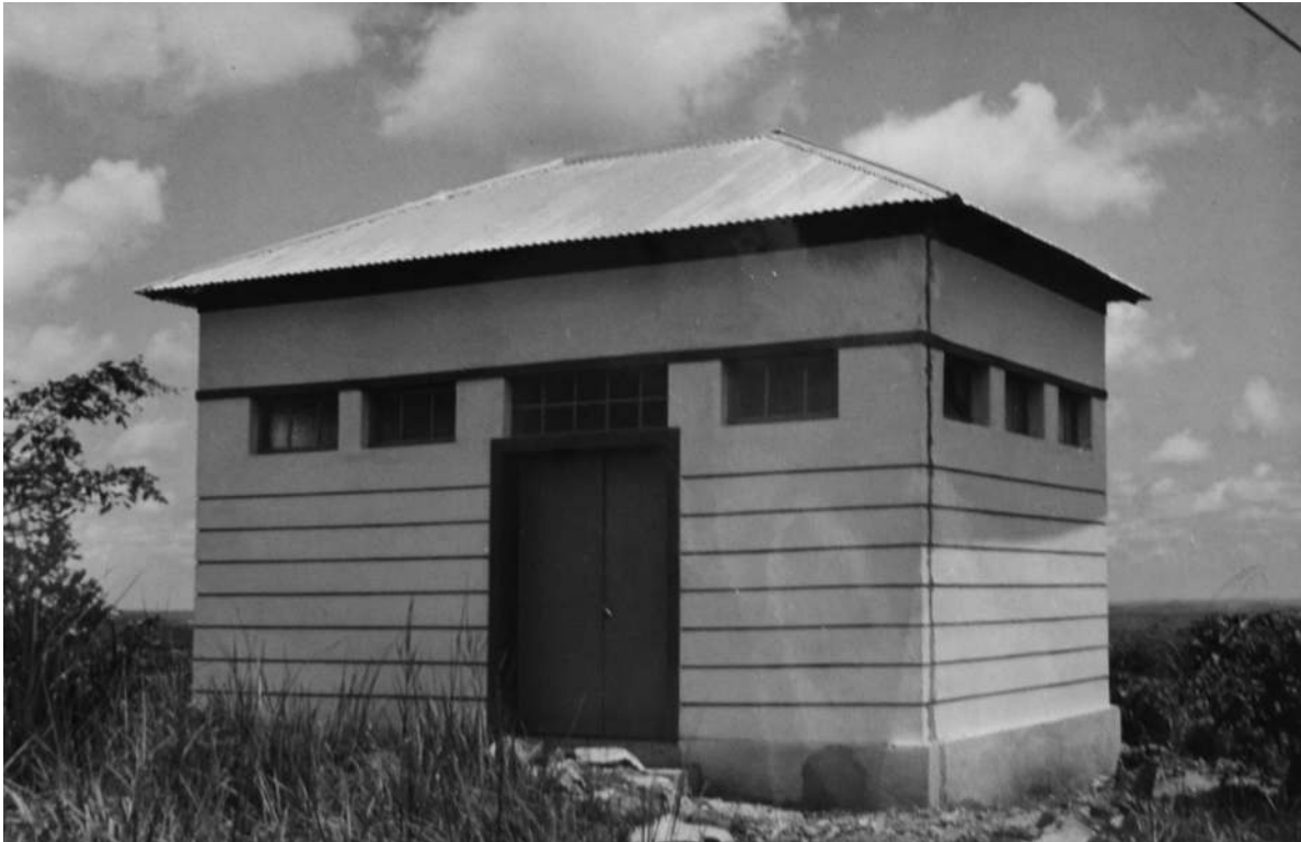
Emissor da Bela Vista, em Andrada [Relatório do Serviço de Construção Civil, 1960-63. UC/AD]
