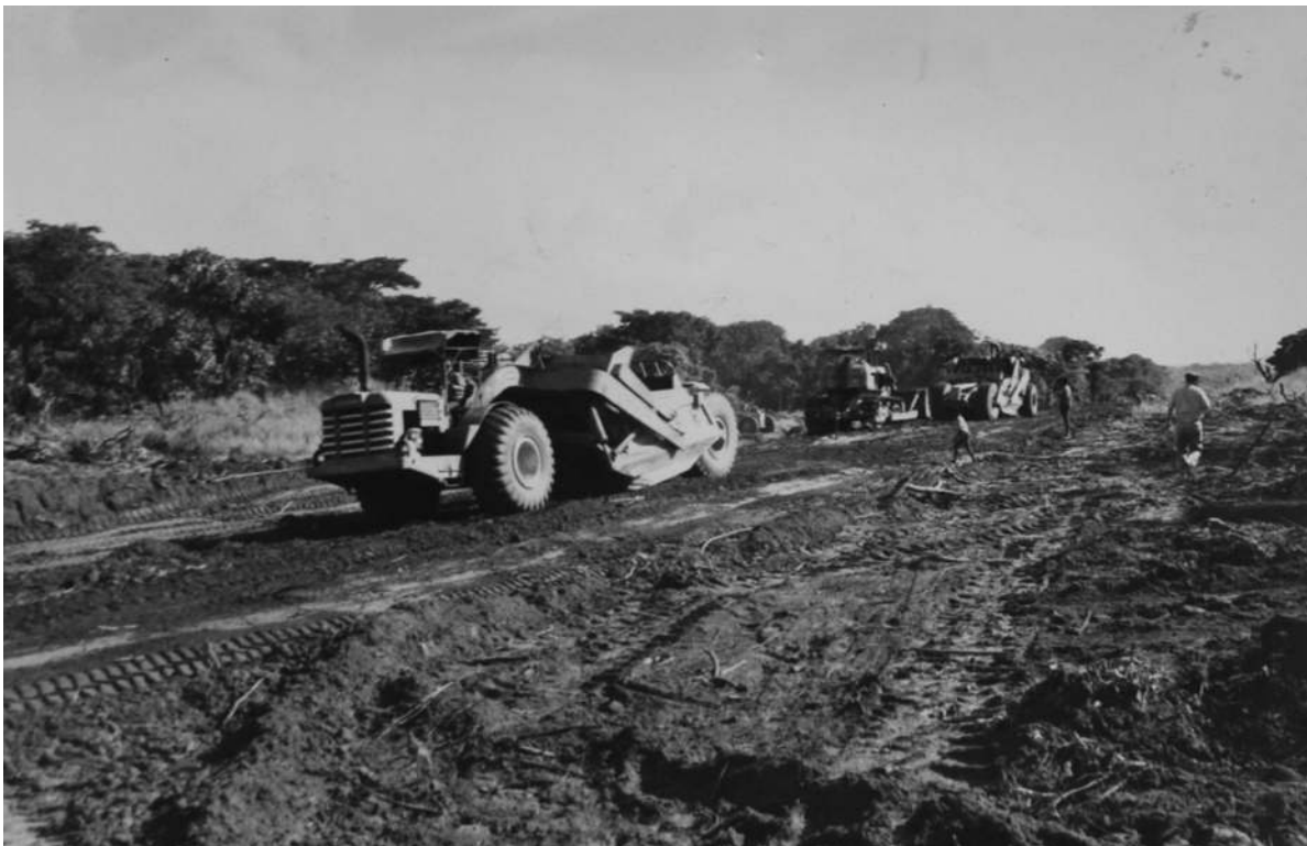
Estrada Luzamba-EN Malange/Henrique Carvalho. Mortocrapers em execução das terraplanagens [Relatório Anual da DSOVC, 1967. UC/AD]
