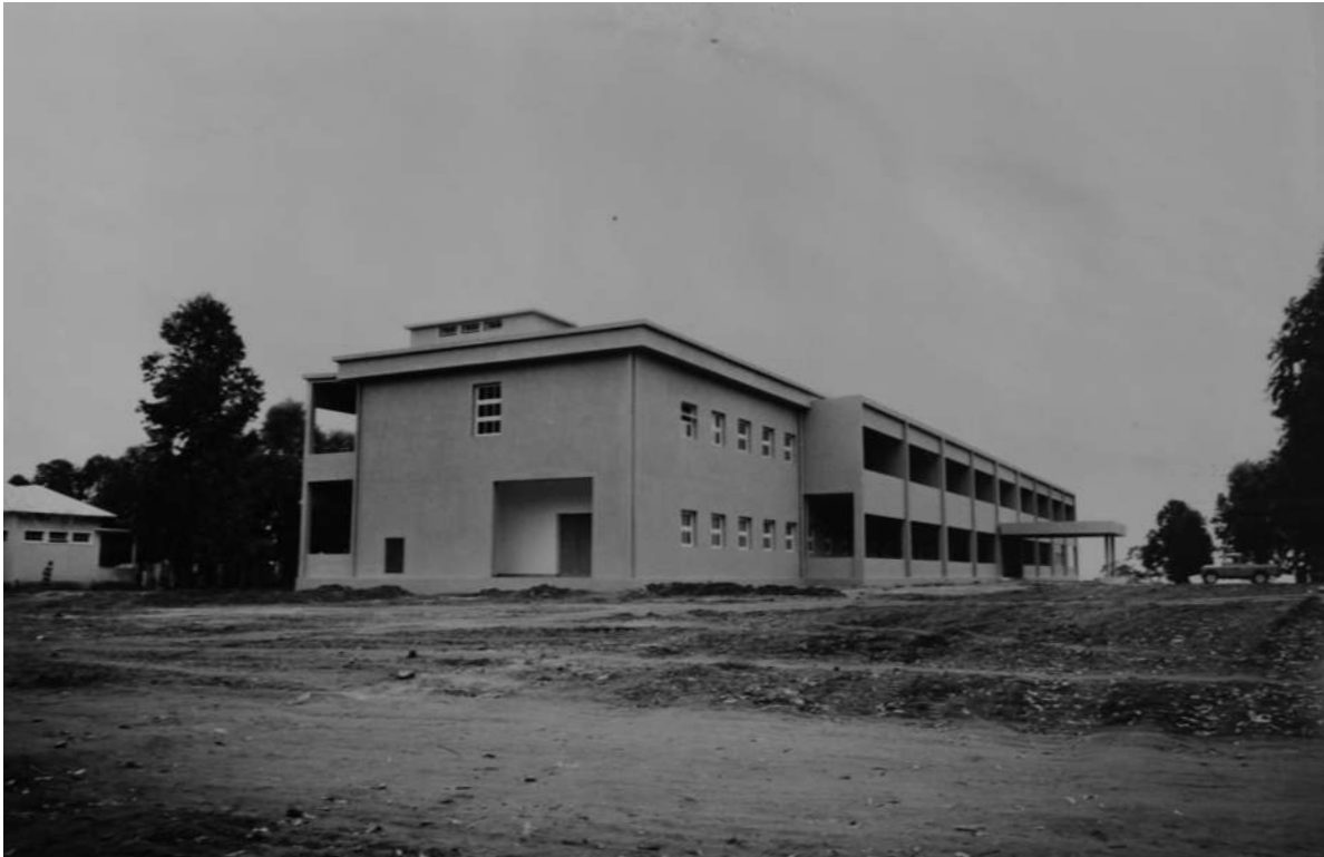
Bloco principal do Hospital do Lucapa. Fachadas principal e lateral direita [Serviços de Saúde, 1970. UC/AD]
