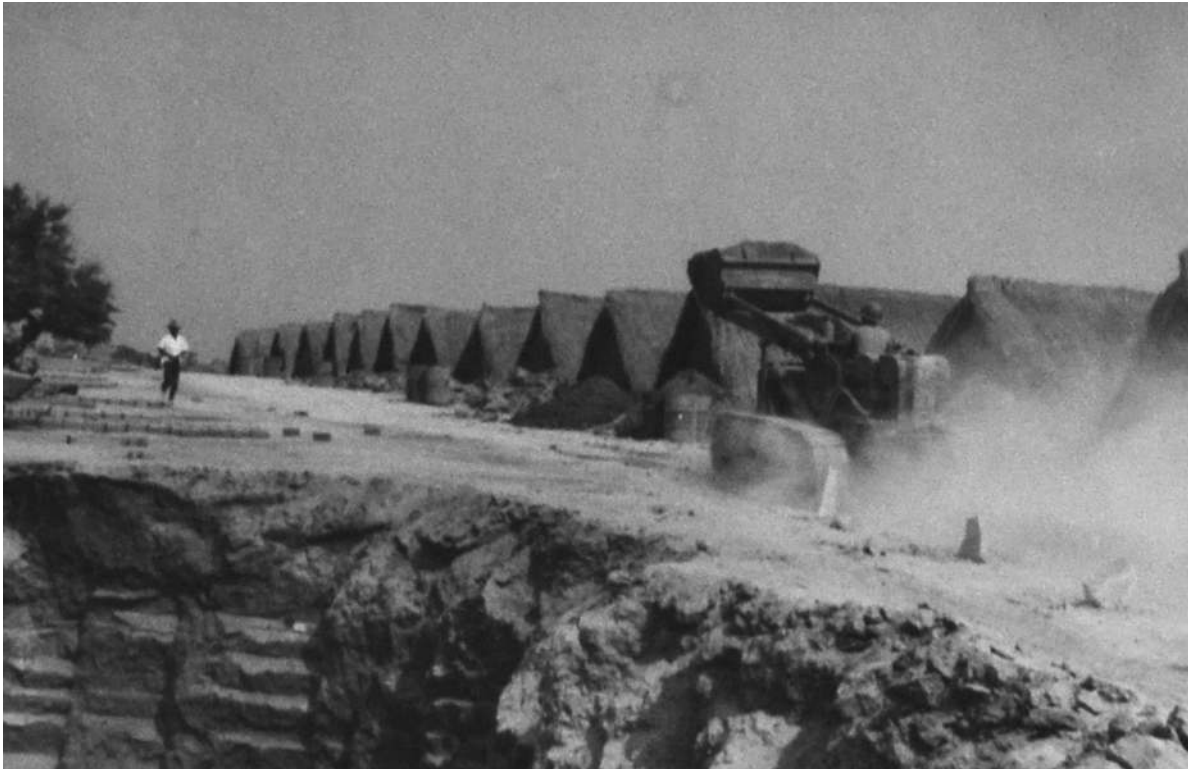
Tijolaria do Dundo. Utilização de uma “dozer-shovel” no desmonte e transporte de argila para campos de montagem [Relatório das Construções, 1955. UC/AD]
