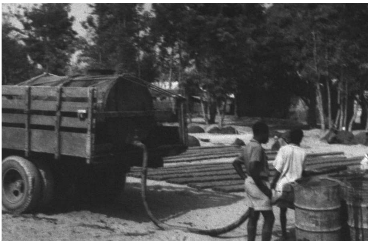
Tijolaria do Dundo. Abastecimento de água e preparação de argila para moldar [Relatório das Construções, 1955. UC/AD]
