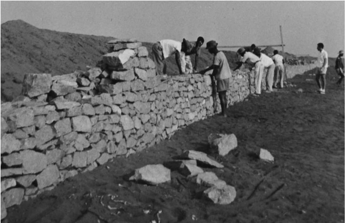
Aspecto do muro em adiantado estado de construção [Urbanização e Saneamento do Dundo, 1962. UC/AD]
