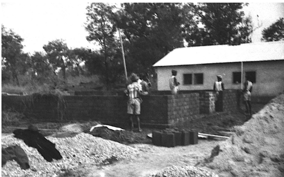
[131] Experiências com blocos de terra na aldeia do Chilupuca [Relatório das Construções, 1954. UC/AD]
