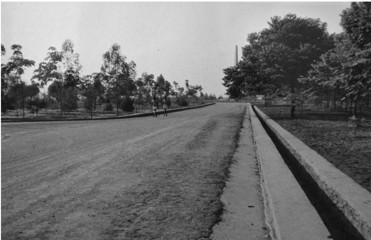
Drenagem e consolidação da rua nº 30 (extremo sul do Dundo) [Urbanização e Saneamento do Dundo, 1962. UC/AD]
