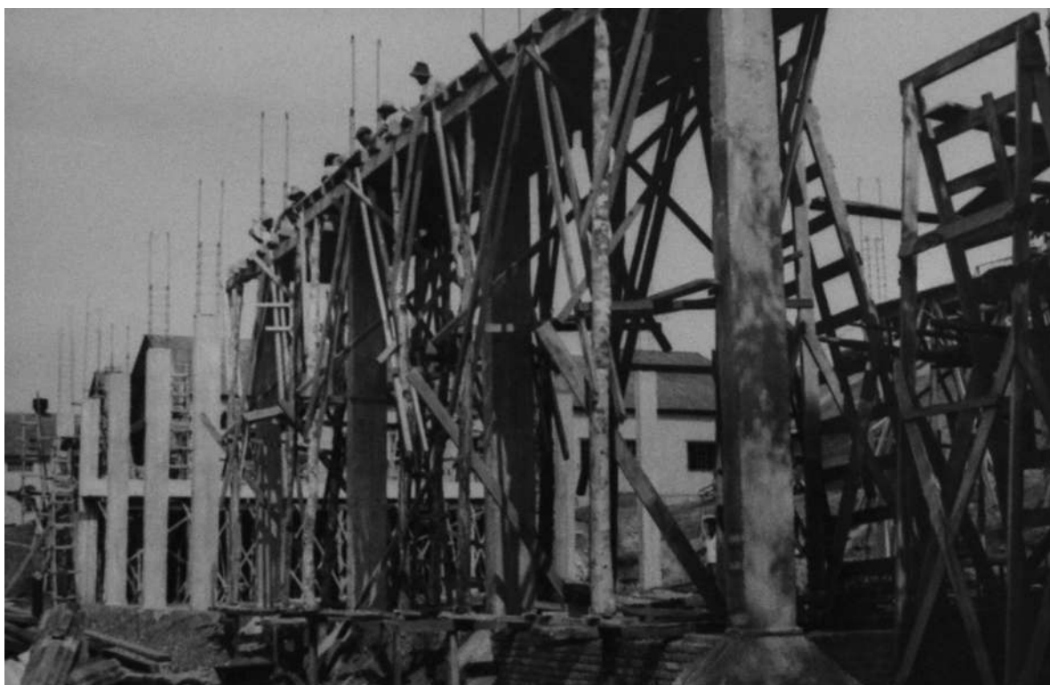
Oficina Geral de Mecânica. “Hall de montagem”. Aspecto das obras em curso [Construção e reparação de edifícios, 1950-53. UC/AD]
