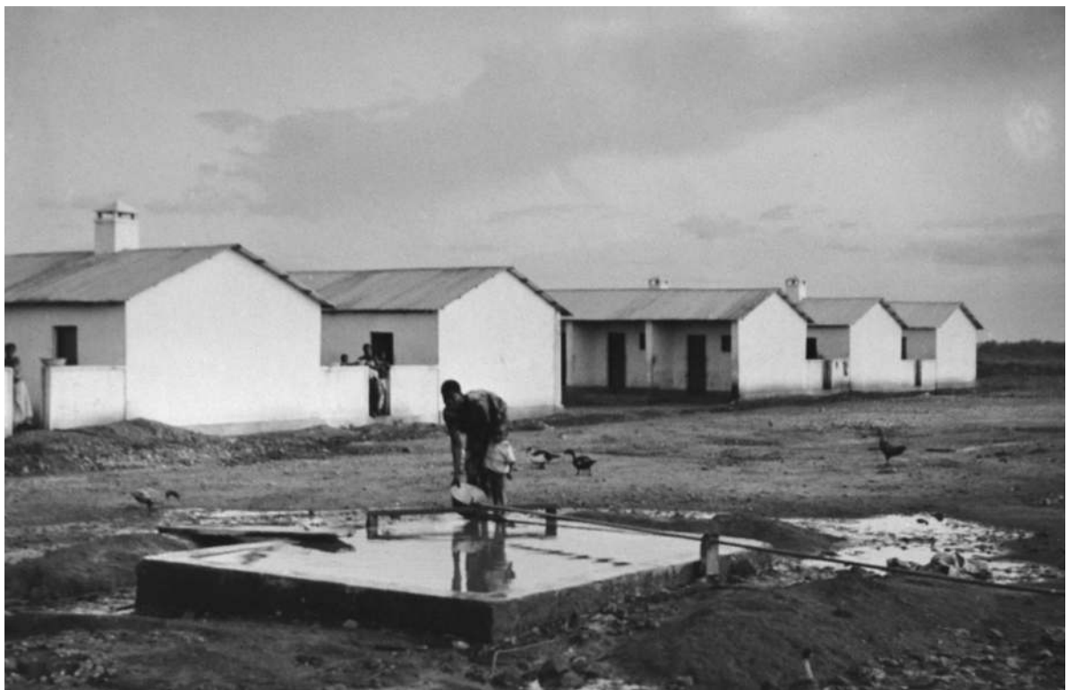
Bairro para trabalhadores no Caingági: aspecto dos blocos de oito habitações [Relatório Anual do Serviço de Construção Civil, 1960-63. UC/AD]
