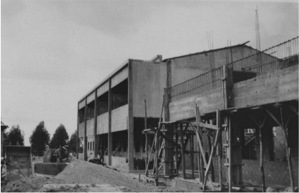
Uma fase de construção do bloco central do Hospital do Lucapa (fevereiro de 1970). A futura fachada principal [Serviços de Saúde, 1970. UC/AD]
