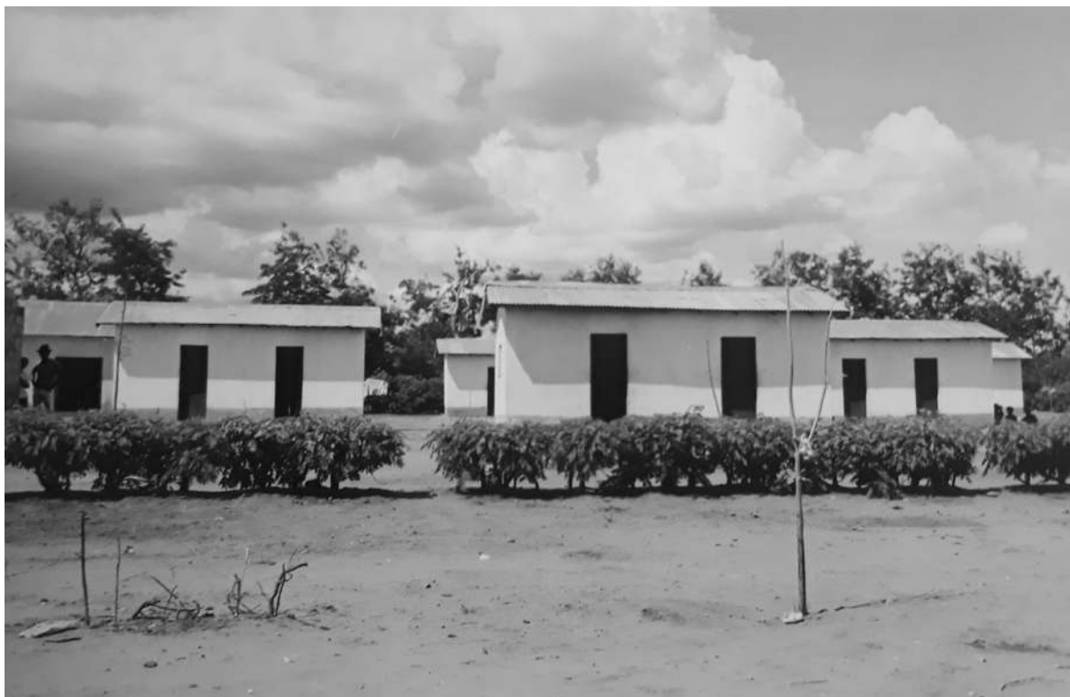
Casas de tipo tradicional, remodeladas [Relatório Anual da SPAMO, 1966. UC/AD]
