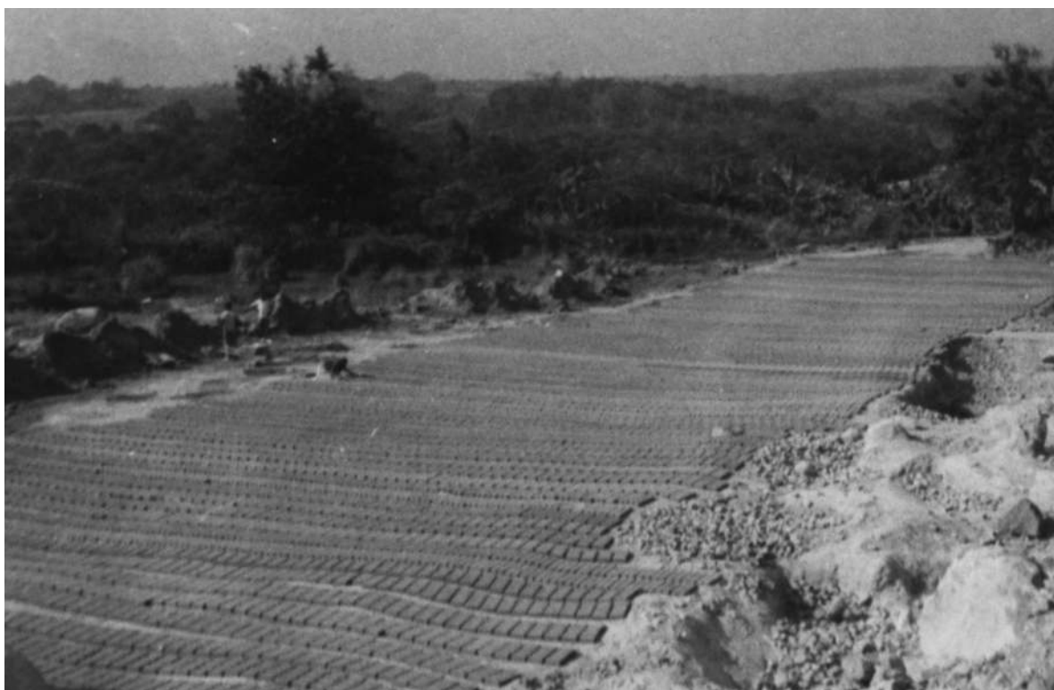
Tijolaria do Dundo. Campos de moldagem, depois de acabadas as tarefas [Construções Luanda, 1950-1951. UC/AD]
