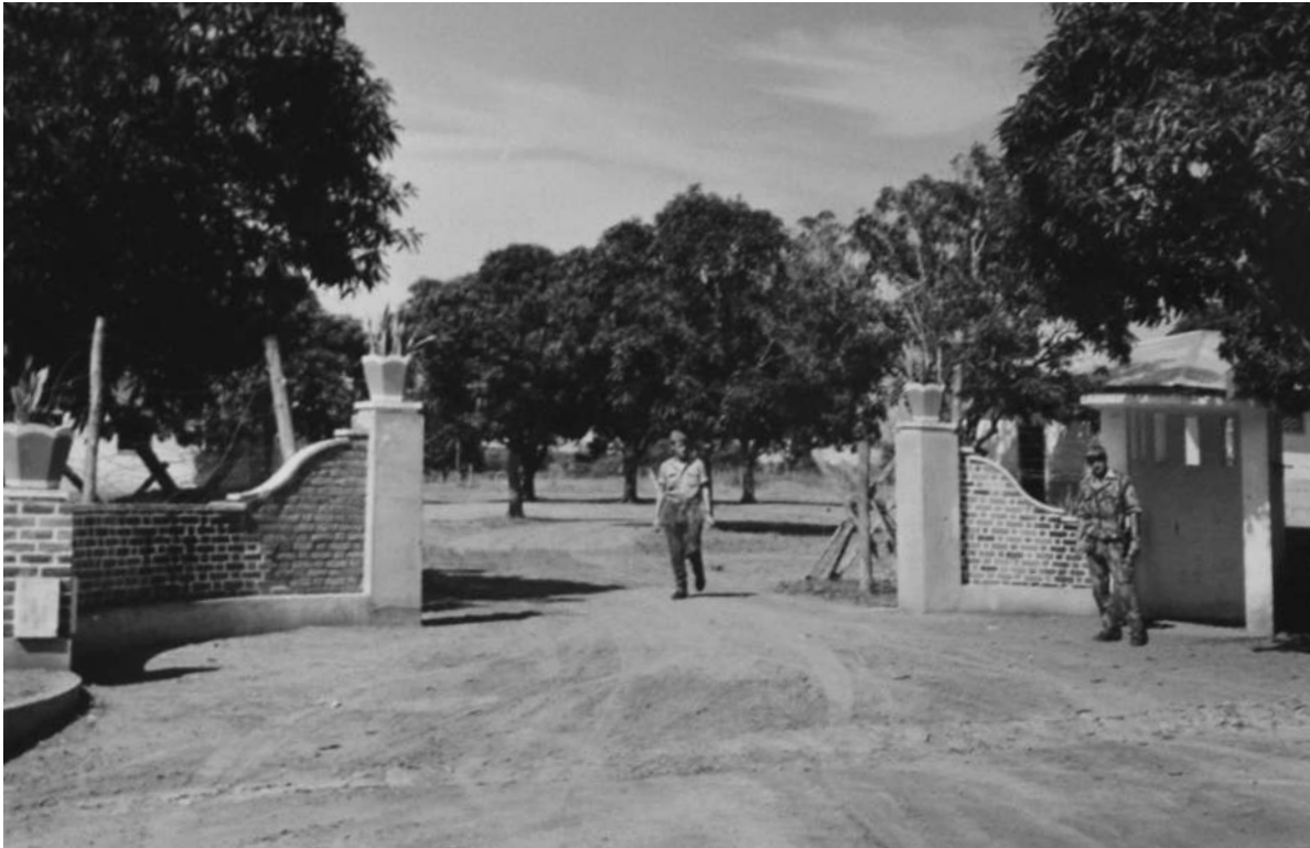
Acartelamento de Portugália. Porta de Armas [Construção e Reparação de Edifícios, 1964-65. UC/AD]
