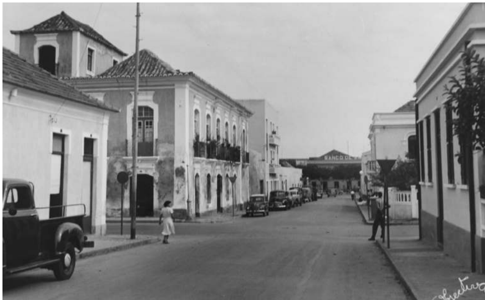
[192] Casa adquirida pela Diamang na Rua de Avelino Dias (antes do restauro) [Construções em Luanda, 1954, UC/AD]
