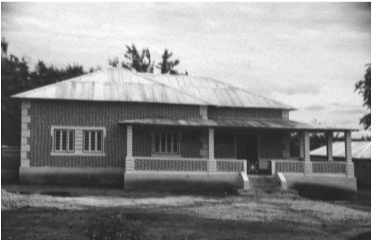
Casa de habitação nº 117. Fachada sul [Construção e Reparação de Edifícios, 1950-53. UC/AD]
