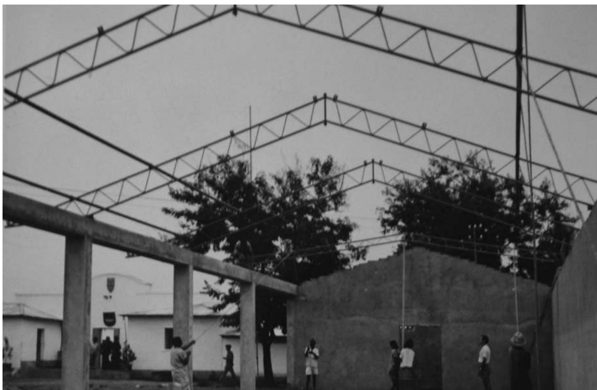
Aquartelamento de Portugália. Construção do parque automóvel [Construção e Reparação de Edifícios, 1964-65. UC/AD]
