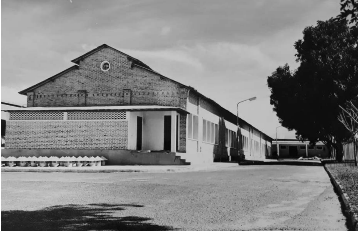
Aspectos da urbanização na Reserva Agrícola da Cacanda [Relatório Anual da Concessão do Dundo, 1971. UC/AD]
