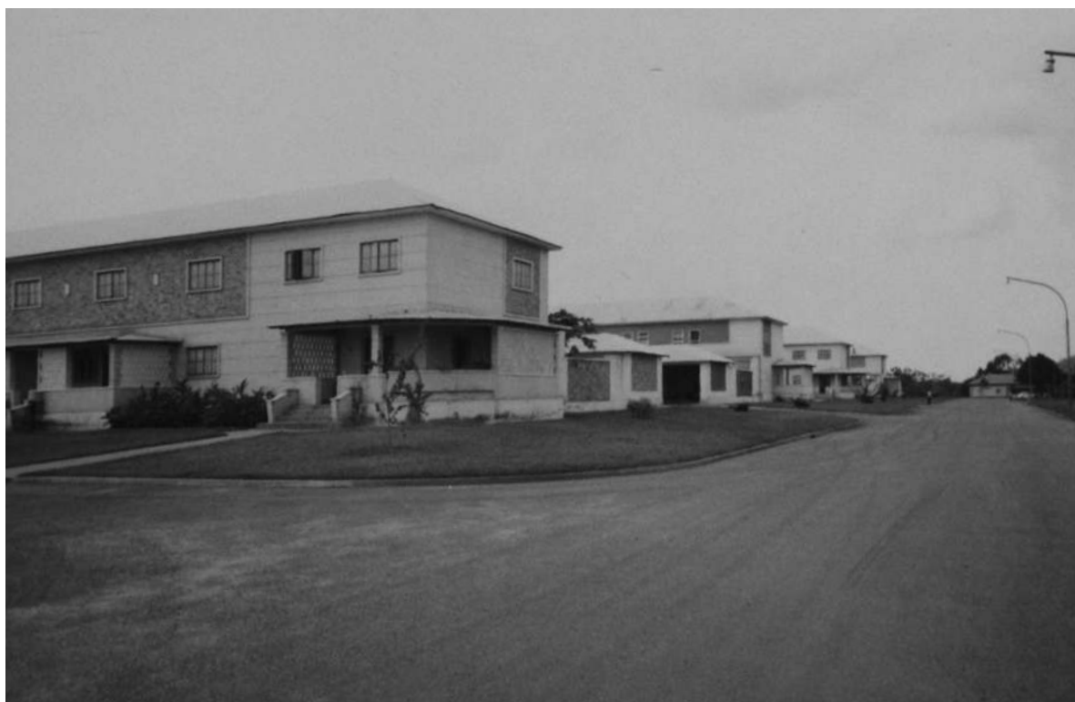
Bairro de 1º andar construído em frente às Oficinas de Manutenção de Engenhos [Urbanização e Saneamento da Lunda, 1971. UC/AD]
