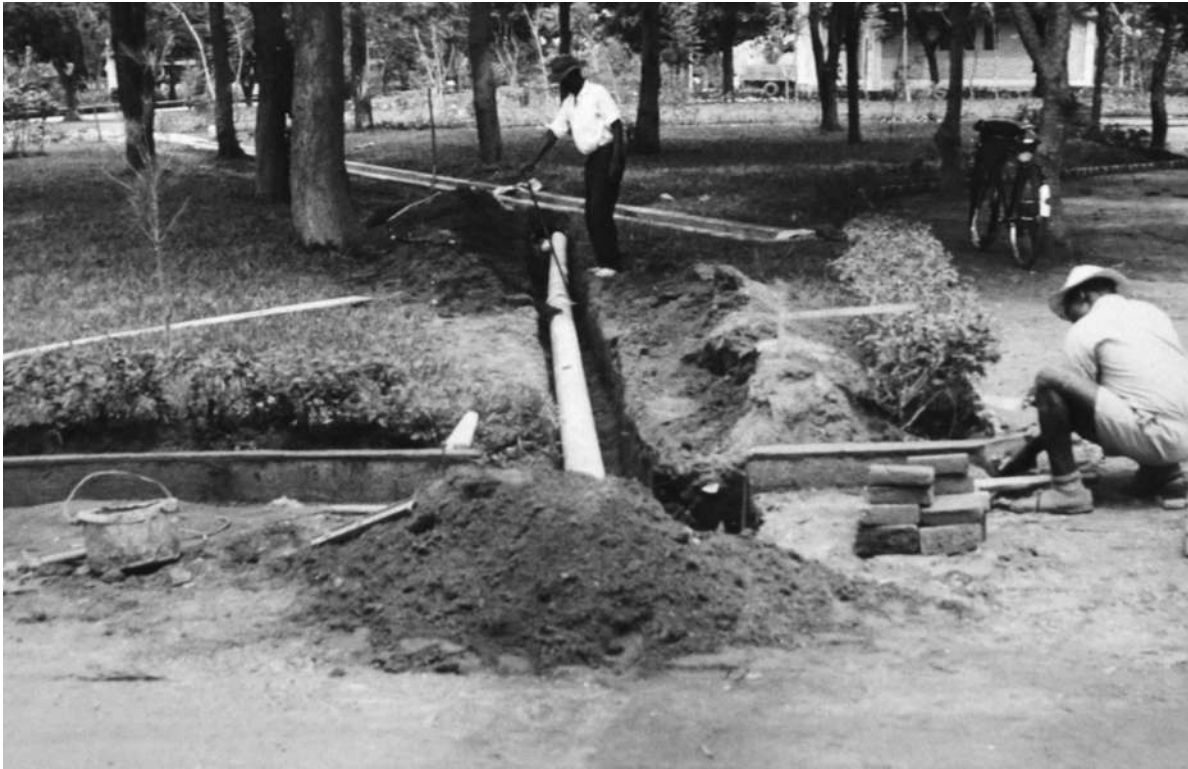
Rua da fachada lateral esquerda do Hospital, trabalhos de drenagem subterrânea [Urbanização e Saneamento do Dundo, 1962. UC/AD]
