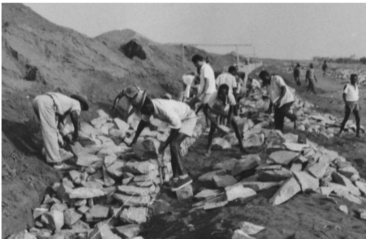
O encarregado da equipa 5 ensina a construir em “pedra seca” [Urbanização e Saneamento do Dundo, 1962. UC/AD]
