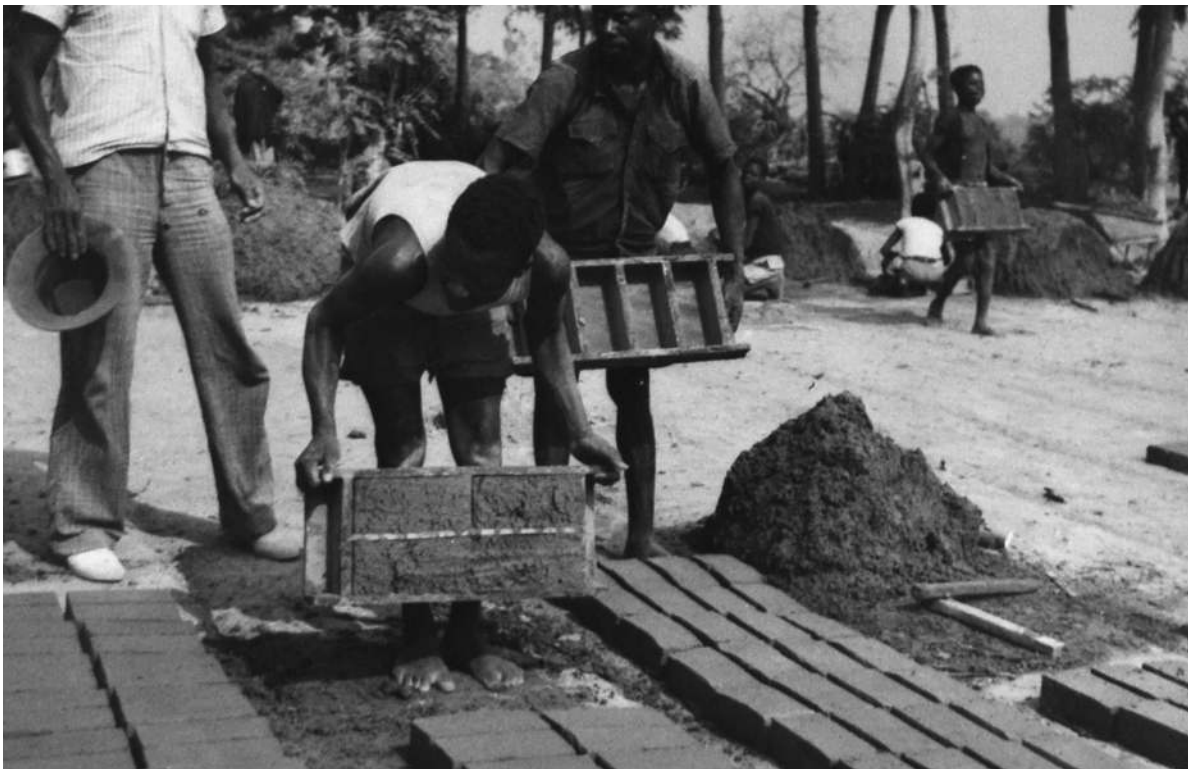
Tijolaria do Dundo. Moldagem de tijolo utilizando formas quádruplas [Relatório das Construções, 1955. UC/AD]
