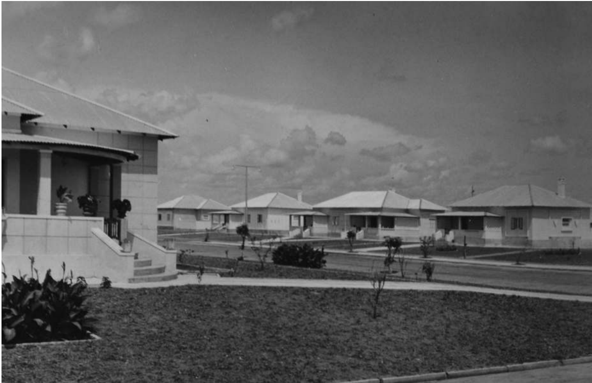
Conjunto de casas de habitação para empregados no Lucapa [Relatório do Serviço de Construção Civil, 1960-63. UC/AD]
