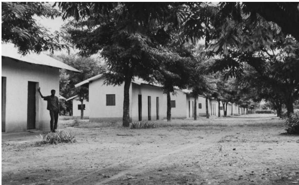
[215] Aldeamentos definitivos para trabalhadores do exterior e suas famílias: aldeia Nzargi-II, depois da transformação das suas casas de capim em construção de tipo semi-definitivo, 1962 [Serviço de Mão de Obra da Diamang, UC/AD]
