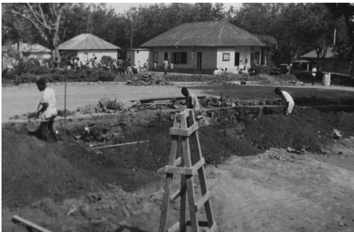
Outro aspecto dos trabalhos, vendo-se também os outros que decorriam na área dos escritórios do Corpo de voluntários [Urbanização e Saneamento do Dundo, 1963-64. UC/AD]
