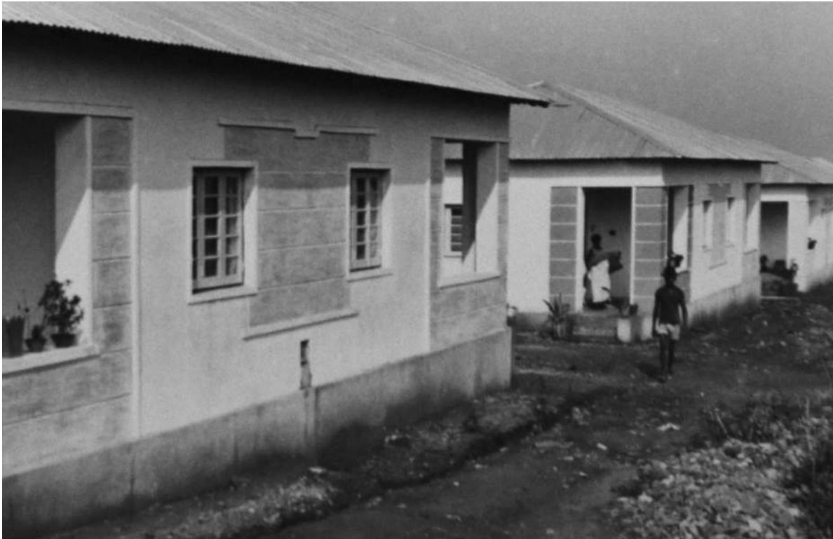
Bairro para Especializados. Lucapa [Construção e Reparação de Edifícios, 1964-65. UC/AD]
