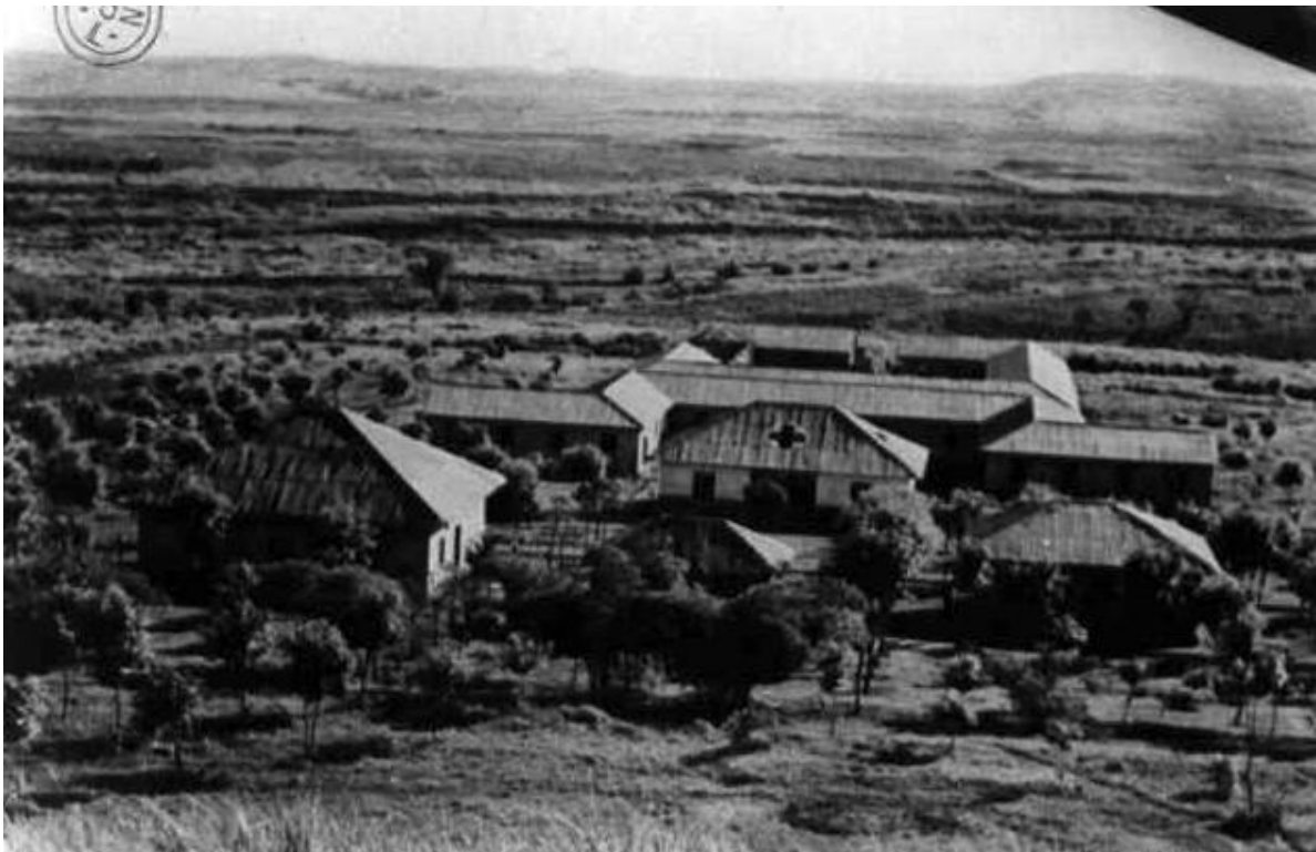
Hospital de Vila Paiva de Andrada, vista geral [Relatório dos administradores na Diamang, 1938. ANTT/AOS-D-N/2-5-1]
