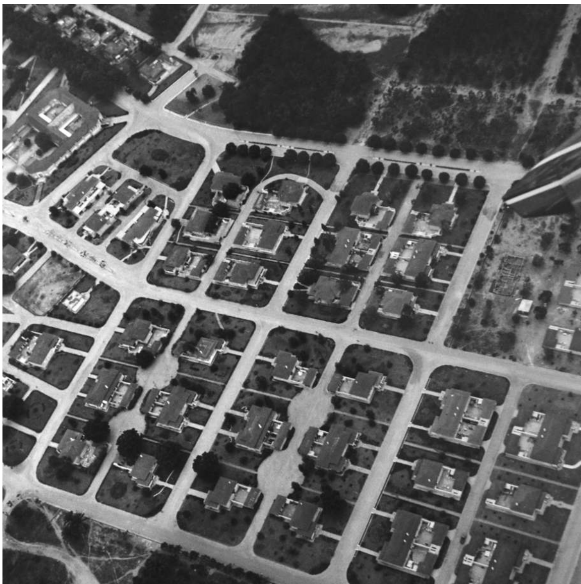
[110] Novo bairro residencial do Dundo; construção de novas habitações no talhão à direita, 1964 [Relatório de Construção e Reparação de Edifícios, 1964-65. UC/AD]
