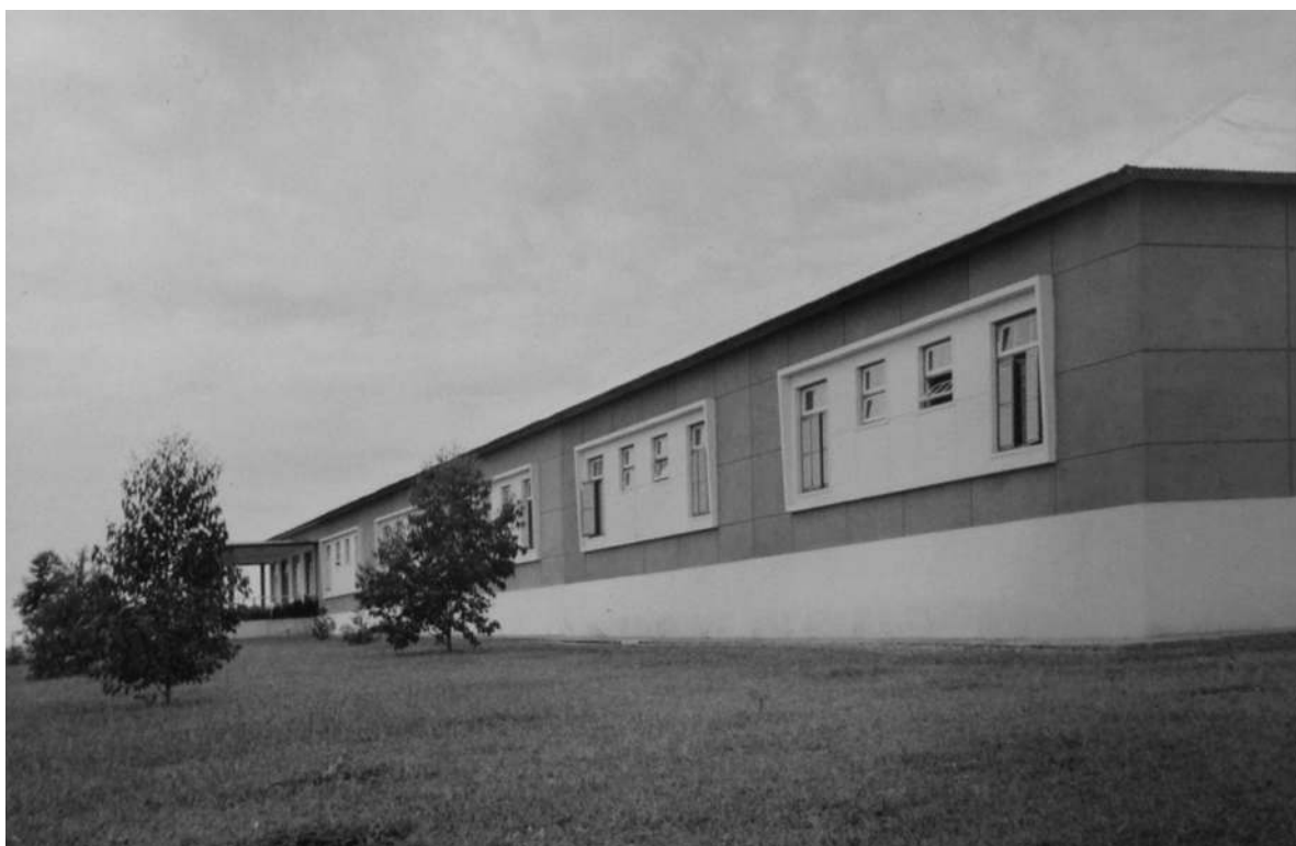
Casa de trânsito no Lucapa. Vista da zona de quartos já depois da ampliação [Construção e Reparação de Edifícios, 1965-66. UC/AD]
