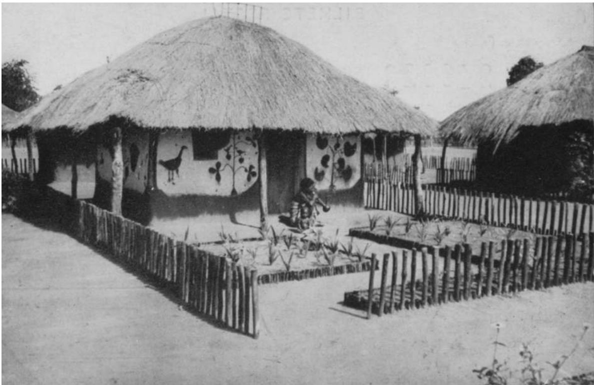
Aldeia para trabalhadores voluntários no Dundo; tipo de casa, 1943 [Relatório de Mão de Obra, 1943-44. UC/AD]
