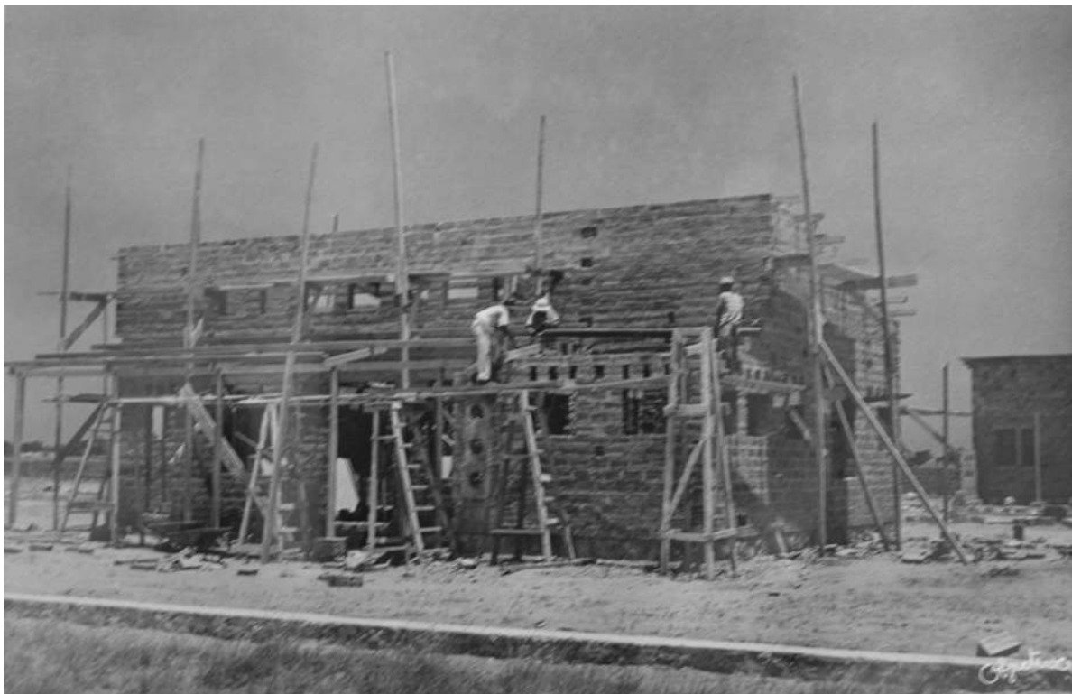
Construção da escola, 1953 [Construções Luanda, 1952-1953. UC/AD]
