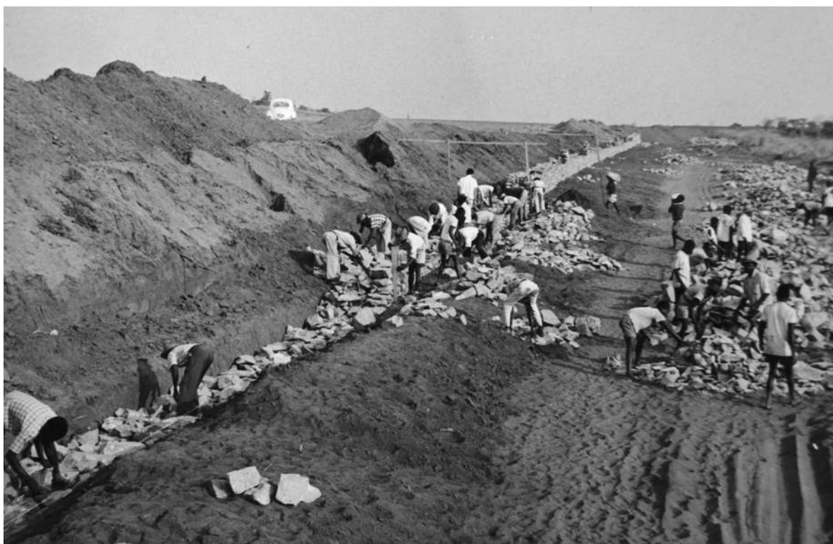
Uma ideia da extensão do muro e do volume de material que consome [Urbanização e Saneamento do Dundo, 1962. UC/AD]
