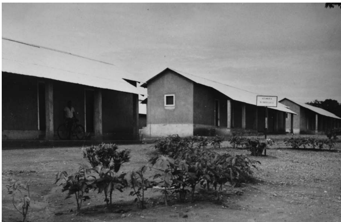
Aldeia para trabalhadores em Tshibaba [Relatório Anual do Serviço de Construção Civil, 1960-63. UC/AD]
