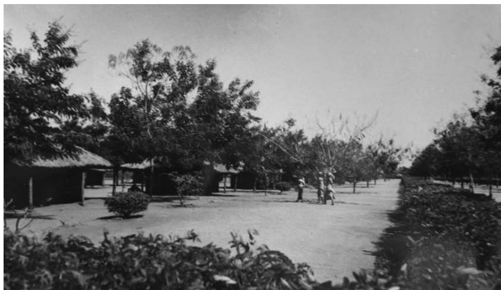
[194] Vista de aldeia de trabalhadores contratados, 1952 [Elementos para a Conferência InterAfricana do Trabalho, UC/AD]
