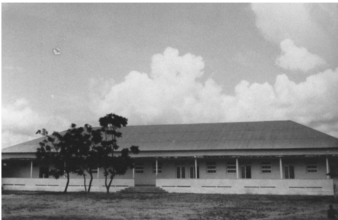
O bloco dos serviços gerais do Hospital do Calonda, focado do pátio [Serviços de Saúde, 1970. UC/AD]
