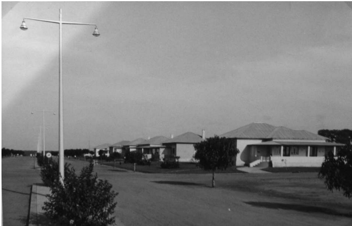
Casas de habitação na avenida principal do Lucapa [Construção e Reparação de Edifícios, 1964-65. UC/AD]
