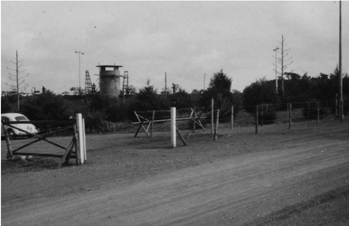
Aspecto da entrada, com cancela, na zona do pórtico. Ao fundo, uma das torretas de observação e combate, já concluída [Urbanização e Saneamento do Dundo, 1962. UC/AD]
