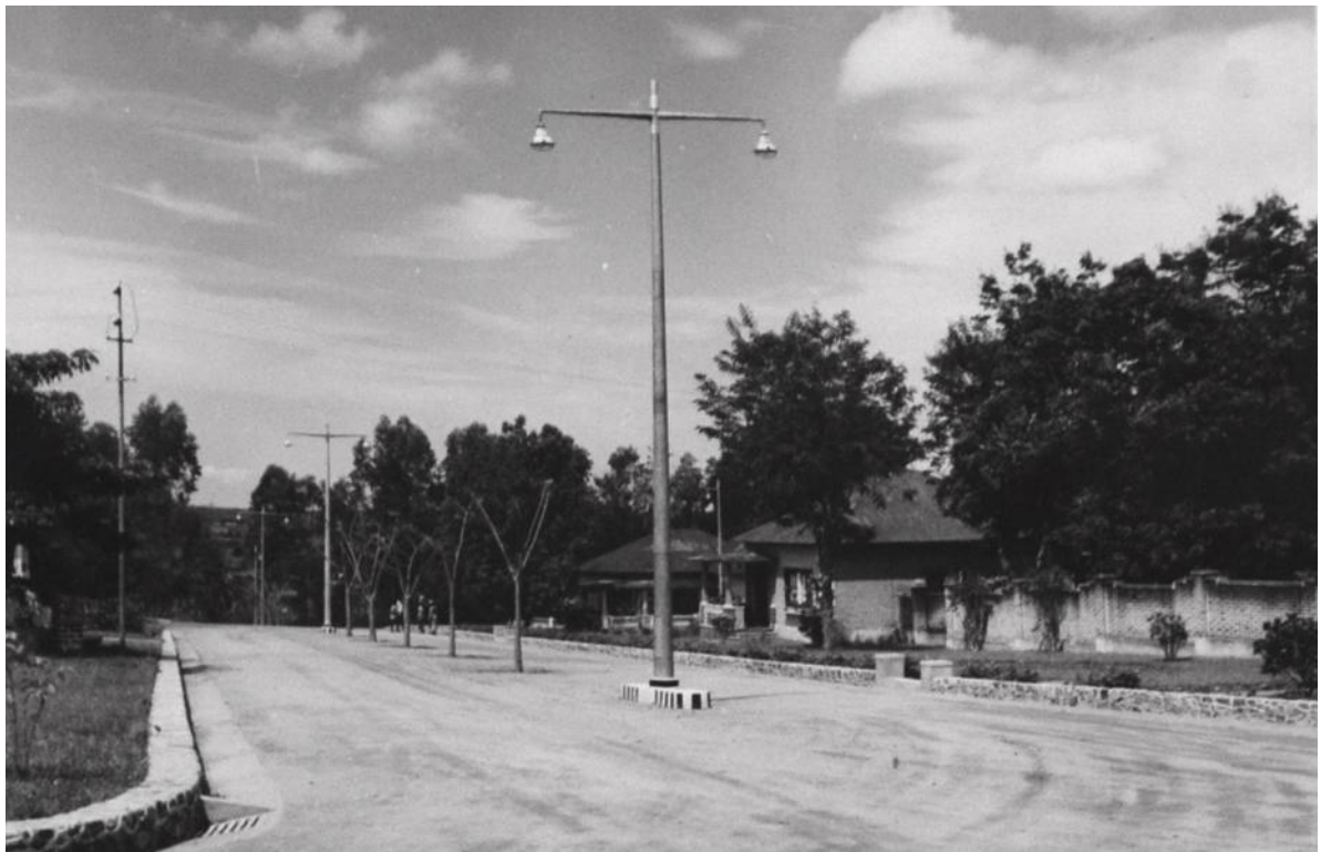
Troço da rua 12. Depois da reforma urbanística [Relatório Anual da Concessão do Dundo, 1964. UC/AD]
