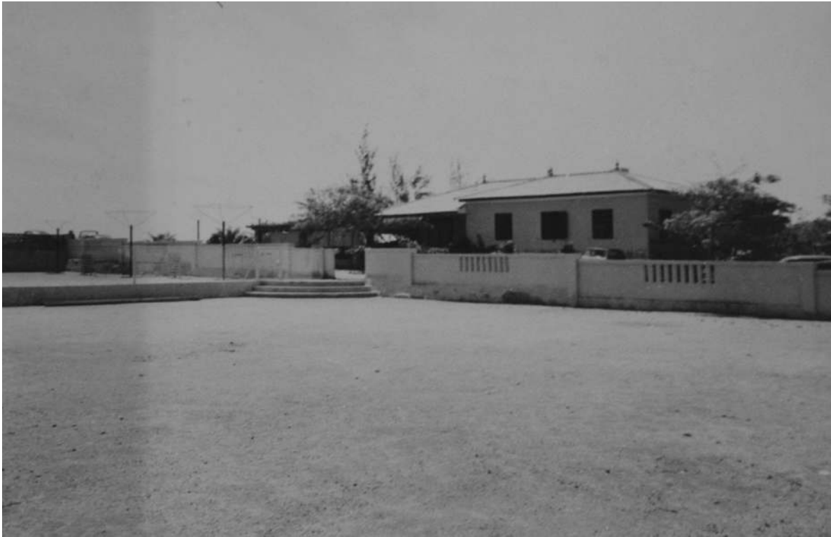
Recinto do campo de jogos na Casa da ilha, 1954 [Construções Luanda, 1954. UC/AD]
