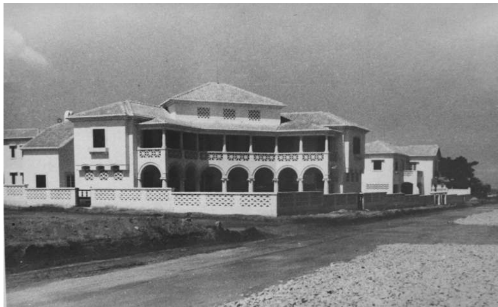
[178] Bairro residencial em Miramar: Casa tipo O [Construções em Luanda, 1954, UC/AD]
