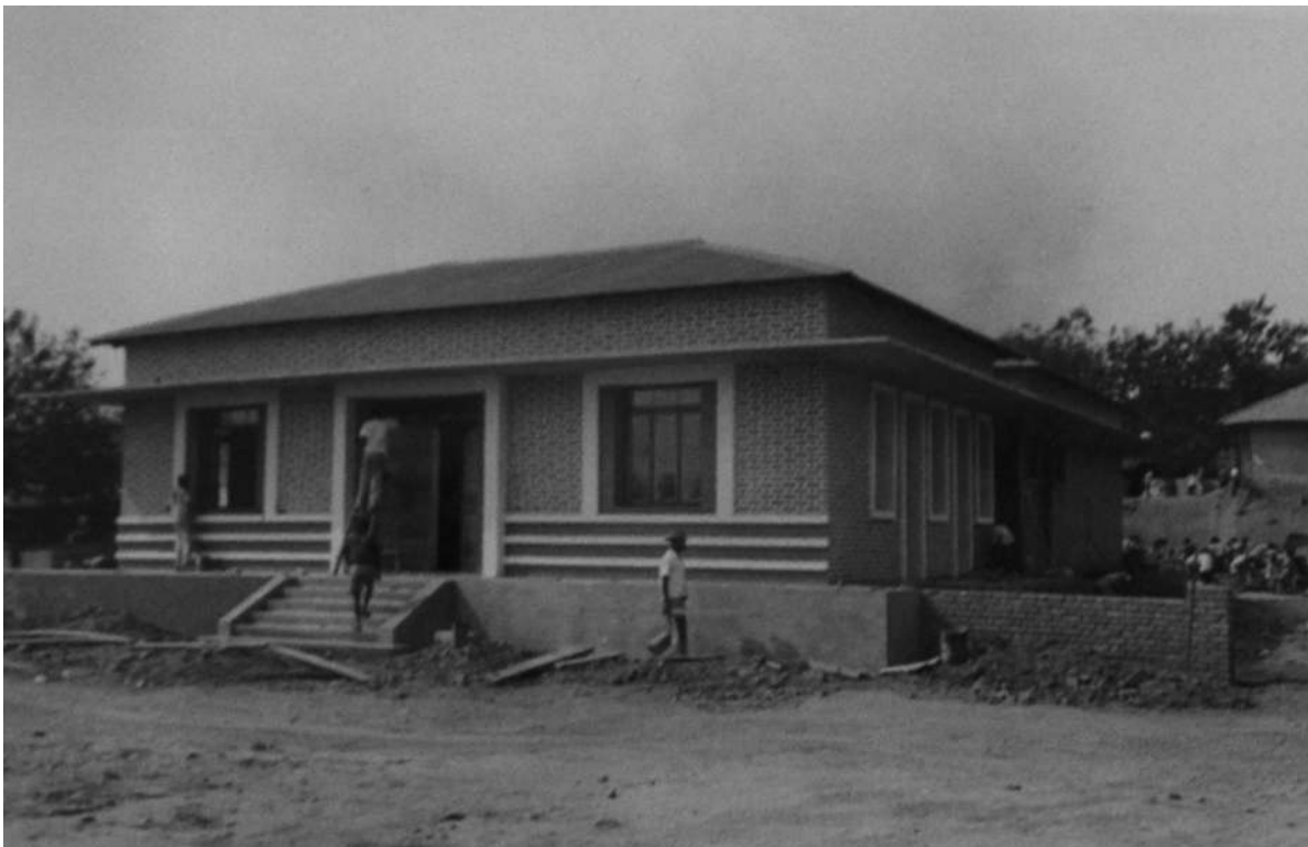
Novas instalações para a STA. Lado poente-norte [Construção e reparação de edifícios, 1950-53. UC/AD]
