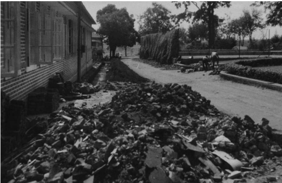
No lado sul dos escritórios centrais, trabalhos de drenagem definitiva [Urbanização e Saneamento do Dundo, 1963-64. UC/AD]
