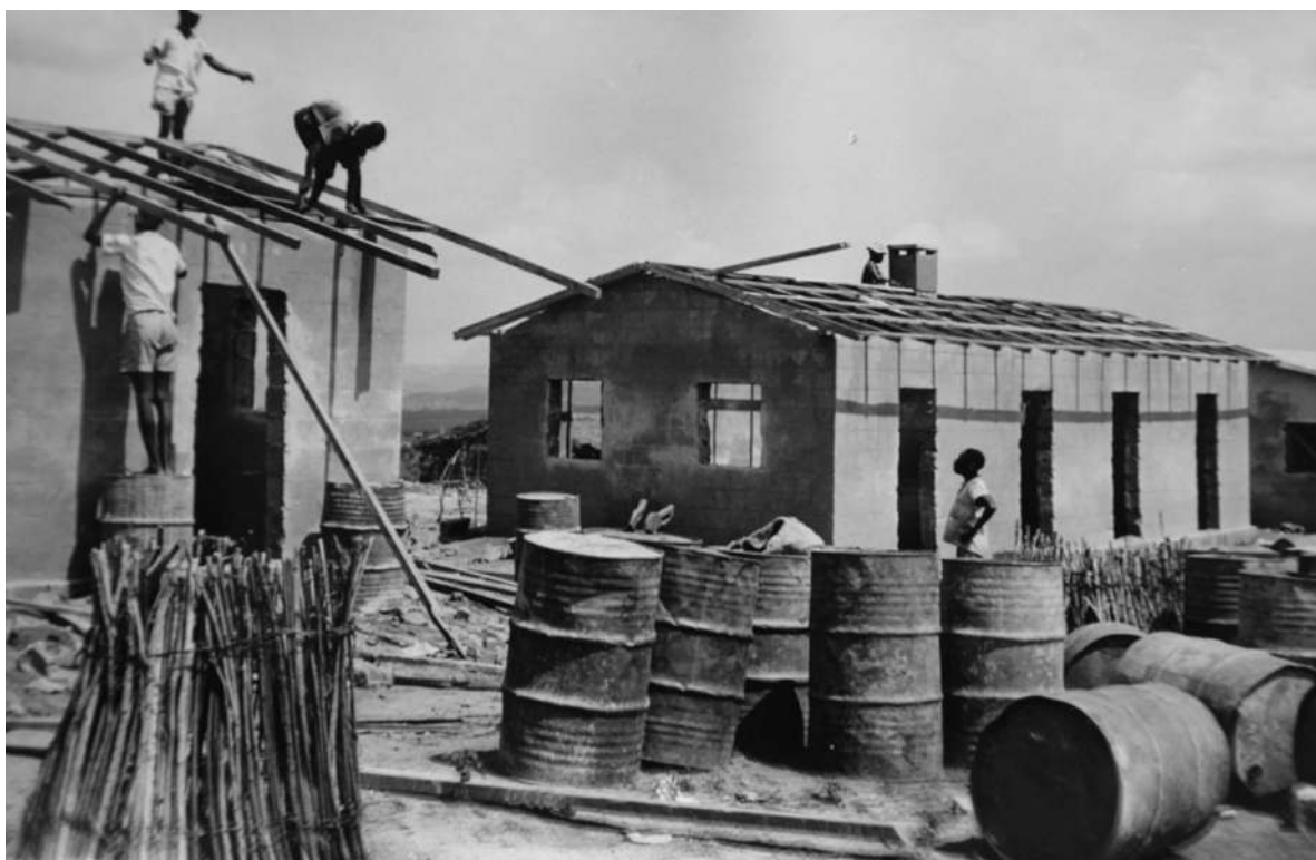
Fase da construção do novo bairro para contratados no Luxilo, 1961 [Relatório Anual da SPAMOI, 1961. UC/AD]
