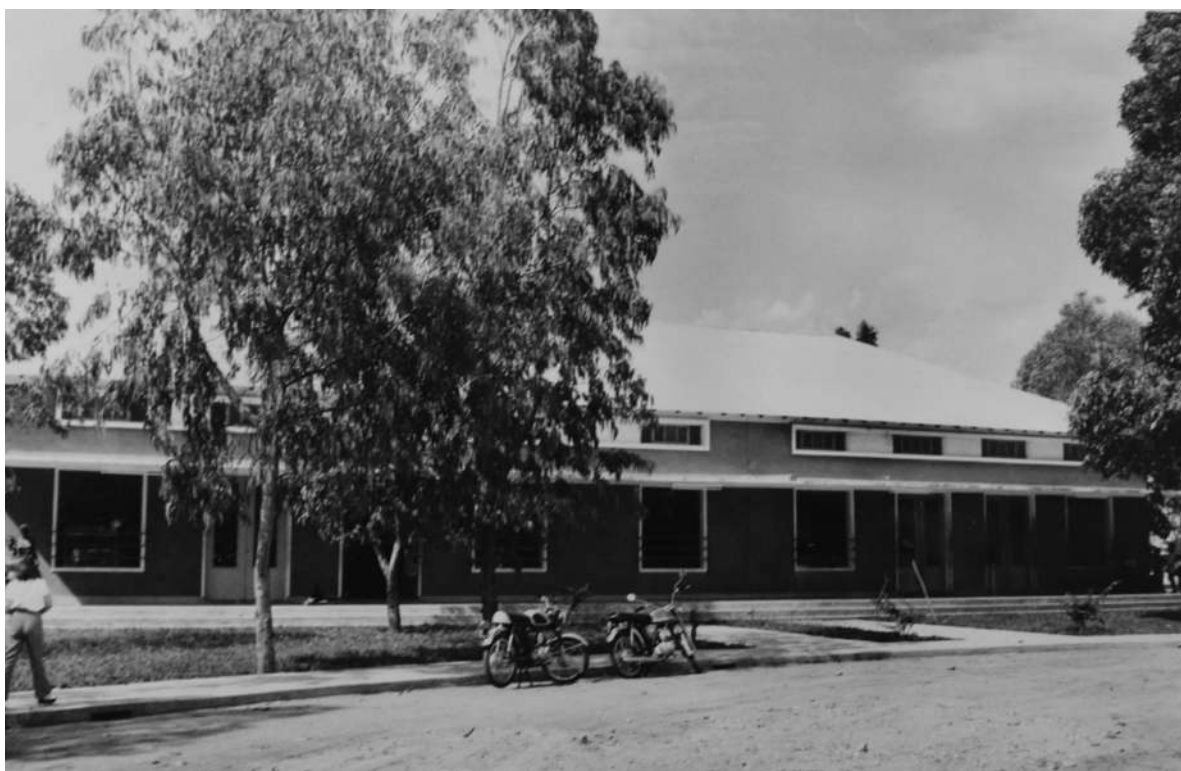
Armazéns, Escritórios e Oficinas no Lucapa [Relatório do Serviço de Construção Civil, 1960-63. UC/AD]
