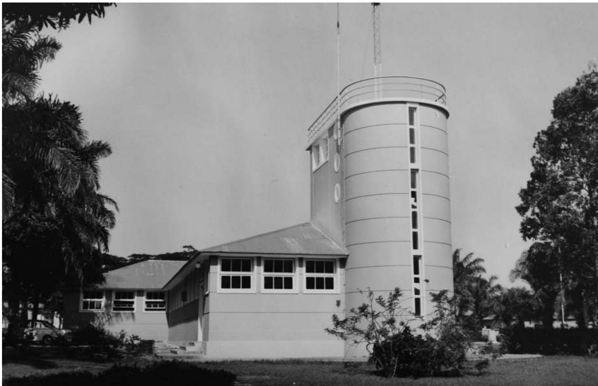
Zona Centro. Edifício da Secção de Telecomunicações. Ampliação da ex-Estação Meteorológica K-170 [Relatório Anual da Concessão do Dundo, 1970. UC/AD]
