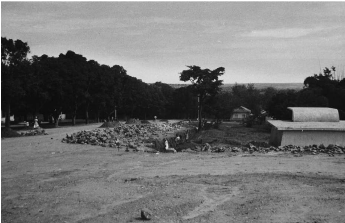
Abertura dos caboucos do muro de suporte, decorativo. Na fotografia de baixo, à direita, instalação ligada ao fornecimento de água no Bairro da Escola [Urbanização e Saneamento do Dundo, 1962. UC/AD]
