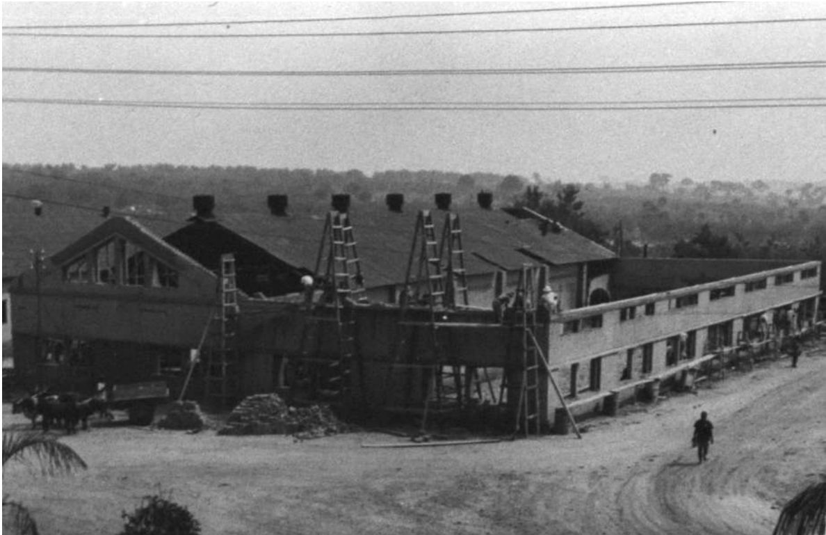
Ampliação da carpintaria. Lado sul-nascente [Construção e reparação de edifícios, 1950-53. UC/AD]
