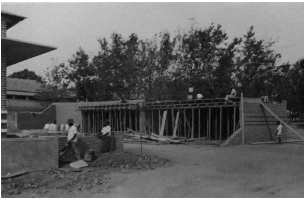
Novas instalações para a STA. Cabines para a recolha de carros ligeiros. Lado poente [Construção e reparação de edifícios, 1950-53. UC/AD]
