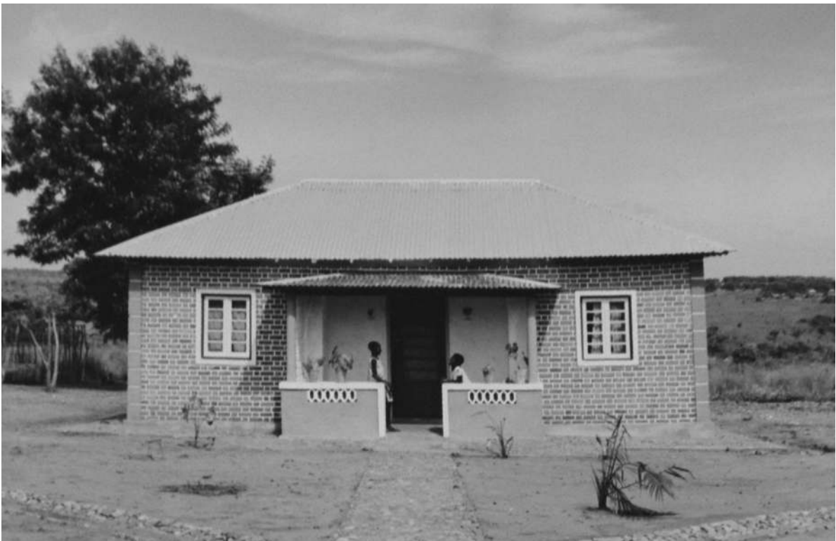
Habitação destinada a um criado da Direcção-Geral [Relatório Anual da Concessão do Dundo, 1964. UC/AD]
