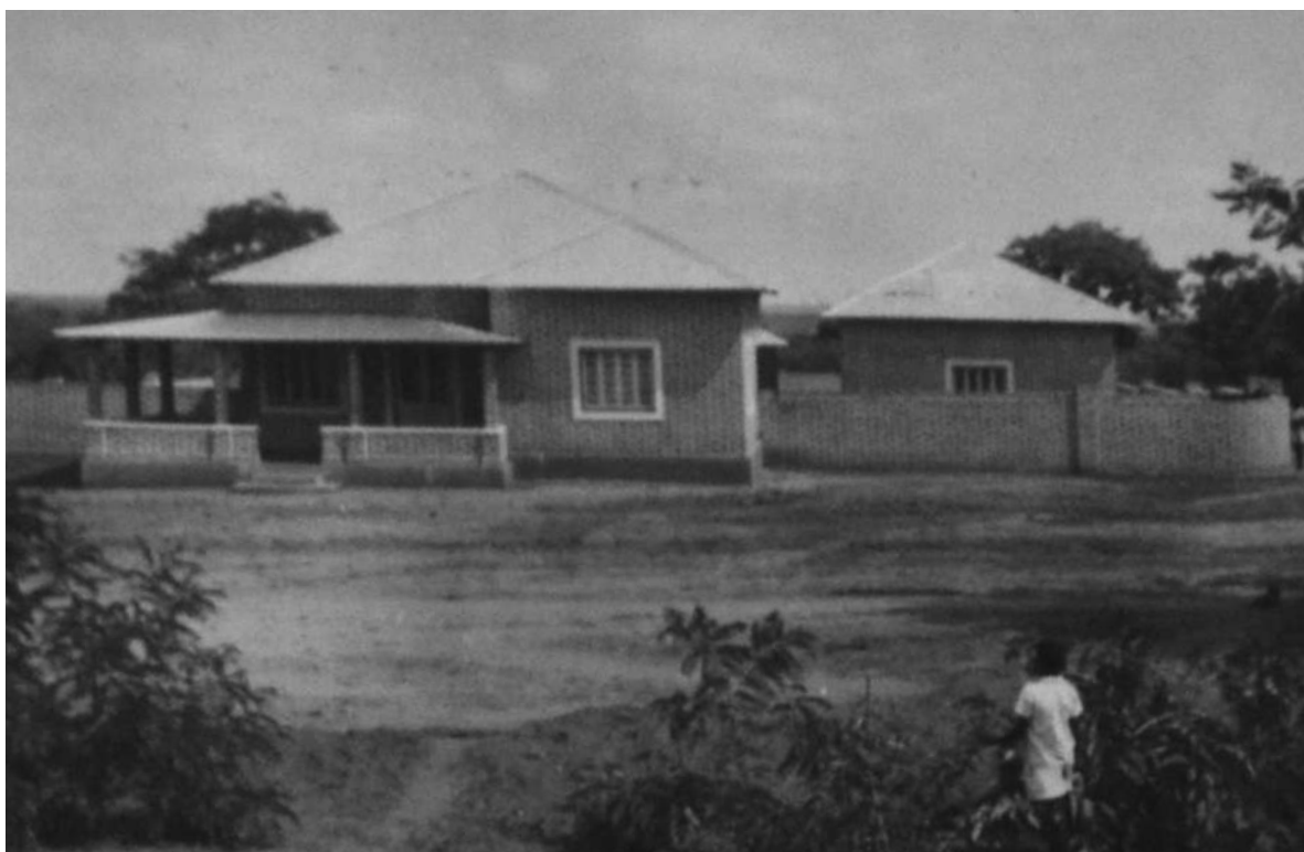
Cachimo. Alçado Principal do Hospital-Dispensário (nota manuscrita: "interessante") [Construção e Reparação de Edifícios, 1950-53.UC/AD]
