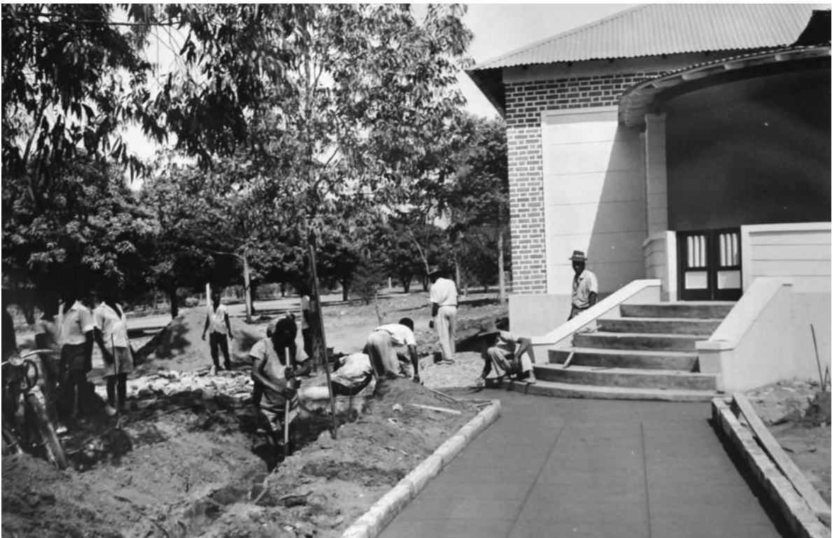
Aspectos da construção de jardins das casas feitas este ano na rua 26 [Urbanização e Saneamento do Dundo, 1965. UC/AD]
