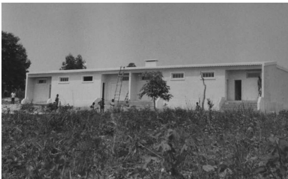
[205] Acampamento em Dumba-Cabango, fachada principal, 1968 [Construções nas Explorações, UC/AD]
