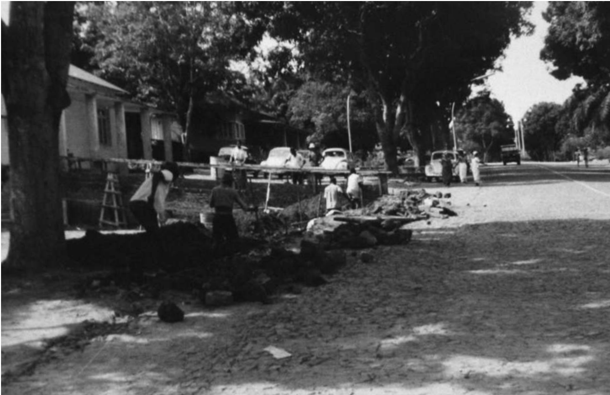
O início dos trabalhos de construção dos jardins em frente aos novos escritórios [Urbanização e Saneamento do Dundo, 1963-64. UC/AD]
