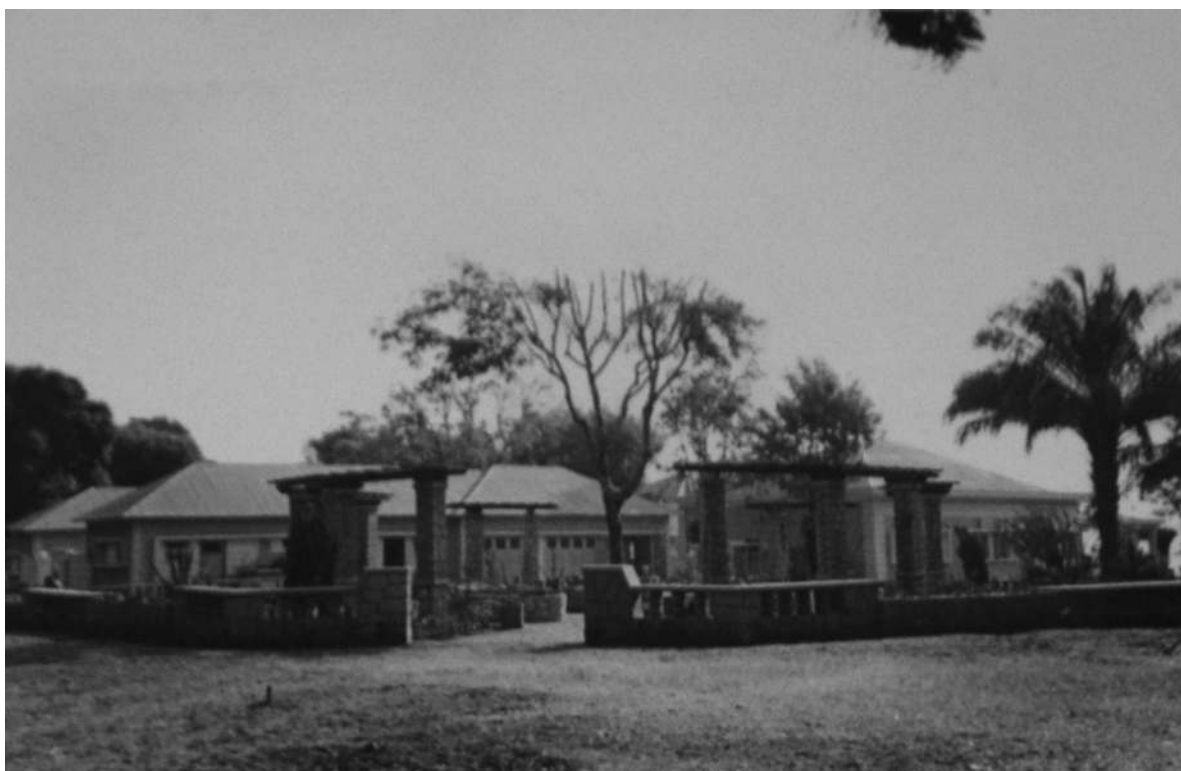
Casa da Representação e os novos anexos. Fachadas sul e poente [Construção e reparação de edifícios, 1950-53. UC/AD]
