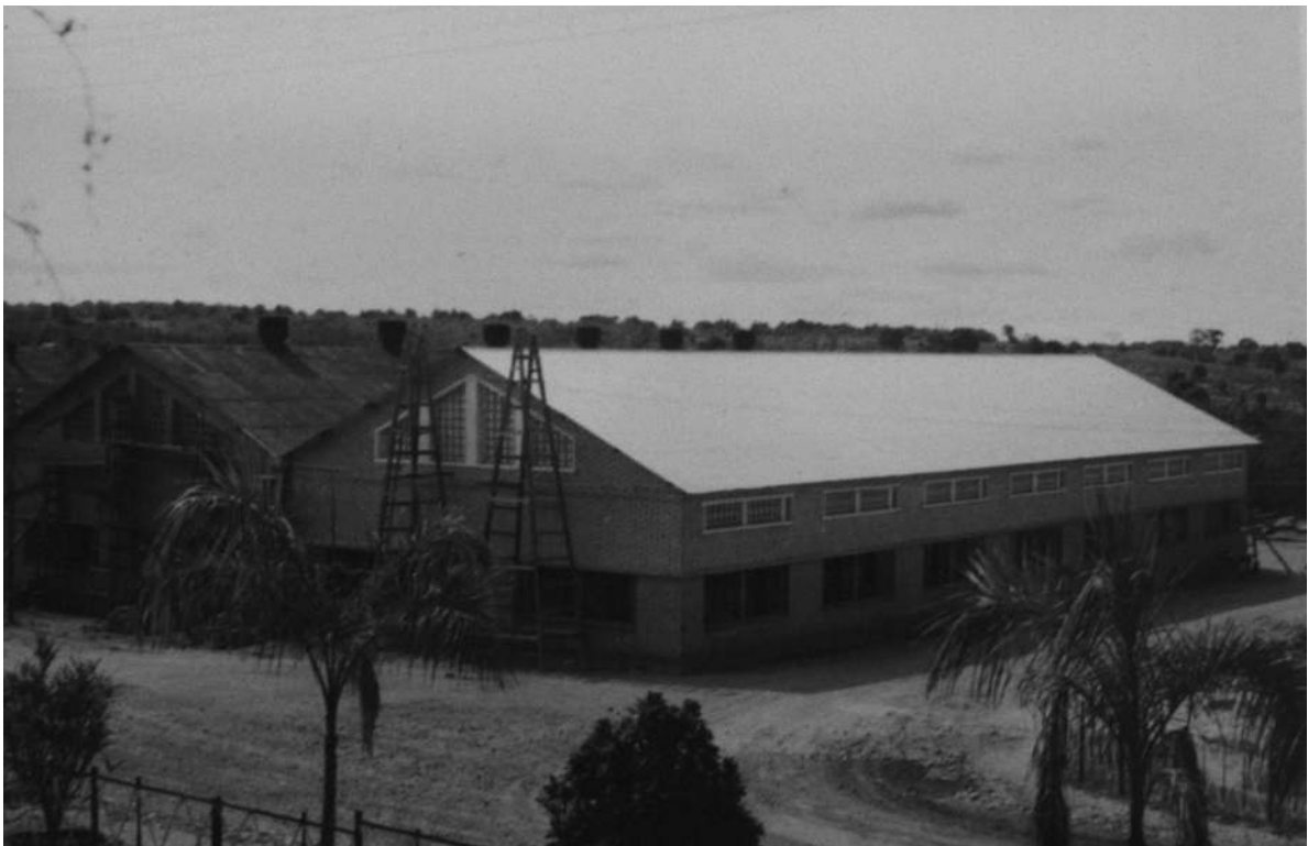
Oficina de carpintaria. Aspecto nascente-sul [Construção e reparação de edifícios, 1950-53. UC/AD]
