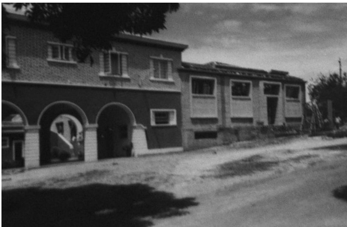
Casa do Pessoal, Dundo. Corpo da biblioteca e parte da casa de trânsito, 1951 [Construção e Reparação de Edifícios, 1950-53. UC/AD]
