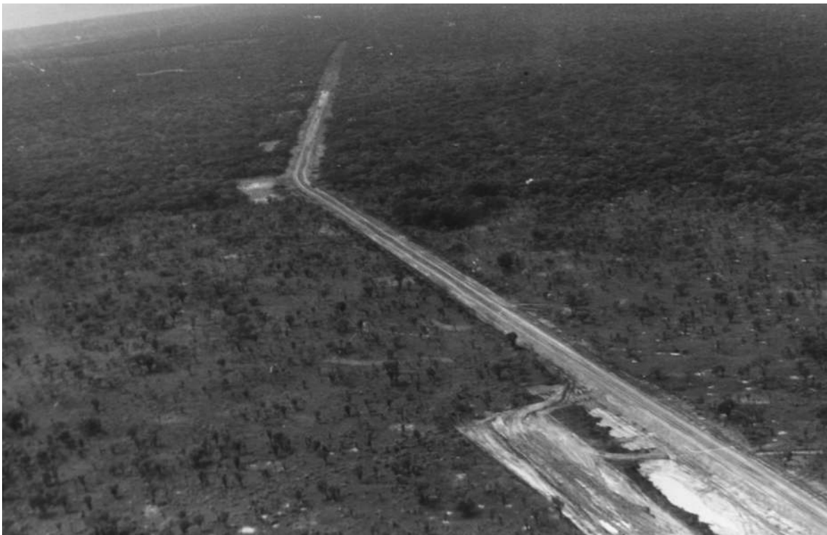
Estrada Luzamba-EN Malange/Henrique Carvalho. Vista aérea do trecho inicial, com terraplanagens já executadas [Relatório Anual da DSOVC, 1967. UC/AD]
