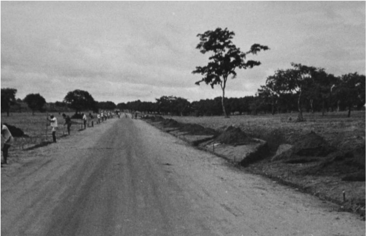
Adiantados os trabalhos de derrube, limpeza e correcção dos terrenos que, a sul da Mata e até à nova Rotunda, virão a constituir o seu prolongamento [Urbanização e Saneamento do Dundo, 1963-64. UC/AD]
