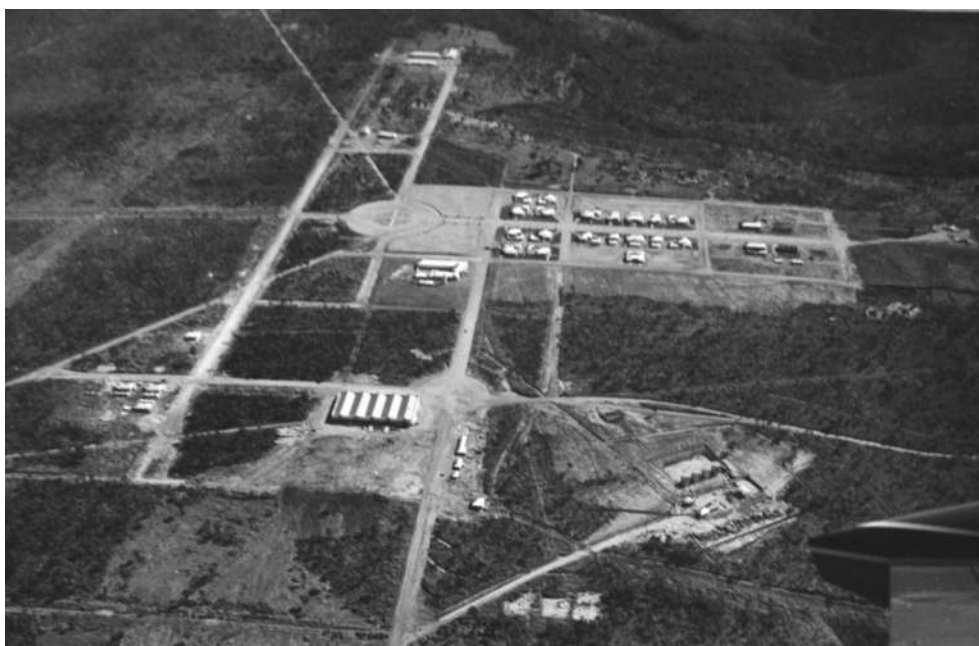
[39] Primeiras construções no Centro Urbano do Lucapa, vista aérea, 1963
