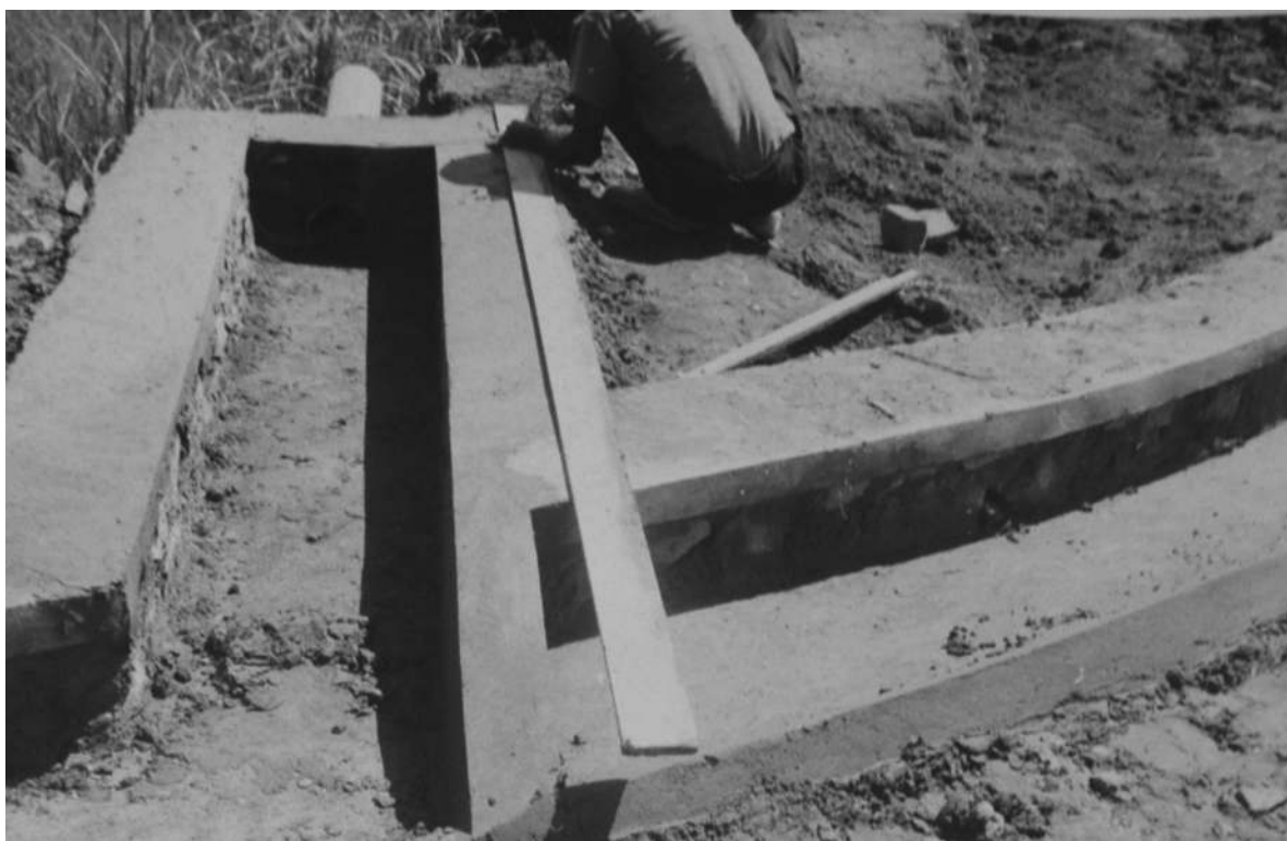
Estrada de “acesso secundário” à Central Luachimo, pormenores do sistema de drenagem [Urbanização e Saneamento do Dundo, 1962. UC/AD]
