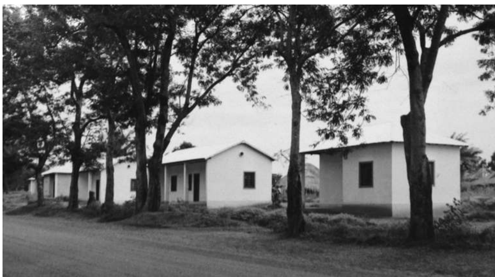
[216] e [217] Casas para venda a nativos. Camatundo (Dundo). Um aspecto [Construção e Reparação de Edifícios, 1964-65, UC/AD]
