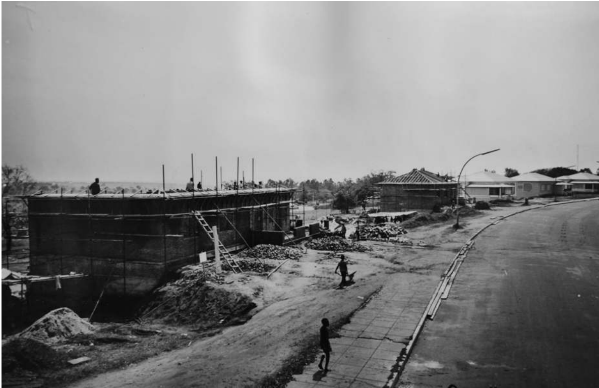
Zona norte. Grupo de casas de habitação para empregados, de 3 e 4 quartos. Em primeiro plano uma fase de construção da casa simples, de 4 quartos, K-455 [Relatório Anual da DSOVC, 1970. UC/AD]
