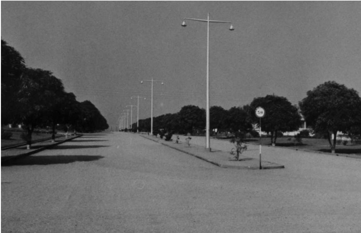
Aspecto da avenida principal depois de concluído o alcatroamento [Urbanização e Saneamento da Lunda, 1967-69. UC/AD]
