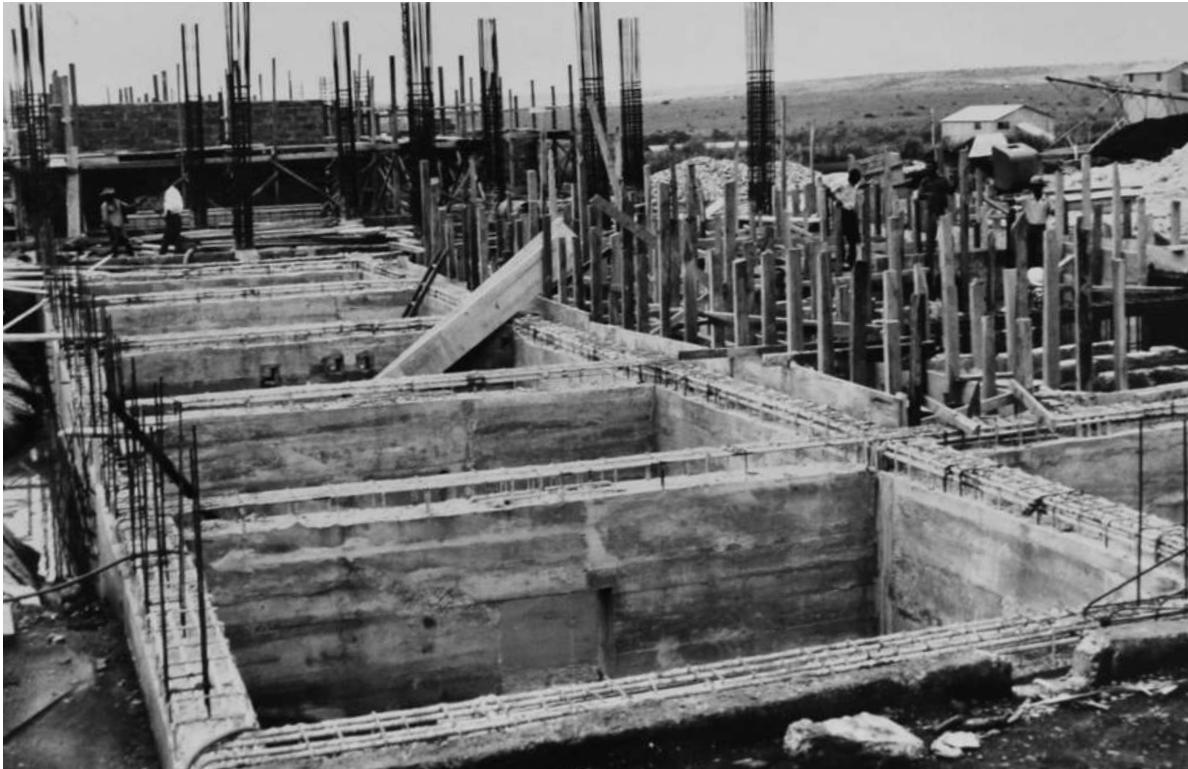
Subestação de Andrada II. Pormenor das fundações. Em segundo plano, armaduras de estrutura do hall de descubagem e do armazém [Relatório Anual da DSOVC, 1967. UC/AD]
