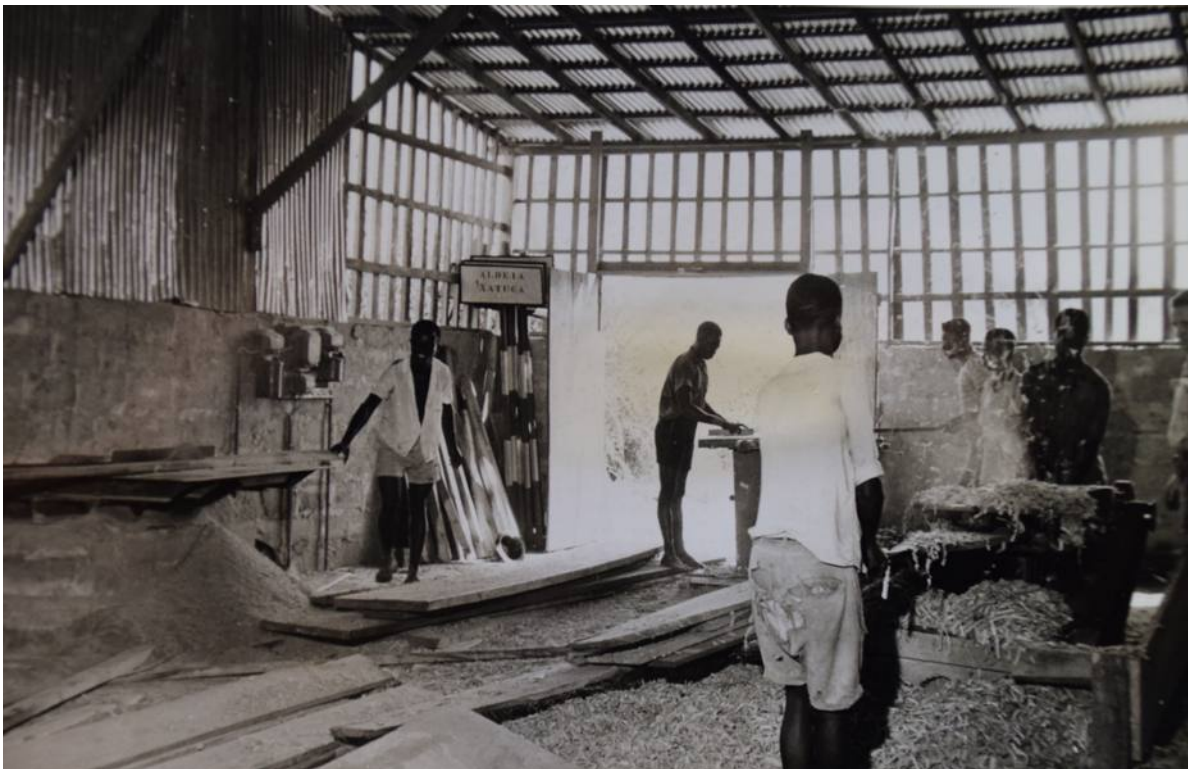
Carpintaria da SPAMOI com serra e plaina mecânica onde se prepara madeira para casa de trabalhadores [Relatório da SPAMOI, 1962. UC/AD]
