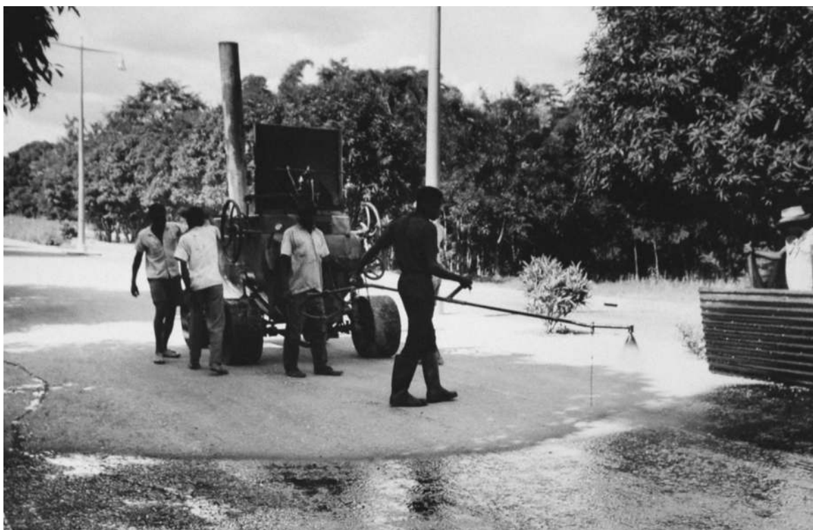
Durante os trabalhos de alcatroagem da Avenida do Obelisco [Relatório Anual da Concessão do Dundo, 1964. UC/AD]
