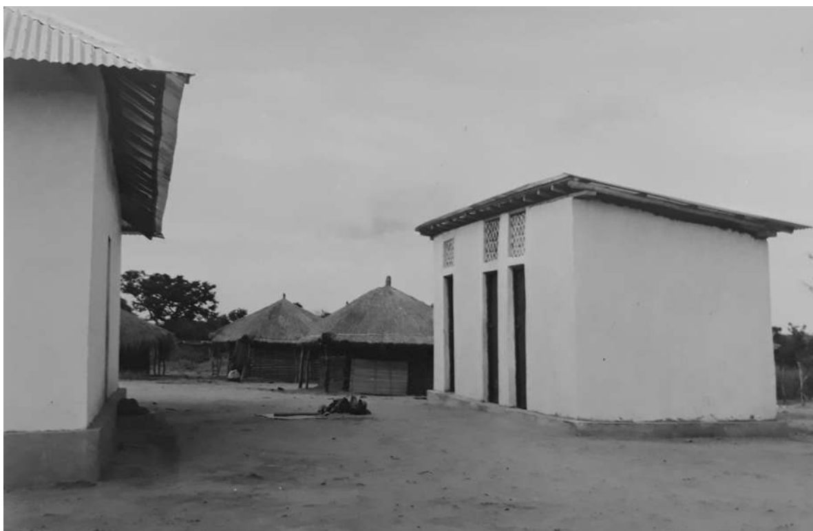
Cozinhas e casas de banho da casa acima mencionada [Relatório Anual da SPAMO, 1966. UC/AD]
