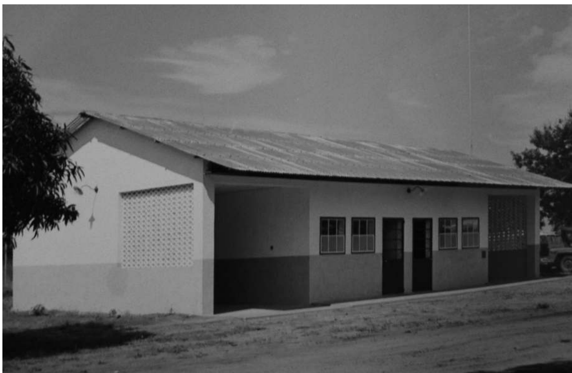
Aquartelamento de Portugália. Bloco sanitário e enfermaria [Construção e Reparação de Edifícios, 1964-65. UC/AD]
