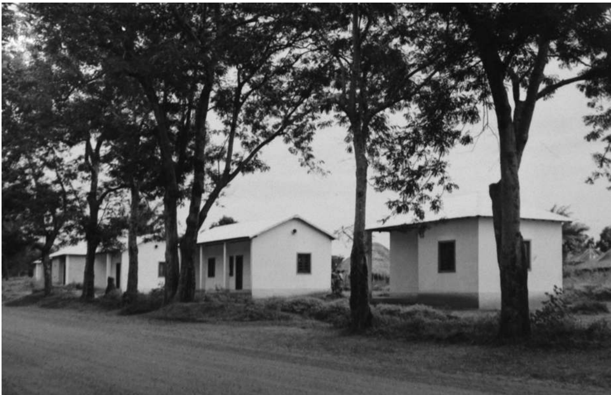
Casas para venda a nativos, no Camatundo (Dundo) [Construção e Reparação de Edifícios, 1964-65. UC/AD]
