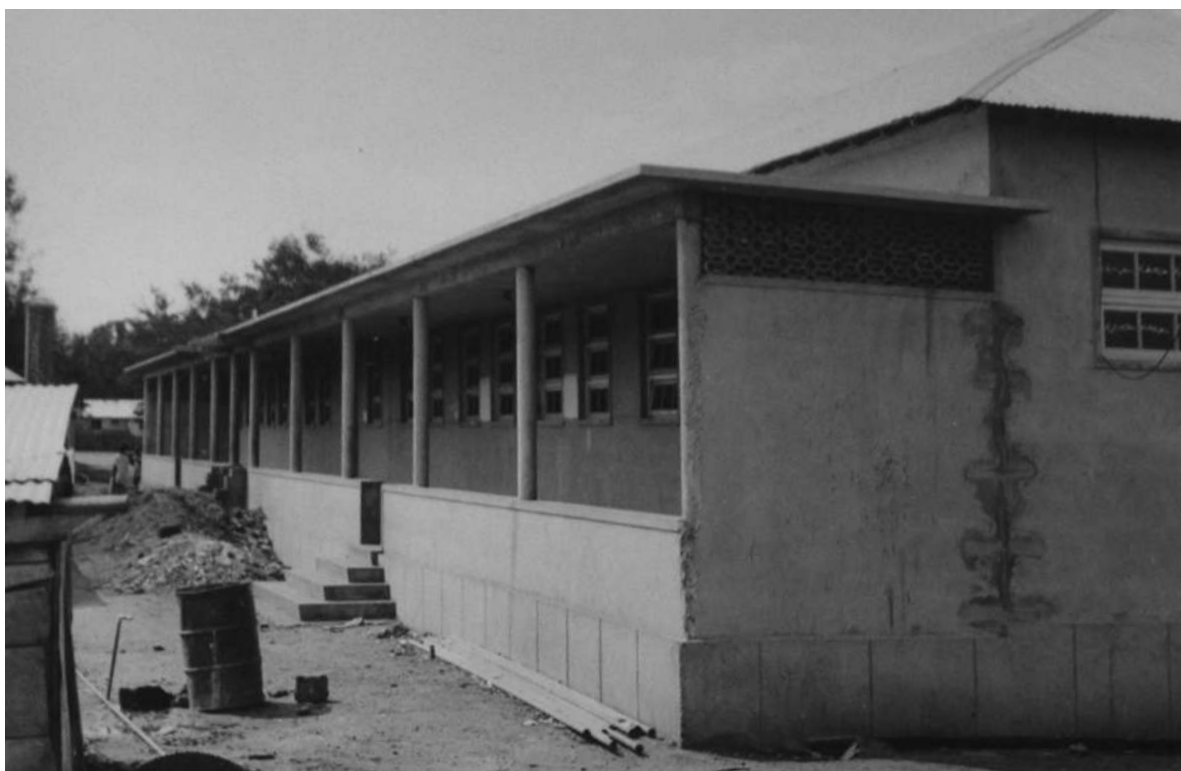
Nova enfermaria do Hospital-Dispensário do Lóvua [Construção e Reparação de Edifícios, 1964-65. UC/AD]
