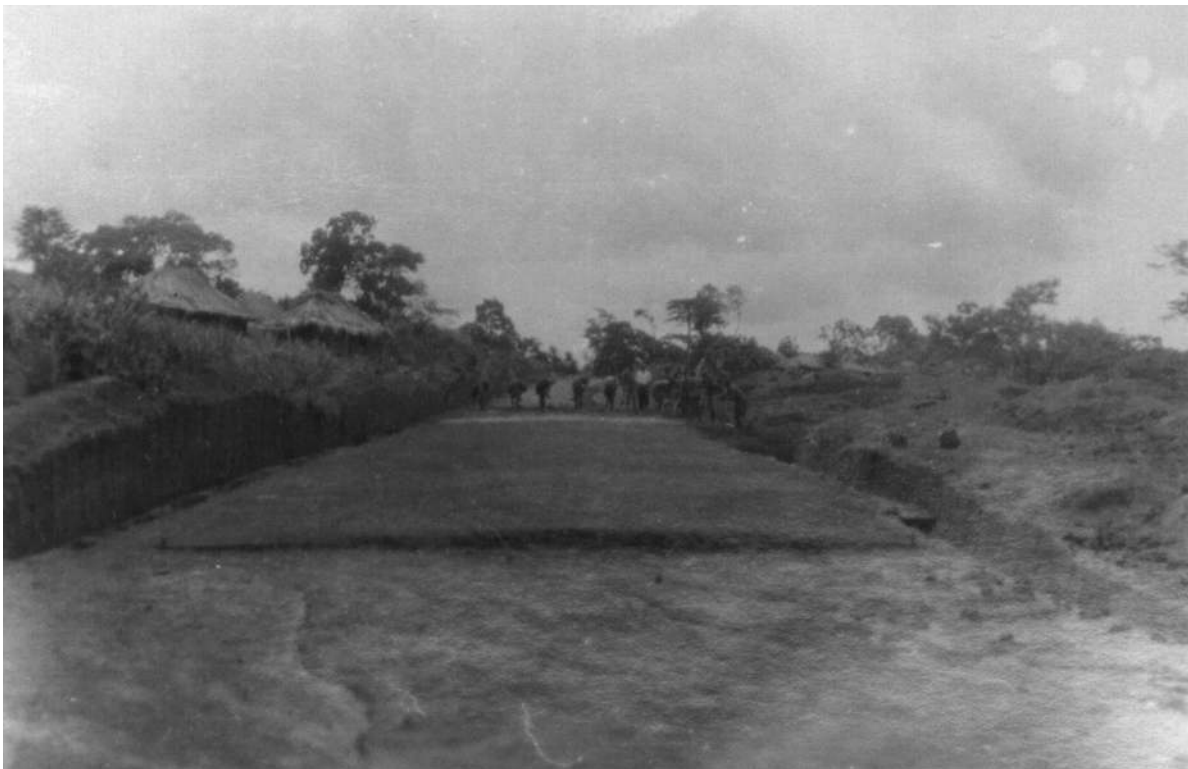
Construção da nova estrada para a margem oriental do rio Luachimo [Rapport 20, 1933. ANTT, HB-C/2-5-1-20]
