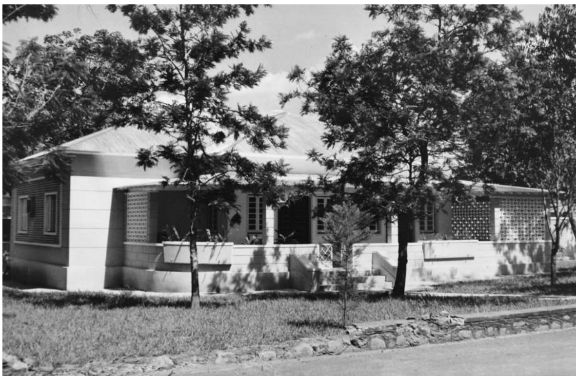
Zona sul. Casa de habitação, simples de três quartos, para empregados K-389 [Relatório Anual da DSOVC, 1970. UC/AD]
