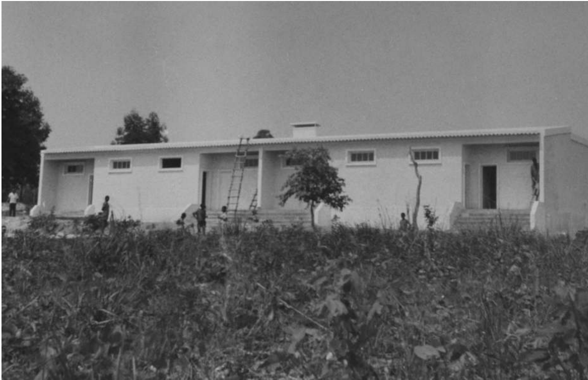
Acampamento em Dumba-Cagango, fachada principal [Construções nas Explorações, 1968. UC/AD]
