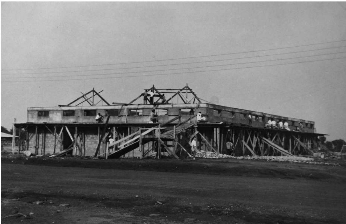
Um aspecto da construção da Loja Principal do Lucapa [Construção e Reparação de Edifícios, 1964-65. UC/AD]
