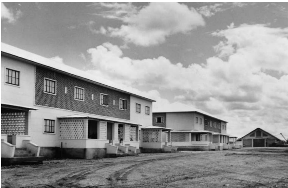
[113] Nova estrada noroeste da povoação de Andrada, 1970
