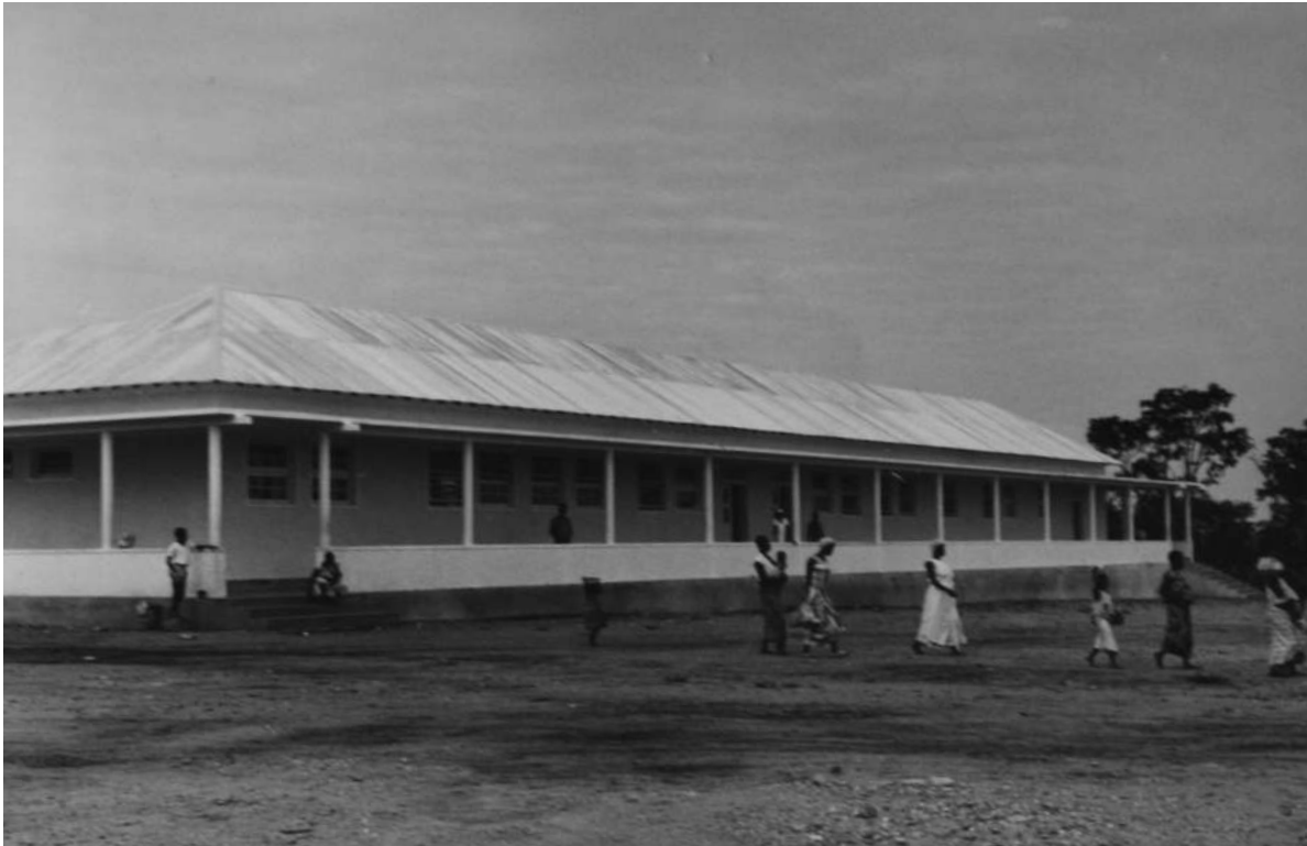
Enfermaria do Bloco Hospitalar no Calonda [Relatório dos Serviços de Construção Civil, 1960-63. UC/AD]
