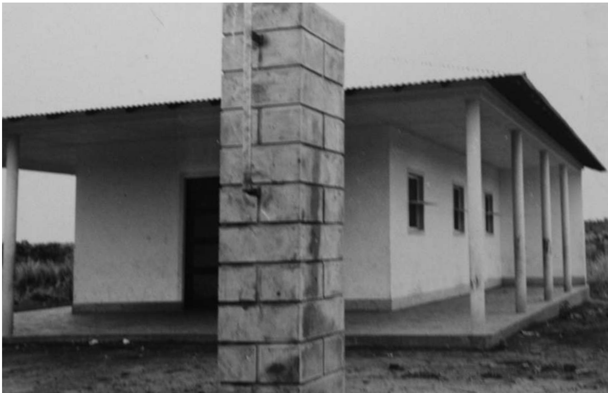
Posto Escolar do Conduége, Dundo [Construção e Reparação de Edifícios, 1965-66. UC/AD]
