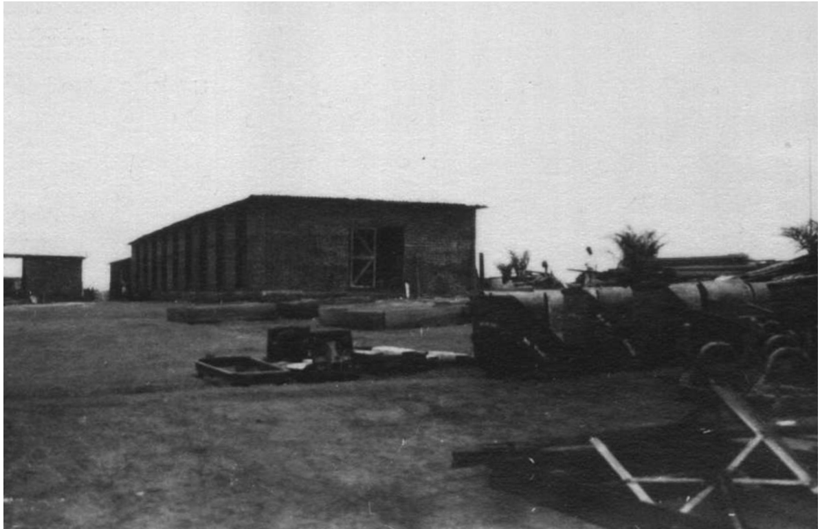
Armazém em Andrada, cobertura com chapa ondulada [Rapport 18, 1931, ANTT/HB-C/2-5-1-18]
