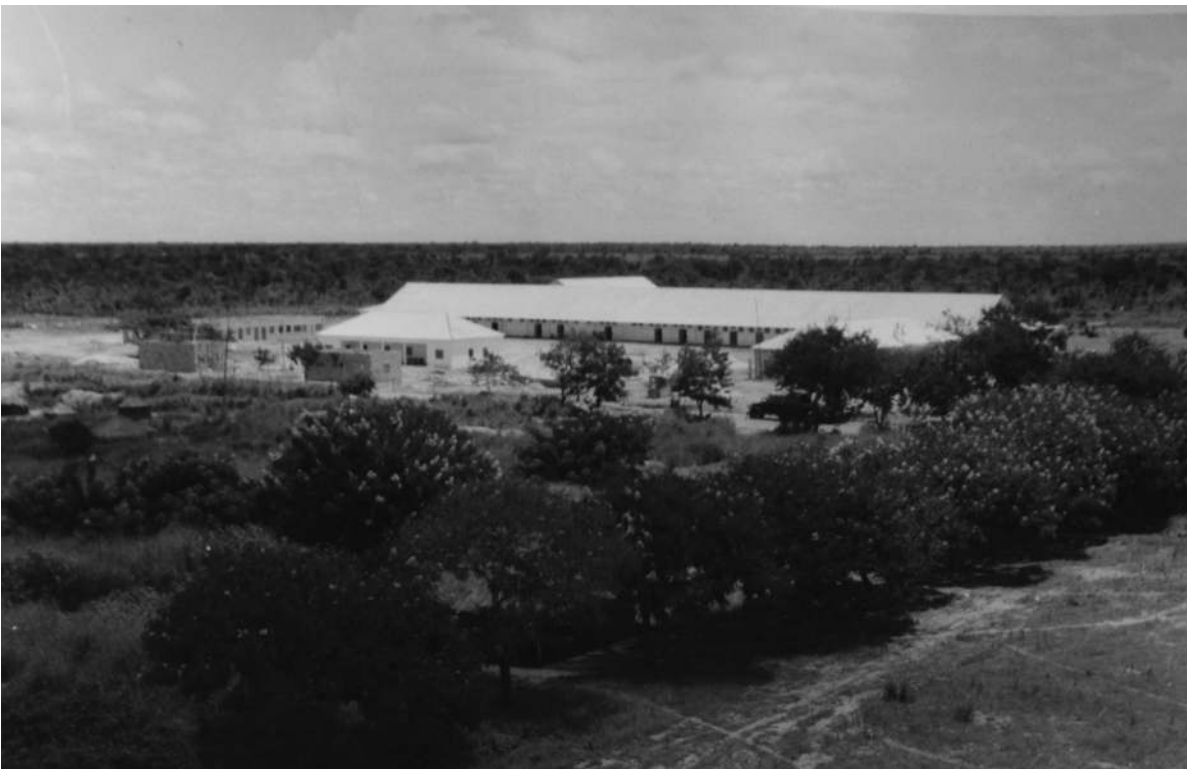
Aquartelamento do Camissombo. Vista geral [Construção e Reparação de Edifícios, 1964-65. UC/AD]
