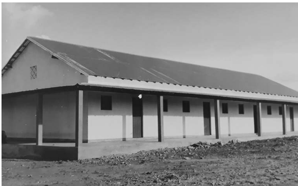
[204] Aspecto de uma camarata para alojamento de trabalhadores solteiros, 1966 [Relatório Anual da SPAMOI, UC/AD]
