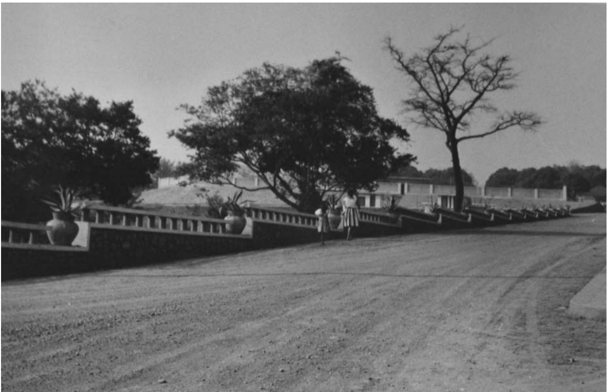
Aspectos dos trabalhos já executados, mostrando o muro projectado e executado pela Concessão [Urbanização e Saneamento do Dundo, 1962. UC/AD]
