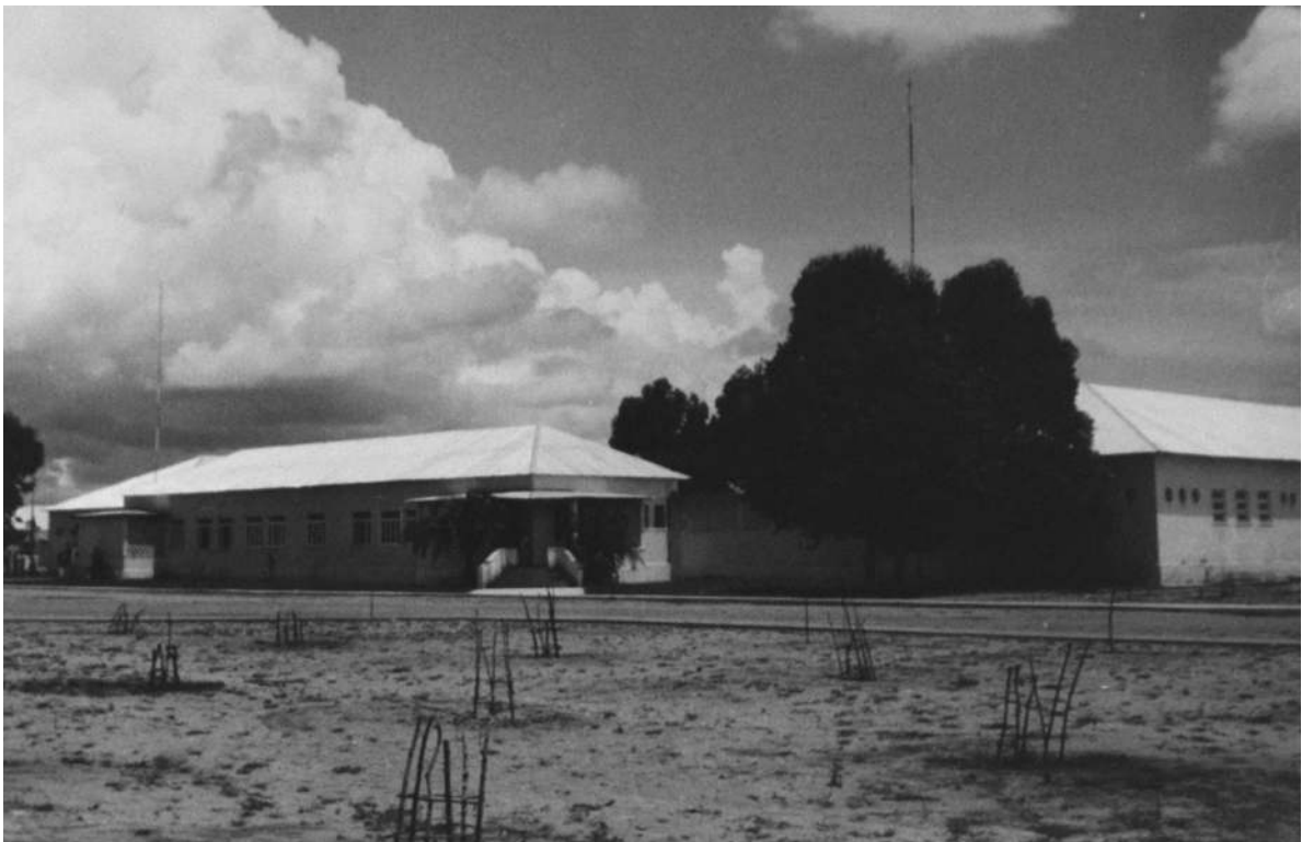
Pormenor da ala nascente do bloco central do Hospital do Lucapa, em construção [Serviços de Saúde, 1970. UC/AD]
