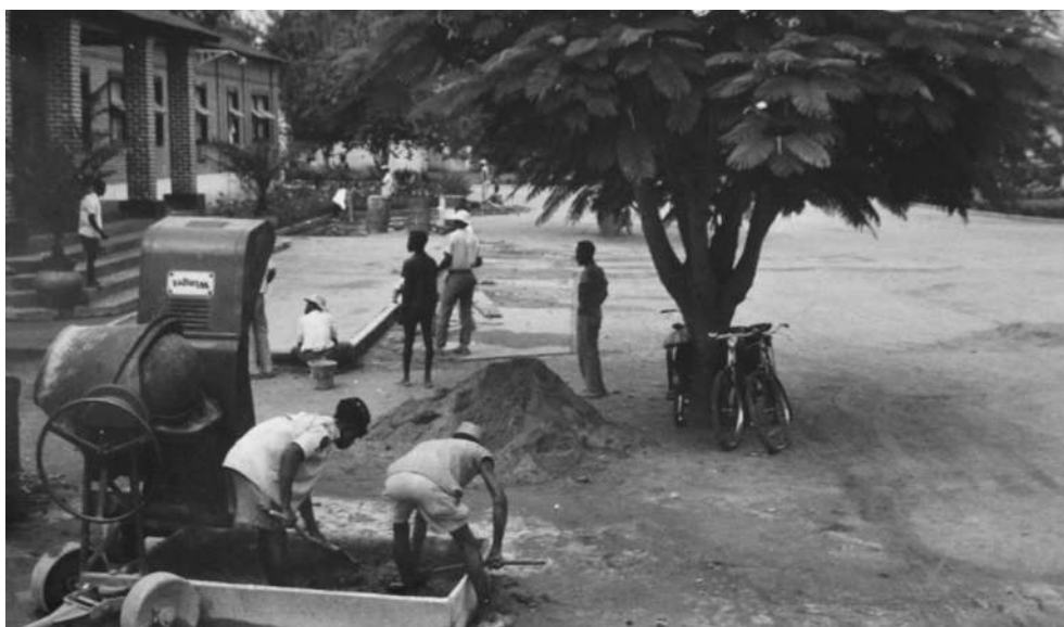
[49] Obras de urbanização no Bairro-Sul do Dundo, 1965 [Relatório Anual de Urbanização e Saneamento do Dundo, UC/AD]
