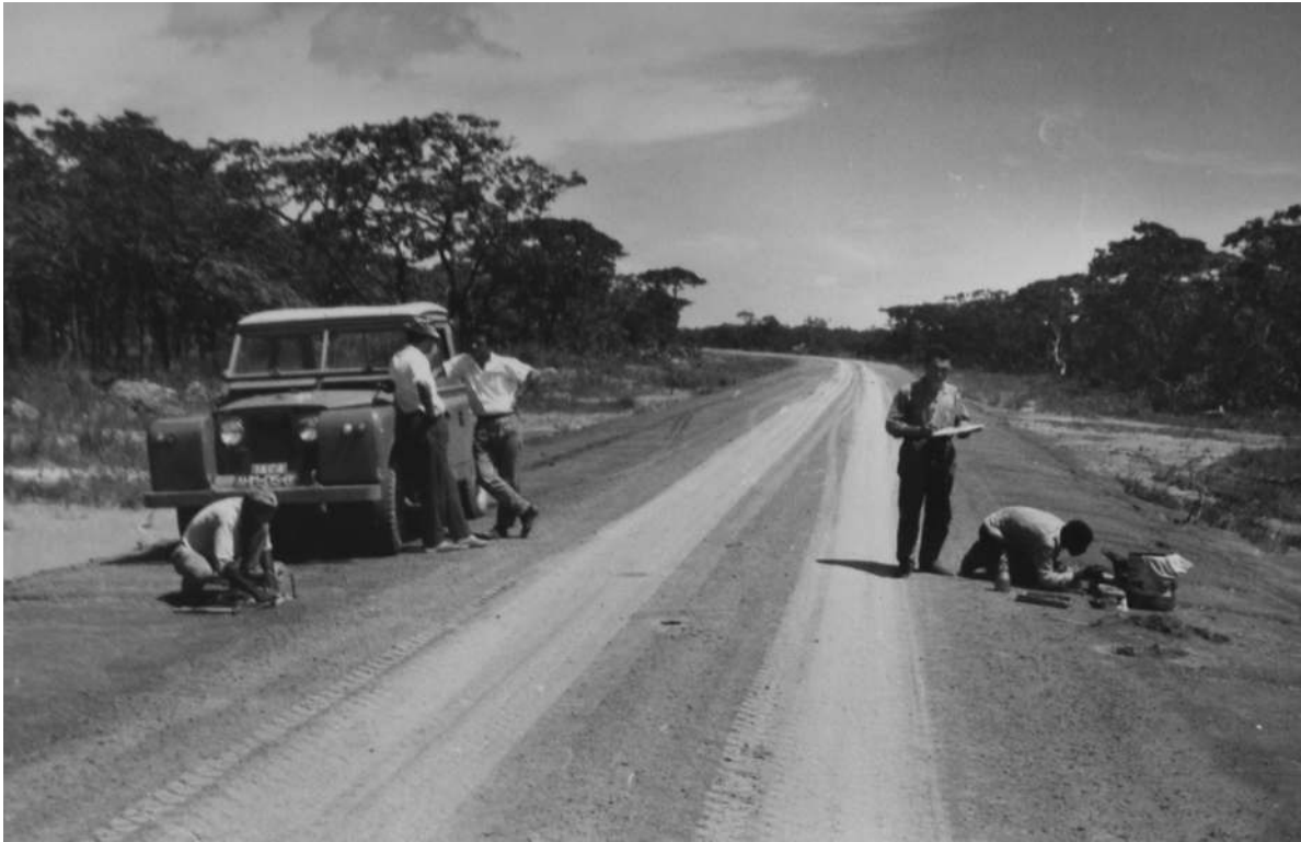
Estrada Luzamba-EN Malange/Henrique Carvalho. Realização de testes para determinação de percentagens de densidade. Ensaios realizados por pessoal especializado do Departamento de Mecânica de Solos da JAEA [Relatório Anual da DSOVC, 1967. UC/AD]
