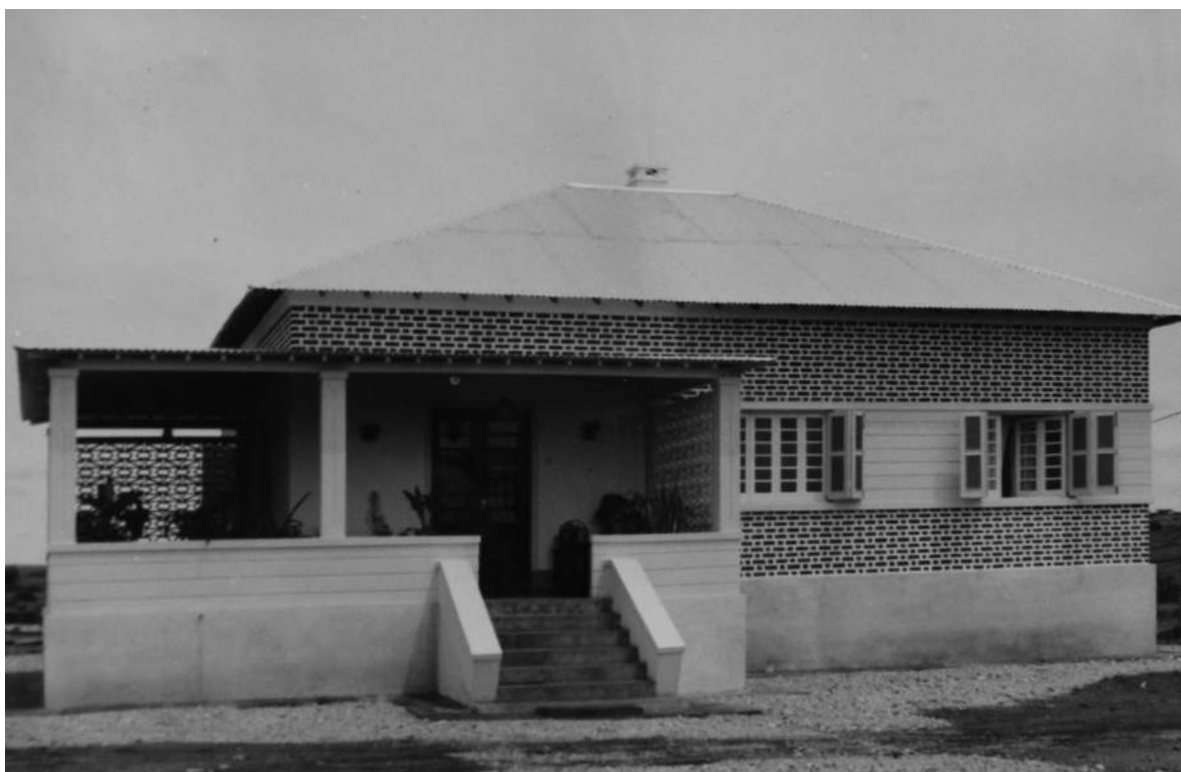
Casa de habitação para empregado K-269. Edifício novo (novo talhão) [Relatório Anual da DSOVC, 1967. UC/AD]
