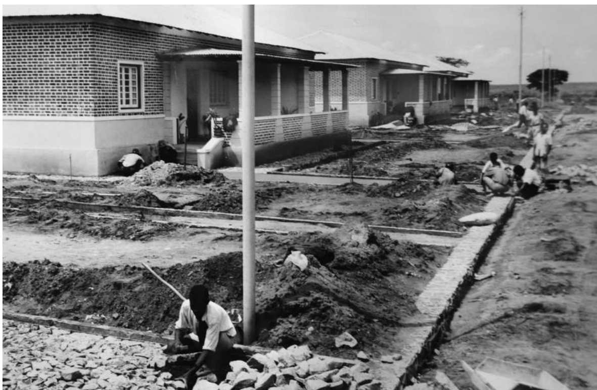
Durante as obras de urbanização do Bairro Sul [Relatório Anual da Concessão do Dundo, 1964. UC/AD]
