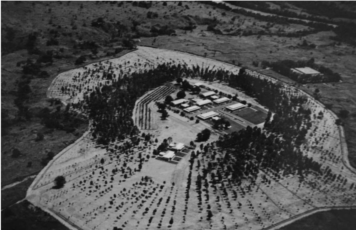
Vista aérea do Hospital do Sacavula [Serviços de Saúde, 1970. UC/AD]
