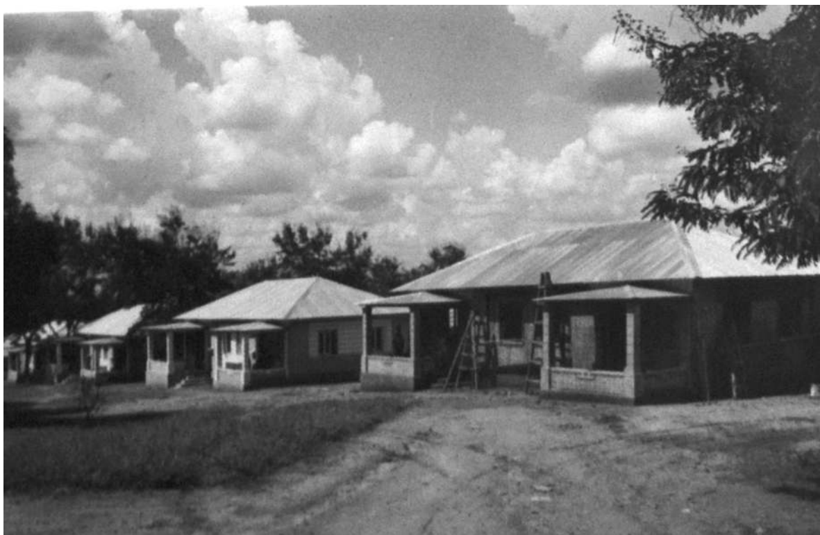
Casas geminadas de habitação para assimilados. Aspecto do conjunto [Construção e reparação de edifícios, 1950-53. UC/AD]
