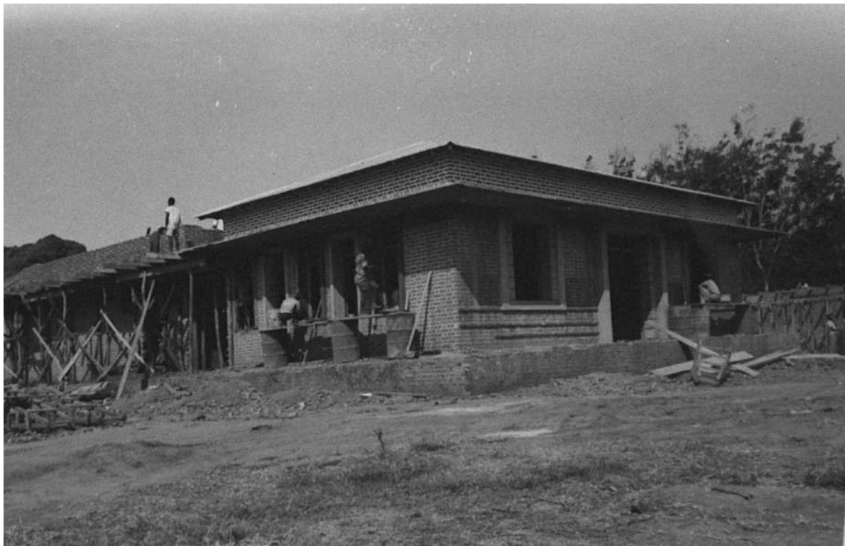
Casa do Pessoal, Andrada. Fachadas sul-poente (em construção), 1951 [Construção e Reparação de Edifícios, 1950-53. UC/AD]
