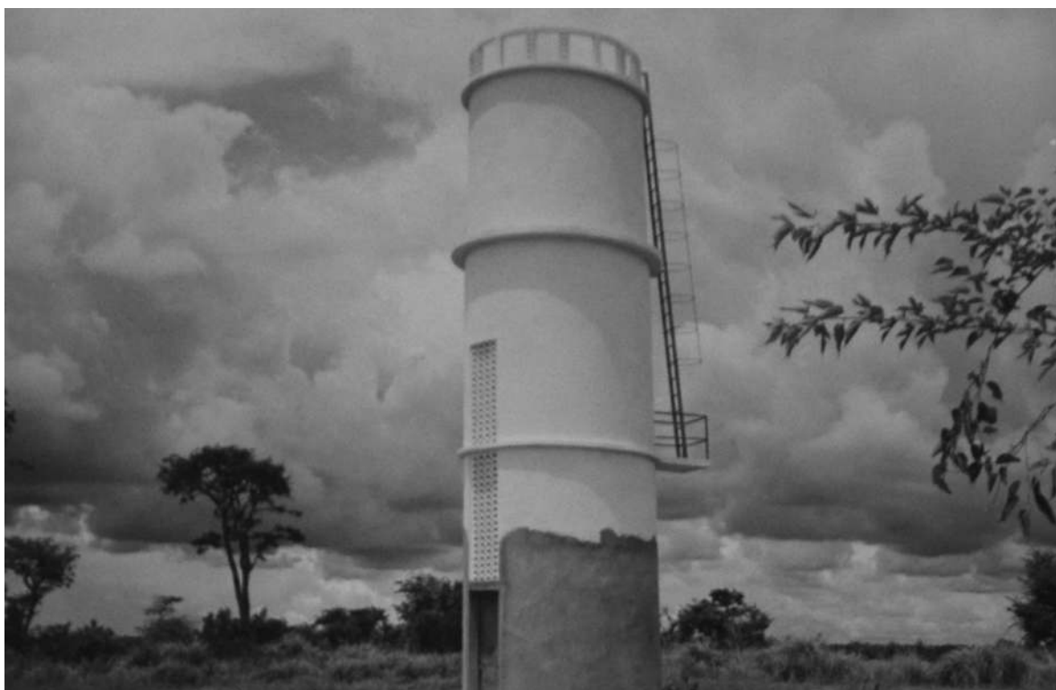
Depósito de água elevado no Luia [Construção e Reparação de Edifícios, 1964-65. UC/AD]
