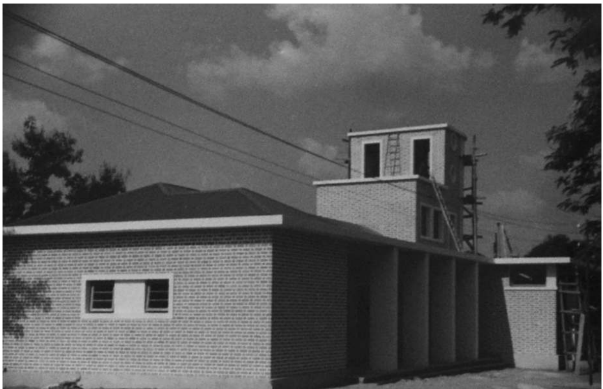
Estação Meteorológica. Alçados sul e ponte [Construção e reparação de edifícios, 1950-53. UC/AD]
