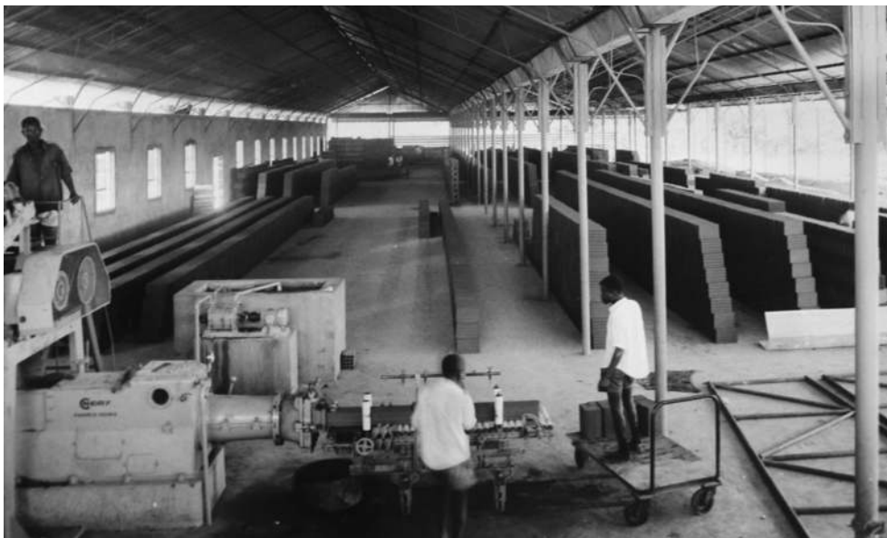
[135] Dundo-Luachimo: antigas casas metálicas préfabricadas, remodelação, 1967 [136] Reconstrução de arruamento no Dundo sob orientação técnica da DSOVC, 1967 [137] Cerâmica do Luzamva, vista da zona de moldagem e secagem, 1969 [Relatório Anual da DSOVC, 1967-69. UC/AD]
