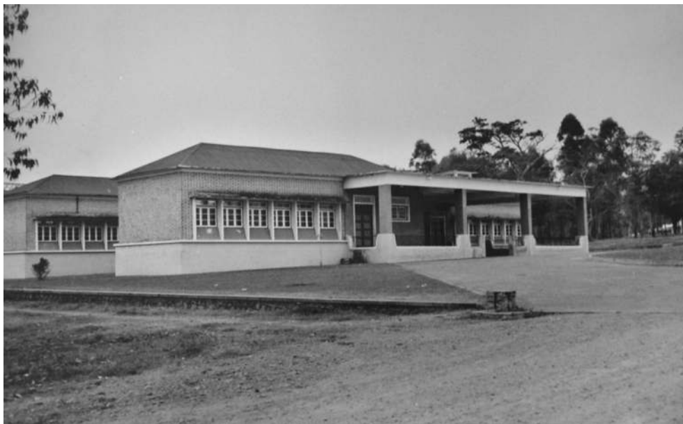
[58] Vista parcial do bloco escolar de Caxinde, no Dundo, 1970 [Dossier para a Organização Internacional do Trabalho, UC/AD]
