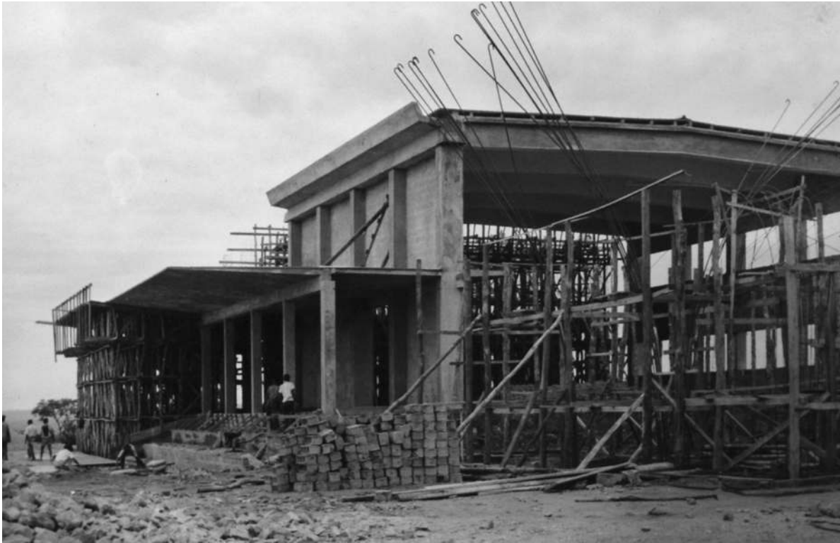
Casa do Pessoal, Lucapa; início dos trabalhos do corpo central [Relatório anual da DSOVC, 1967. UC/AD]
