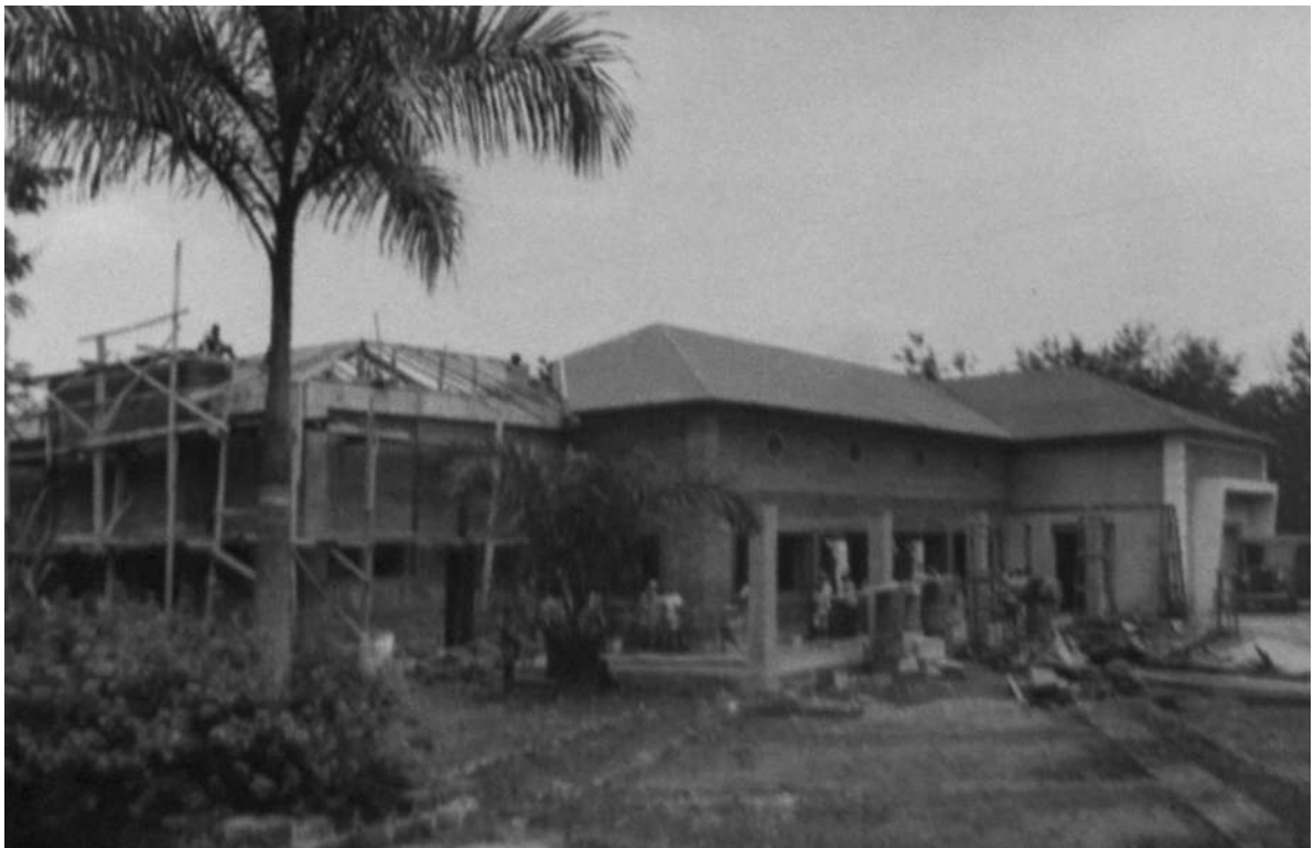
Casa do Pessoal, Andrada. Fachadas sul-poente em construção, 1950 [Construção e Reparação de Edifícios, 1950-53. UC/AD]
