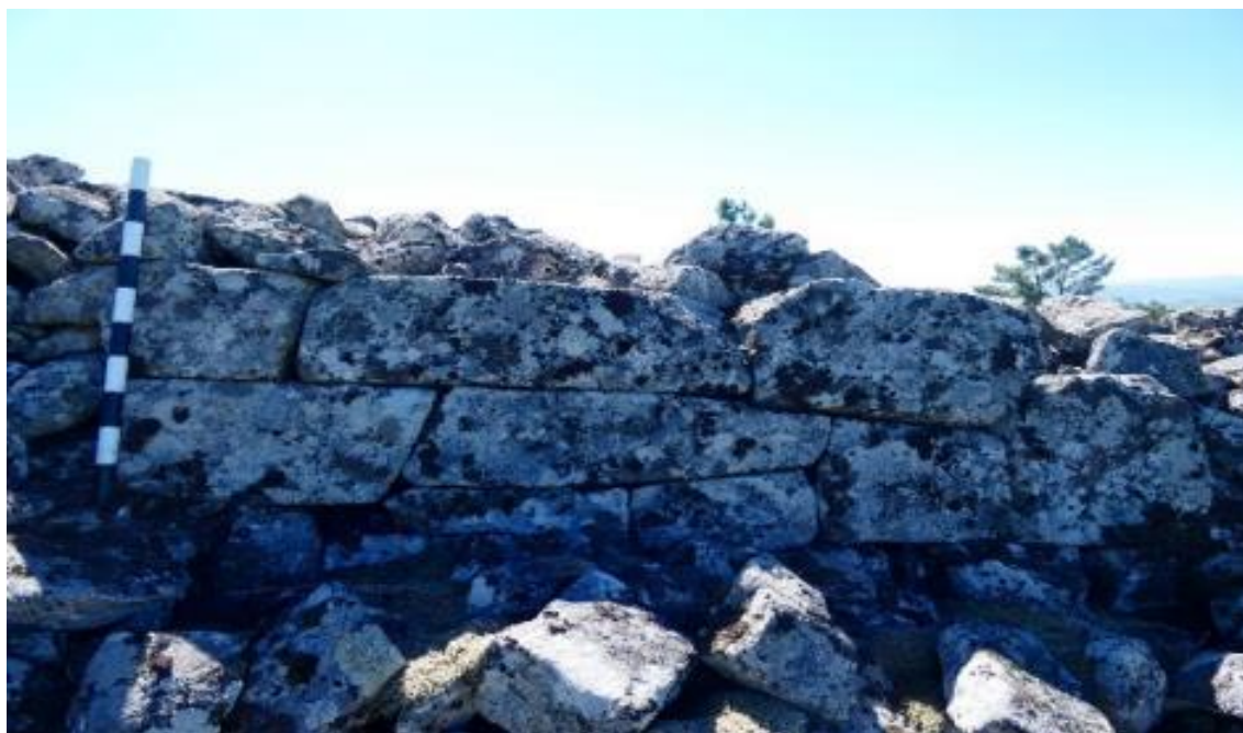
Figura 40 – Colocação de blocos ciclópicos na base da muralha de Vilarelho
