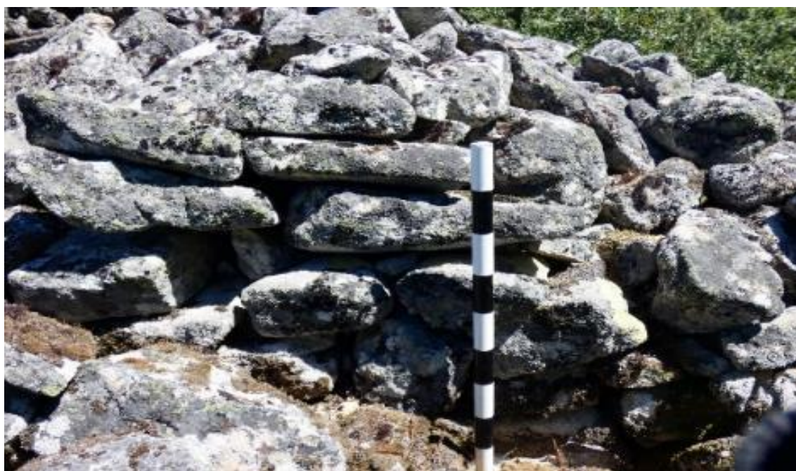
Figura 43 - Face interna da muralha de Vilarelho, aparelho irregular composto por pedra “natural”
