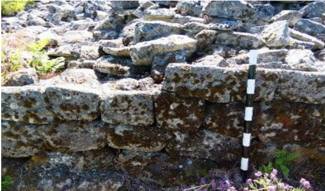
Figura 41 – Face externa da muralha de Vilarelho, aparelho regular, facetado e blocos com vértices suavizados
