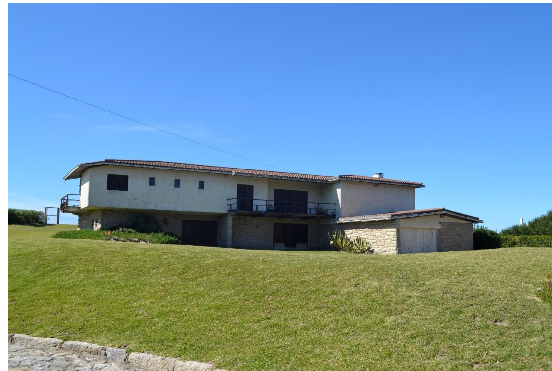
Figura 67: Casa Pimenta Machado, arquiteto Júlio de Oliveira, 1964. Fotografia do autor.
