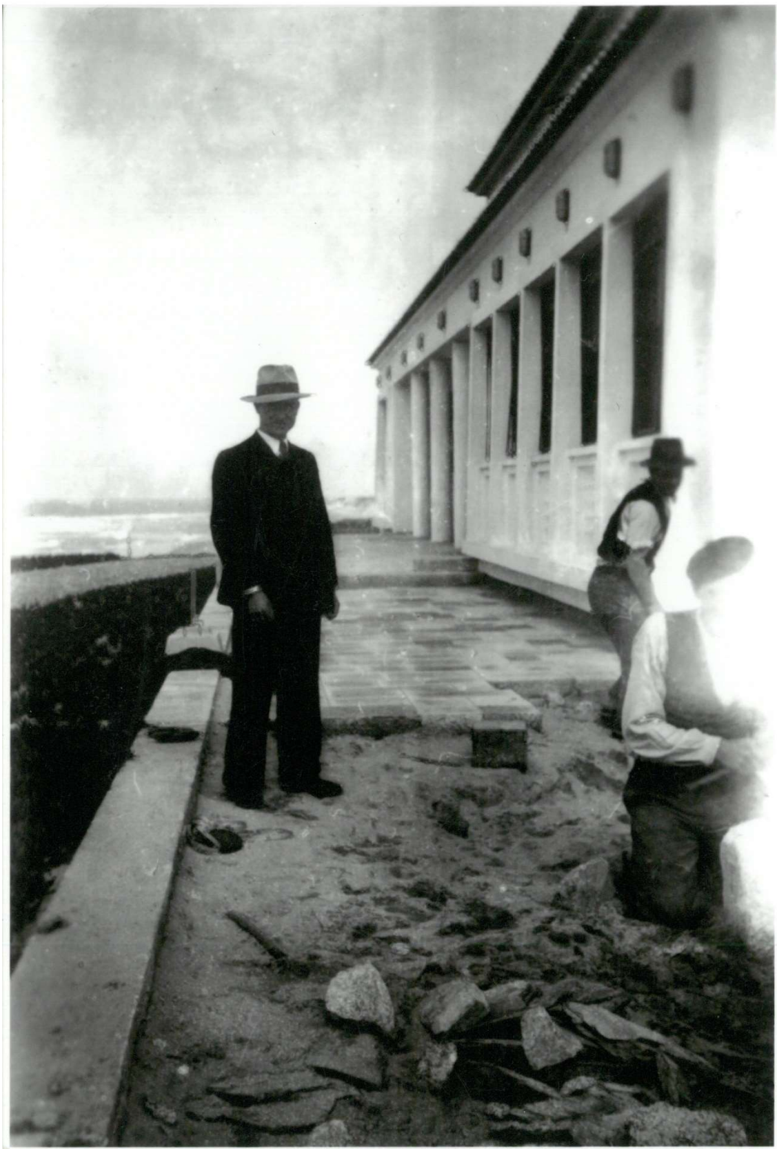
Figura 30: António Pereira de Vilar na construção do Restaurante de Ofir, em 1945.
