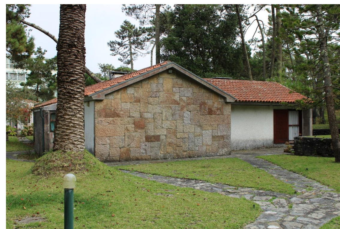
Figura 82: Casa Marília Vasconcelos, arquiteto Júlio de Oliveira, 1961.
