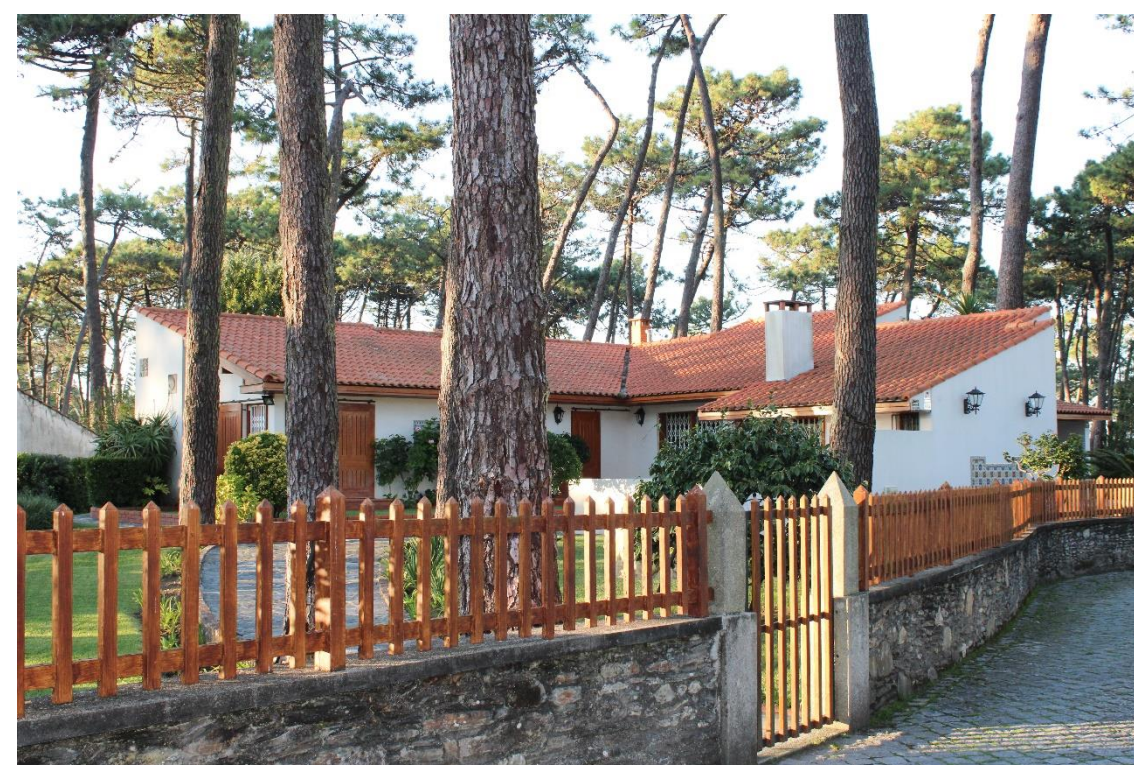
Figura 86: Casa Pina Cabral, arquiteto Magalhães Carneiro, 1965.
