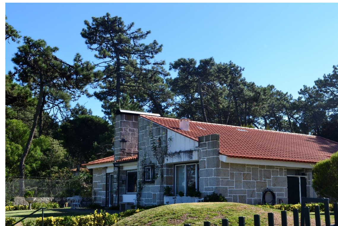
Figura 76: Casa Alberto Pimenta, arquiteto António Bandeira, 1958.
