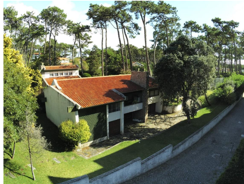
Figura 66: Casa José Ribera, arquiteto Carlos Neves e arquiteto António Bandeira, 1957. Fotografia de drone, por Gabriel Capitão.
