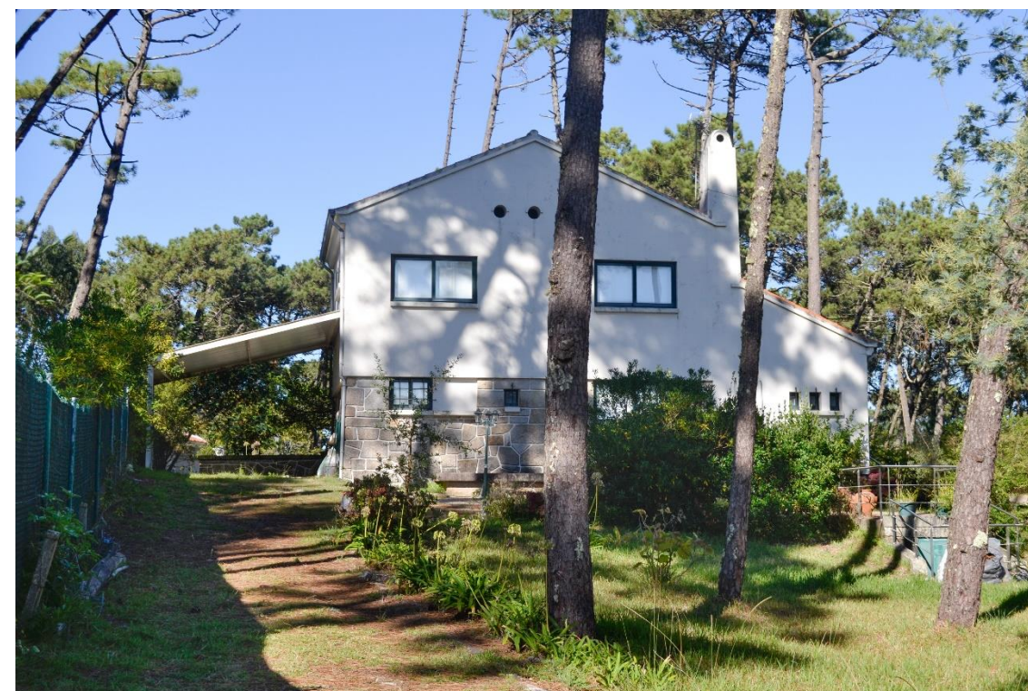
Figura 55: Casa Artur Aires II, arquiteto Alfredo Ângelo de Magalhães, 1948.
