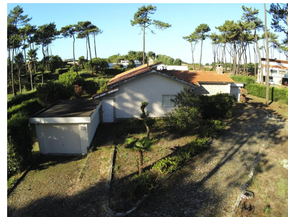
Figura 74: Casa Pereira Garcia, arquiteto Ângelo de Magalhães, 1959. Fotografia de drone, por Gabriel Capitão.
