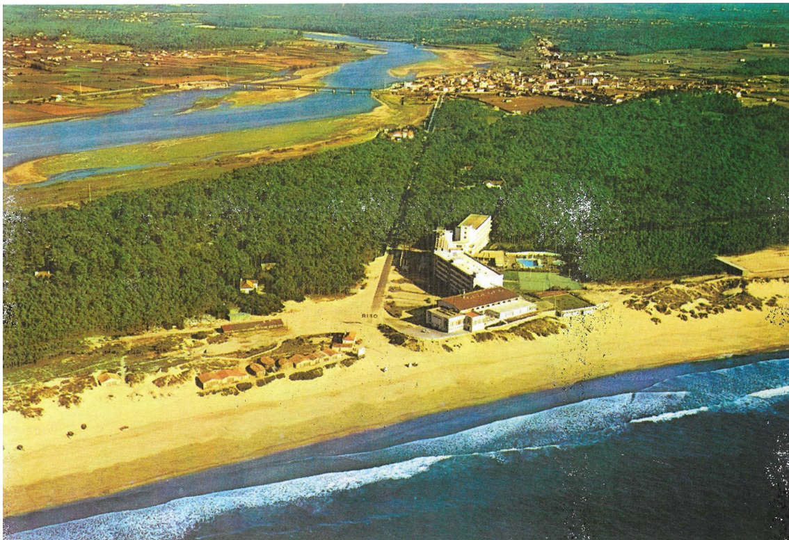
Figura 14: Conjunto de pré-existências dispostas junto à praia de Ofir. Na imagem é possível ver as Barracas dos Pescadores junto à praia, a Casa da Floresta inserida na mancha de pinhal e, imediatamente a seguir ao letreiro de Ofir, o Quartel da Guarda Fiscal.
