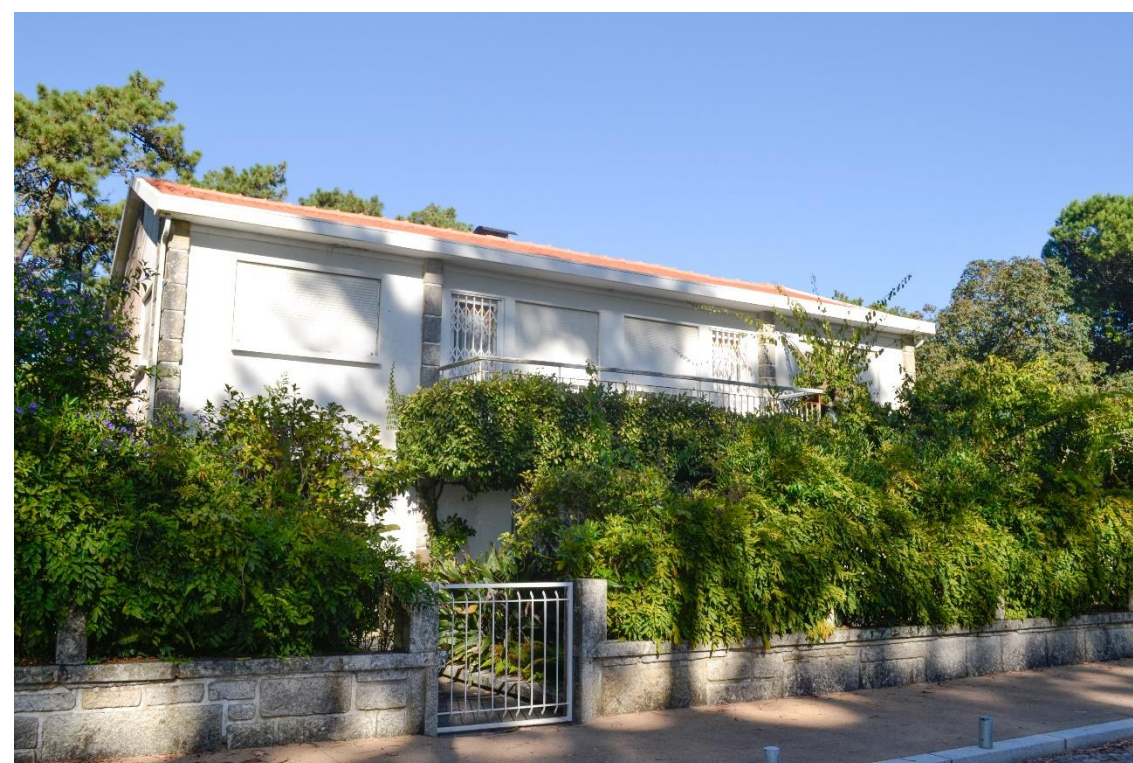
Figura 57: Casa Pereira de Vilar, arquiteto Alfredo Ângelo de Magalhães, 1958.
