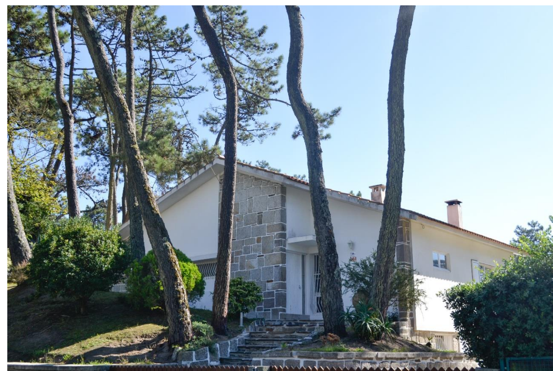
Figura 92: Casa Silva Barbosa, arquiteto Márcio de Freitas, 1962.
