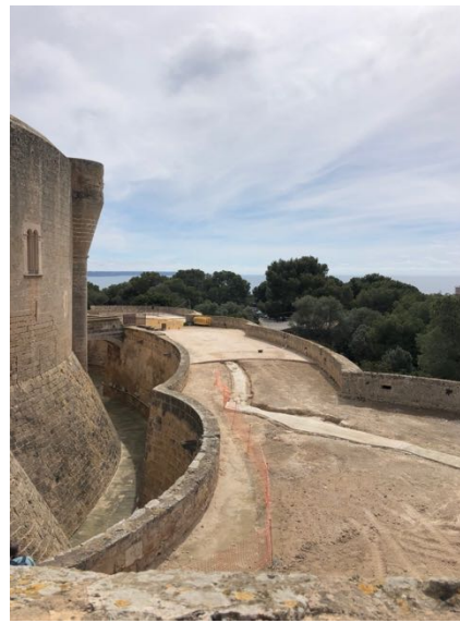
Figura 13 - Exterior do castelo, fosso e muralha adicional Fonte: autoria própria (2023)
