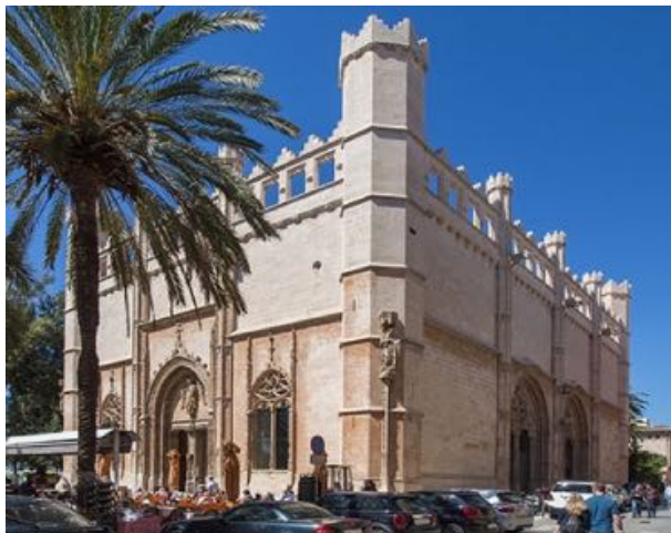
Figura 16 - Visão frontal e lateral do edifício. Fonte: Minkner.org através do Google Imagens, consultado em 2023
