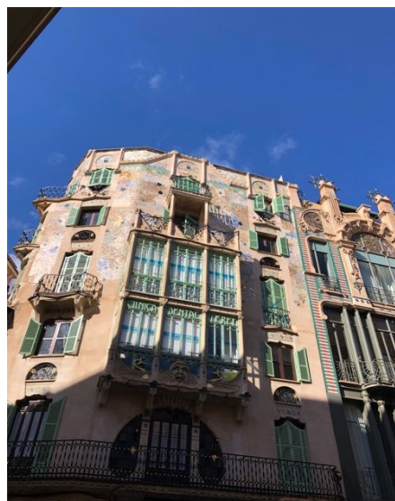
Figura 20 - Visão lateral do edifício Fonte: autoria própria (2023)
