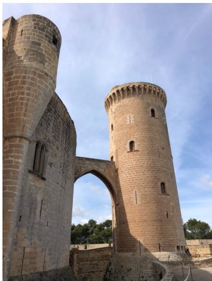
Figura 12 - Exterior do Castelo, juntamente com a Torre Fonte: autoria própria (2023)
