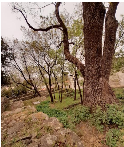
Figura 33: caminho de ronda da barbacã, nas Ruínas da Colegiada do Castelo de Leiria.
