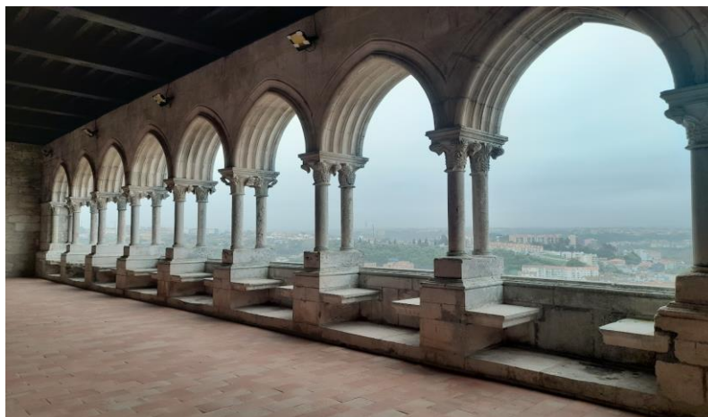
Figura 36: galeria ( loggia ) voltada a sul, composta por 8 arcos em ogiva. Símbolo icónico do Castelo de Leiria.
