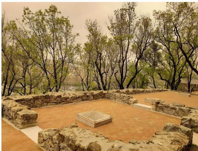
Figura 26: parte superior das Cisternas do Castelo de Leiria.
