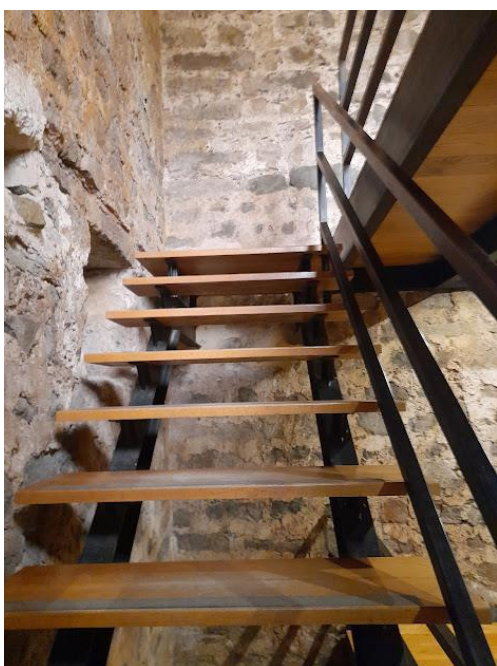
Figura 31: escadas localizadas no interior do Castelo de Leiria que, atravessando vários pisos, dão acesso ao topo da torre.
