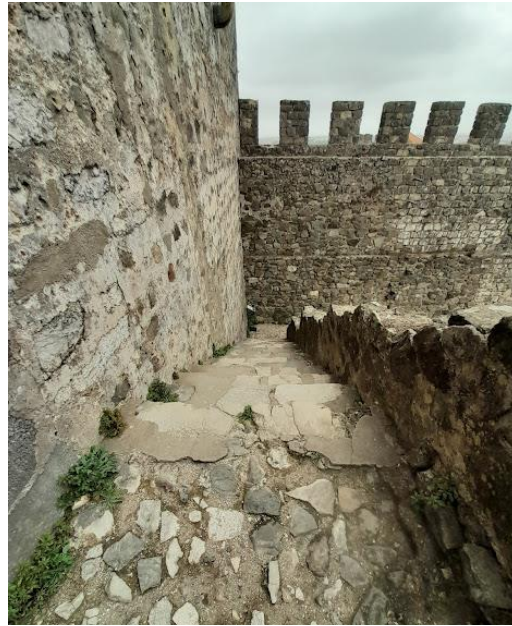
Figura 29: escadas que ligam o exterior ao interior da Torre de Menagem do Castelo de Leiria.
