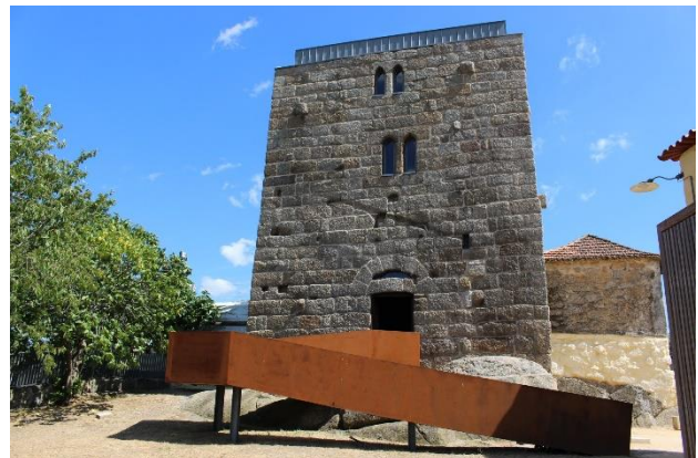
Torre dos alcoforados, Paredes https://www.rotadoromanico.com/pt/monumentos/torre-dos-alcoforados/
