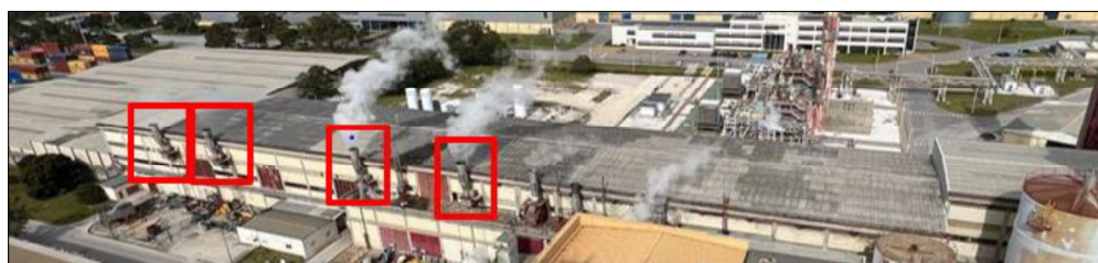
Figura 3.2 – Exaustões da máquina de pasta.
