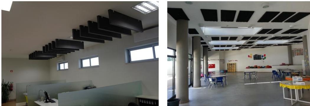
Figura 2-21 - Exemplos de “Baffles” absorventes
