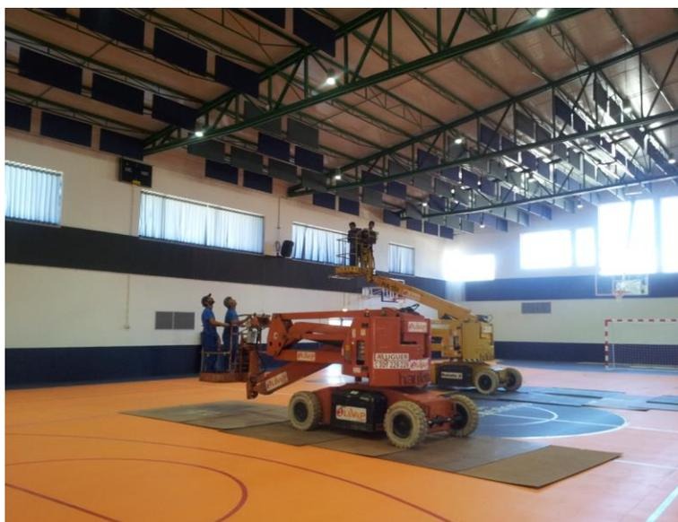
**Figura 2-17** - Exemplo de “Baffles” absorventes em tecido
