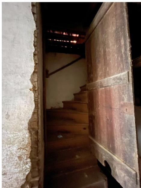
Figura 4.2 Parede de tabique e escadas para o piso superior
