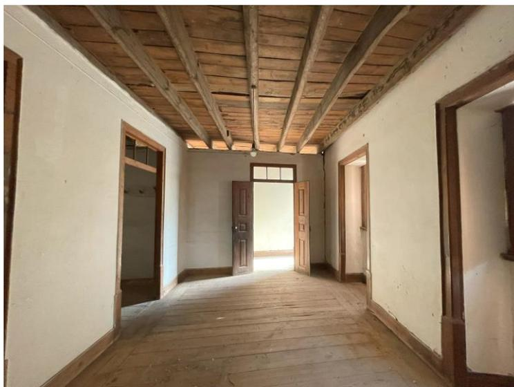
Figura 4.1 Barrotes e soalho do pavimento do piso superior (note-se o apoio na parede)
