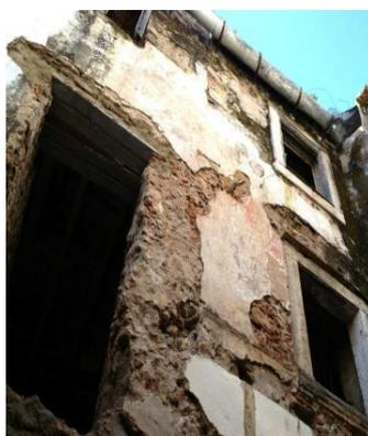
Figura 2.1 Parede de alvenaria de pedra (Simão, 2017)
