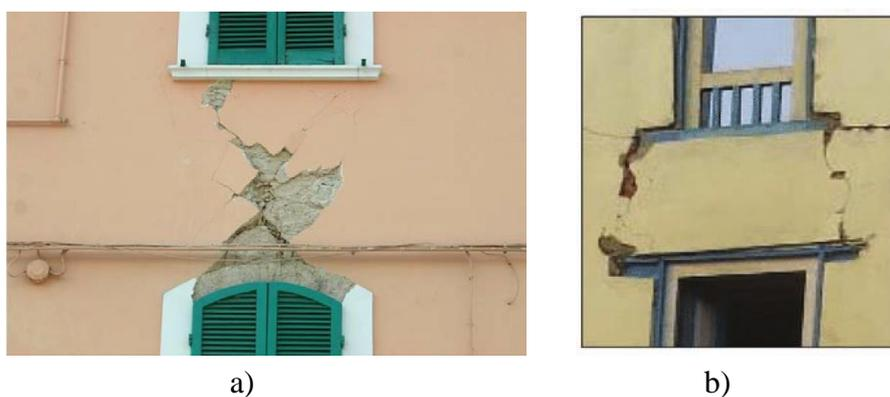
Figura 2.8 Mecanismos de rotura dos lintéis: a) fendilhação diagonal; b) oscilação por flexão (Beyer & Alessandro, 2012)
