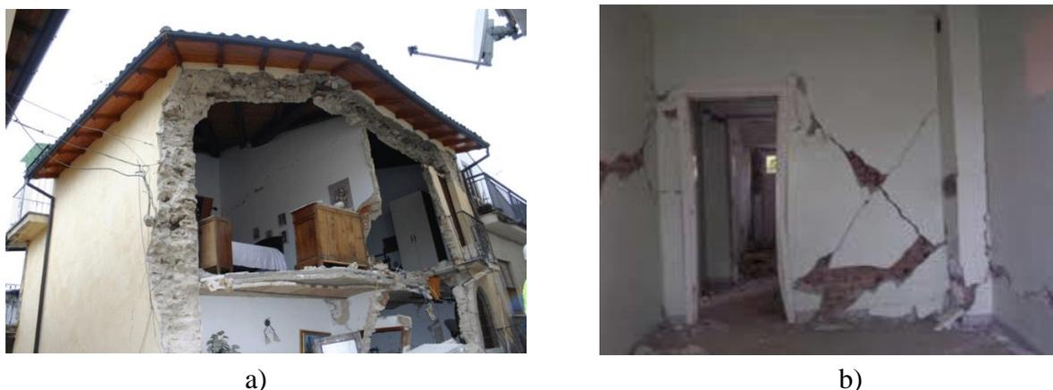
Figura 2.4 Evidência da ocorrência de mecanismos de colapso: a) para fora do plano (L’Aquila, Itália, 2009); b) no plano (Turquia, 2023)
