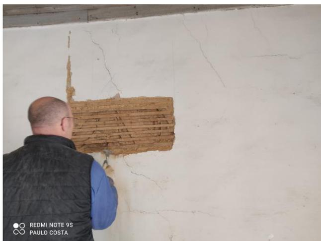
Figura 2.9 Janela de Inspeção em parede interior de tabique (Santa Comba Dão)
