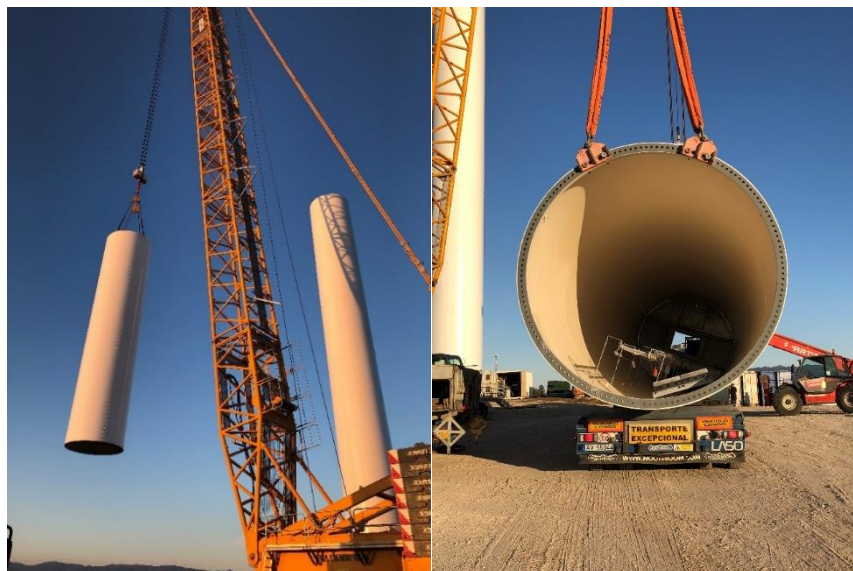
Figura 2.7 – Fotografias de troços de uma torre da Martifer Renewable & Energy.
