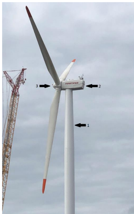
Figura 2.1 – Componentes principais da turbina eólica Suzlon S88 (2,1MW) Martifer (1- Torre; 2- Nacelle ; 3- Rotor)
