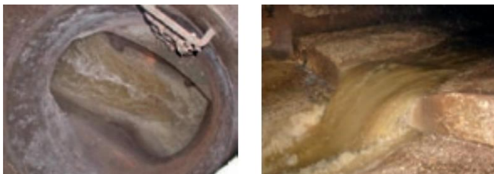
Figura 8 - Desgaste devido à alteração do tipo de escoamento (Almeida & Cardoso, 2010).
