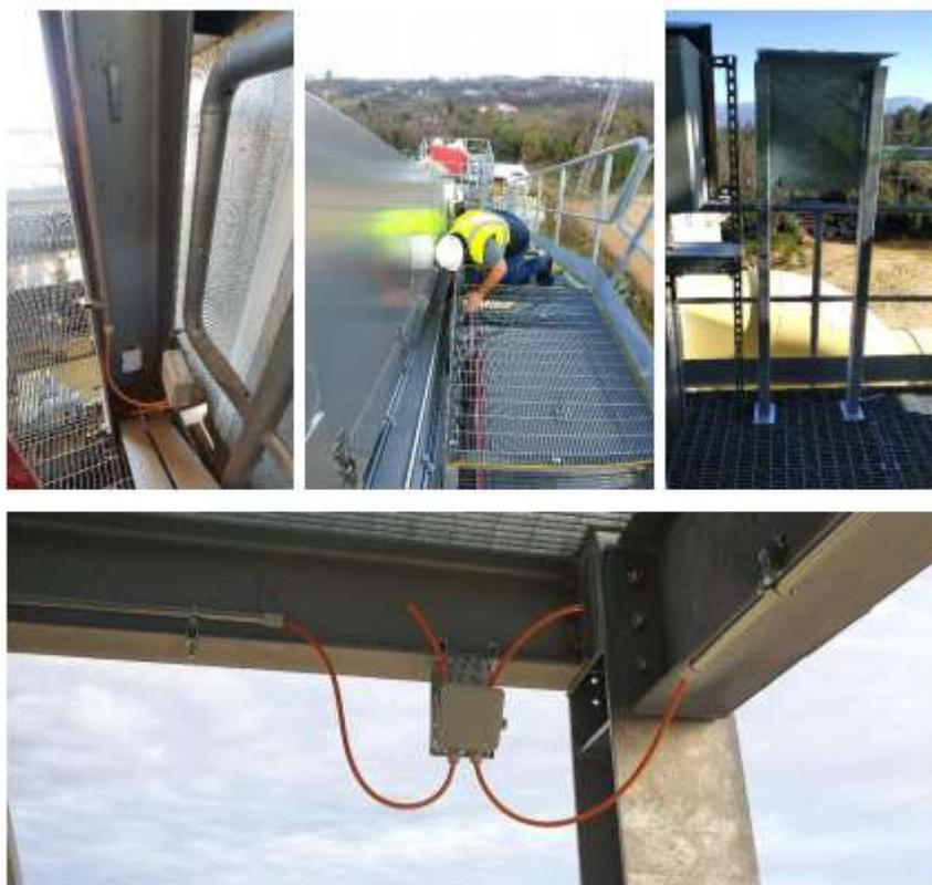
Figura 4.19 – Processo de instalação do sistema de monitorização, (MIRA Systems, 2021).
