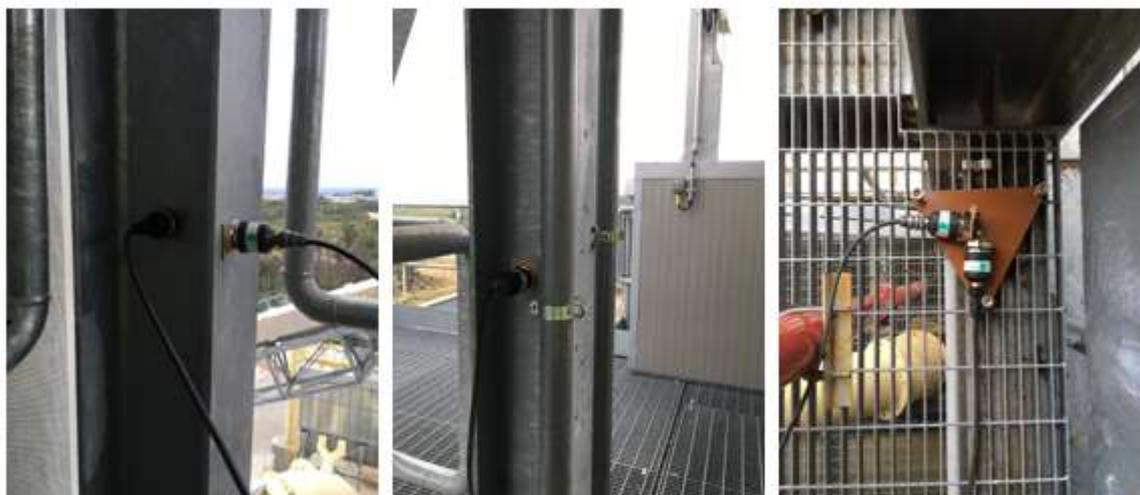
Fotografia 4.2 – Lado esquerdo: acelerómetros referência 955 e 556 em C1; Meio: acelerómetro referência 917 em C2; Lado direito: acelerómetros itinerantes 915 e 914, igual disposição em C3, C4, C5 e C6 (Peres, 2019).
