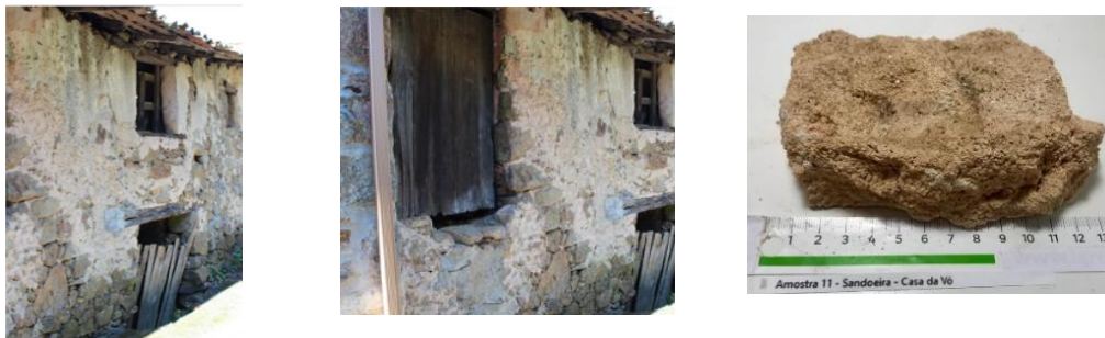
Figura 6 - Coleta de Amostras de Argamassa – Sandoeira (2) – Distrito de Coimbra
