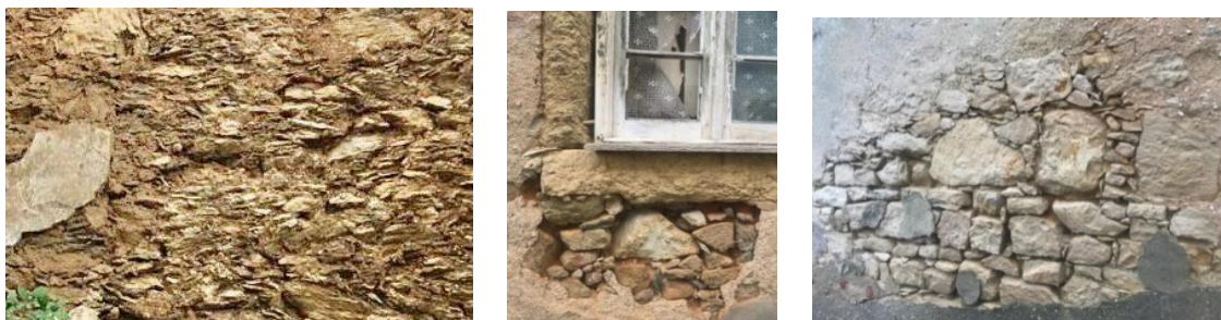
Figura 2 – Exemplos de paredes em pedra irregular ou ordinária, encontradas na região de Coimbra.
