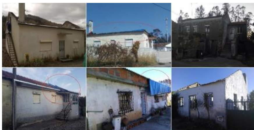
Figura 2.10. Exemplos de habitações que arderam pelo telhado [34].
