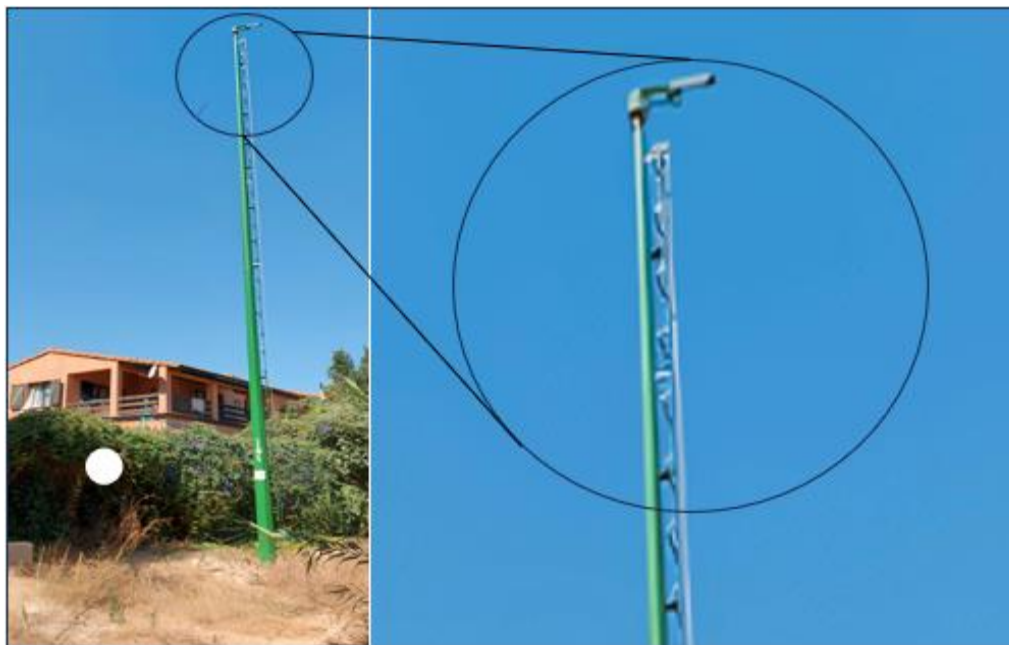
Figura 1.6. Aspersor instalado no projeto GUARDIAN, ampliado à direita [11]
