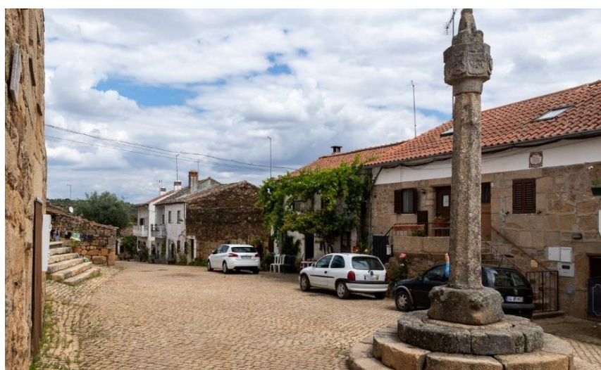
Figura 8. Pavimentação das ruas da aldeia histórica portuguesa Idanha a velha, em cubo de granito, 2020.
