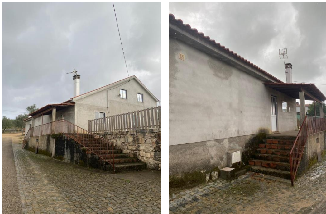
Figuras 57 e 58. Escadas de acesso à instalação do Centro Recreativo, Cultural e Desportivo do Casmilo, 2022.
