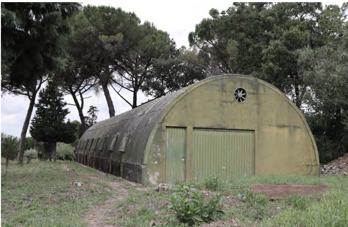
Figura 19 - Fotografia da oficina, lado nascente
