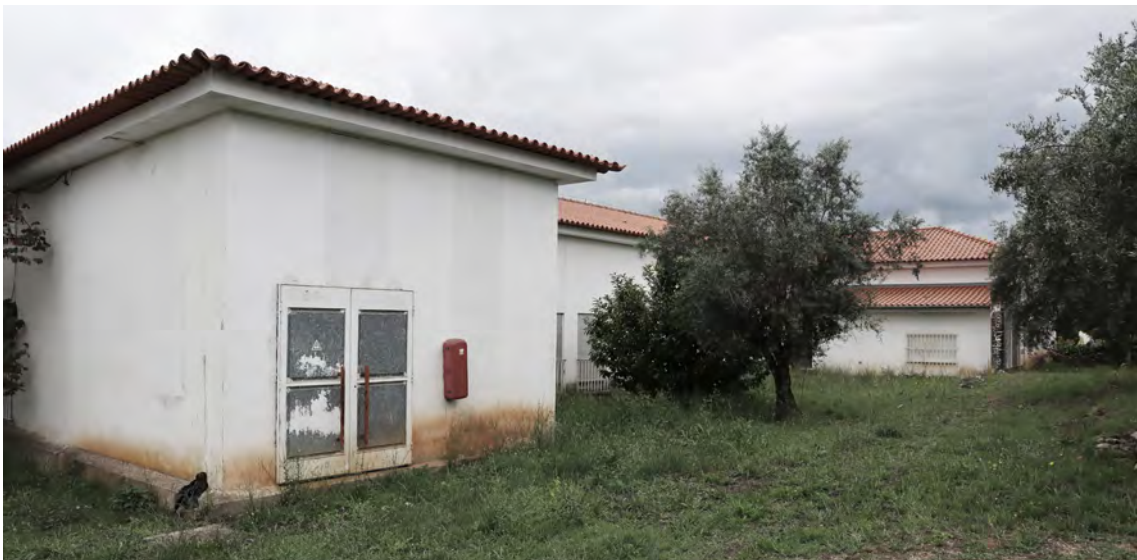
Figura 14 - Fotografia da fachada de apresentação
