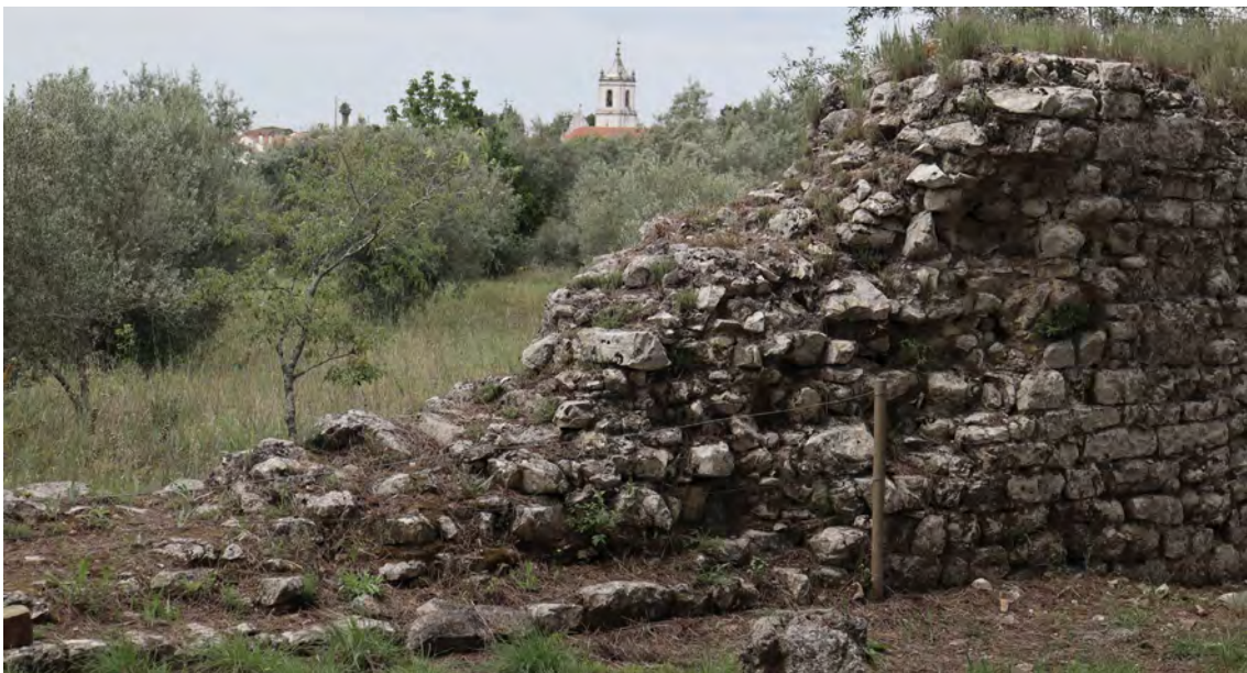
Figura 24 - Fotografia da muralha augustana junto ao museu com a igreja ao fundo
