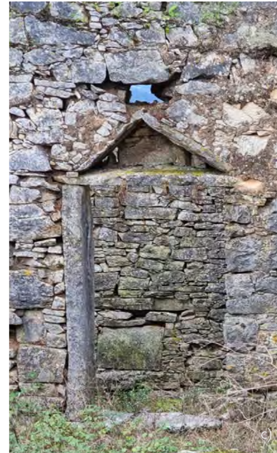
Figura 27. Padieiras: a) Com elemento horizontal de pedra; b) Com elemento horizontal de madeira; c) Em triângulo; d) Em arco. 2021. Joana Ramos ©
