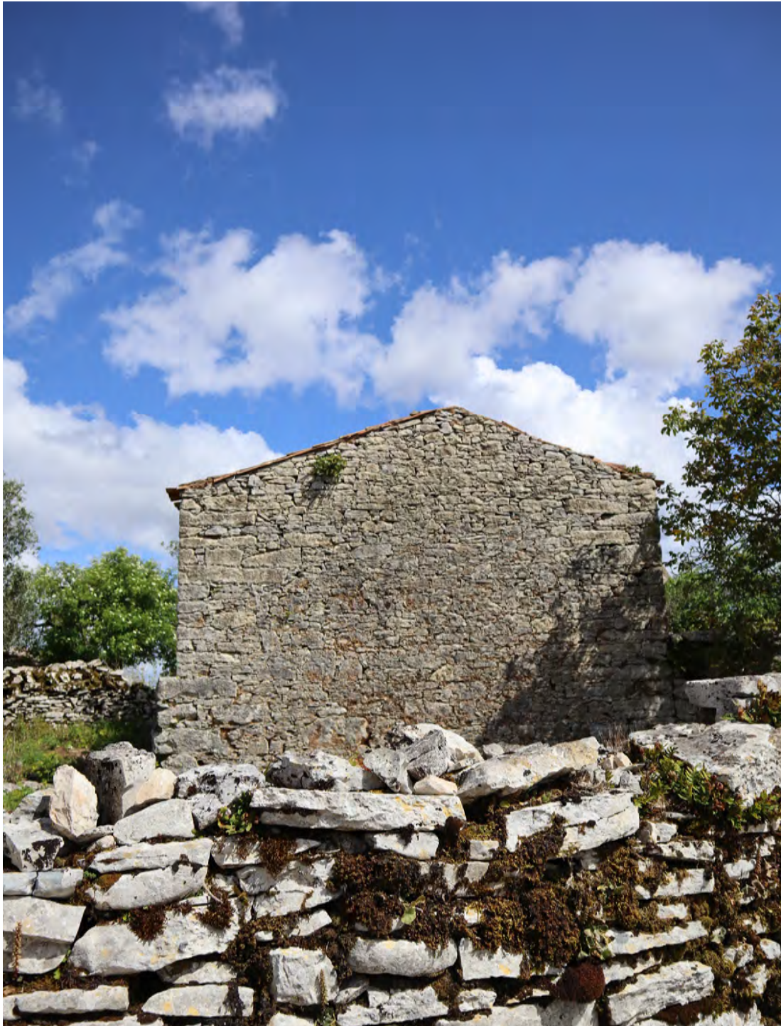
Figura 18. Edifício em Chanca, exemplificativo das alvenarias de pedra seca típicas da arquitetura vernacular de Sicó. Chanca. 2023. Joana Ramos ©
