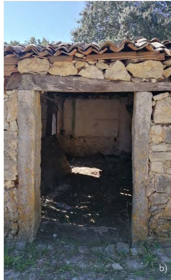
Figura 27. Padieiras: a) Com elemento horizontal de pedra; b) Com elemento horizontal de madeira; c) Em triângulo; d) Em arco. 2021. Joana Ramos ©
