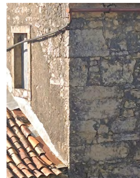
Figura 25. Colocação das pedras dos cunhais ao cutelo. 2022. Joana Ramos ©
