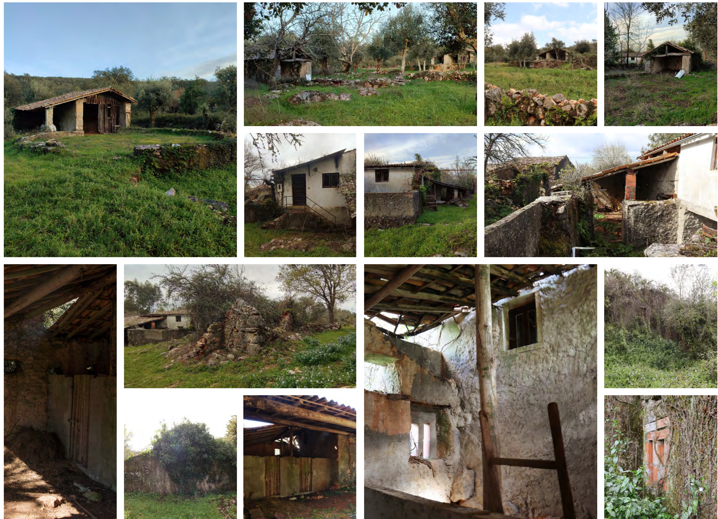
Figura 75. Casas de eira e edifício que se propõe demolir. Ariques, 2022. Joana Ramos ©
