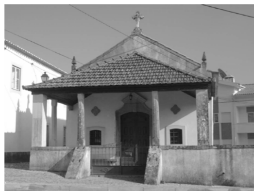
Figura 97. Capela de S. Lourenço (Penela). 2023
