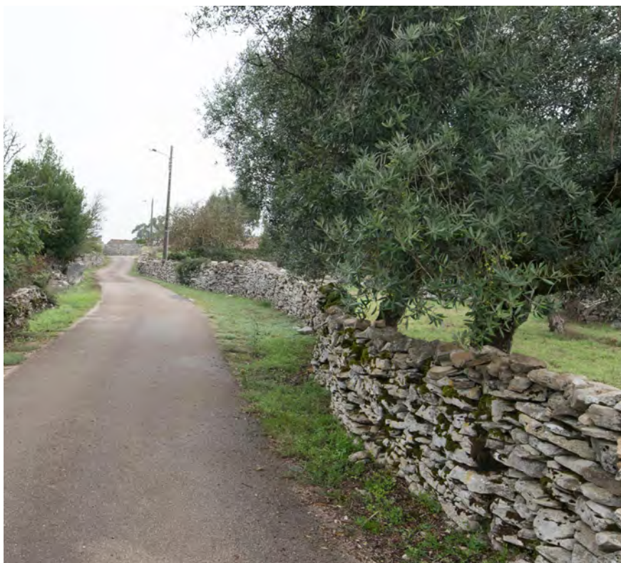
Figura 23. Muros de pedra seca. Chanca. 2021. Joana Ramos ©
