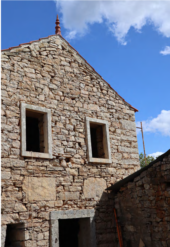
Figura 38. Edifício em processo de reabilitação- Chanca. 2023. Joana Ramos ©
