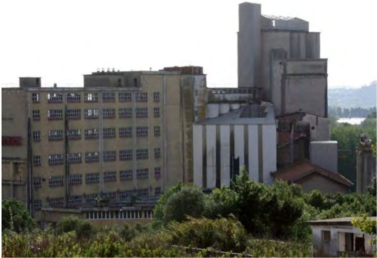
Figura 14. Estado atual dos edifícios da Fábrica Triunfo Rações
