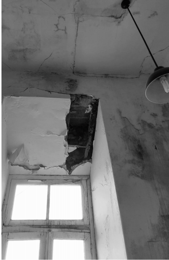
Figura 3. Estado atual do D'arq
