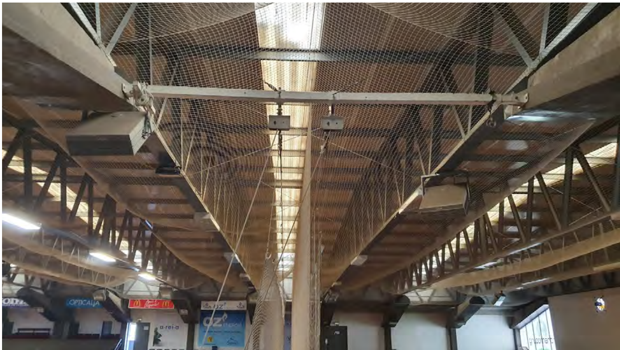
Imagem 57. Treliças bidimensionais e tela divisora de uma arena desportiva. Pavilhão Municipal de Paços de Ferreira
