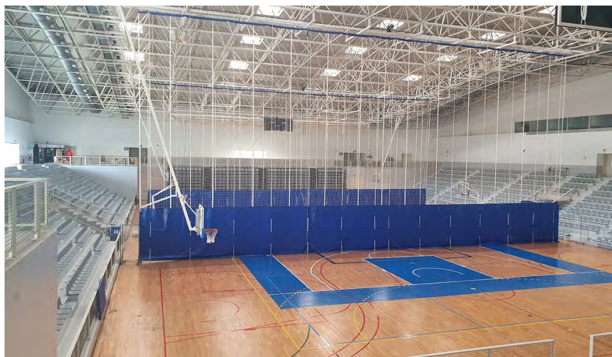
Imagem 17. Pavilhão do Centro Desportivo de Cornella, Álvaro Siza, 2005. Imagem onde se percebe a separação da arena em duas partes através de lonas recolhíveis.
