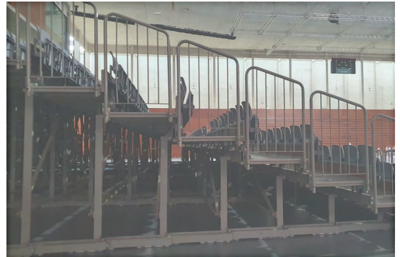
Imagem 54. Promenor da estrutura das bancadas telescópicas, Pavilhão Multiusos de Guimarães
