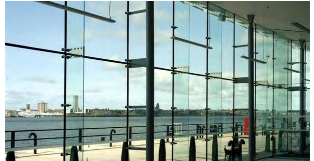
Imagem 53. Aletas de vidro no terminal de cruzeiros de Liverpool
