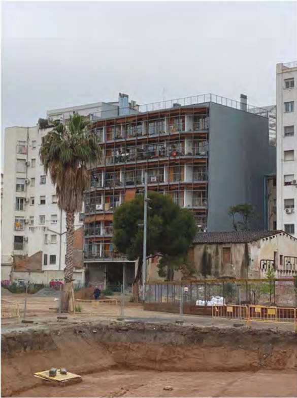
Figura 22 — Fachada Sul do La Borda
