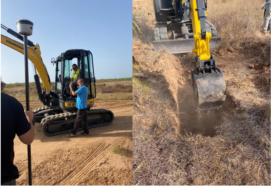
Figura 3.2 – Retroscavadora utilizada para a realização das oito trincheiras localizadas no local de estudo (Verde Lago, Algarve).
