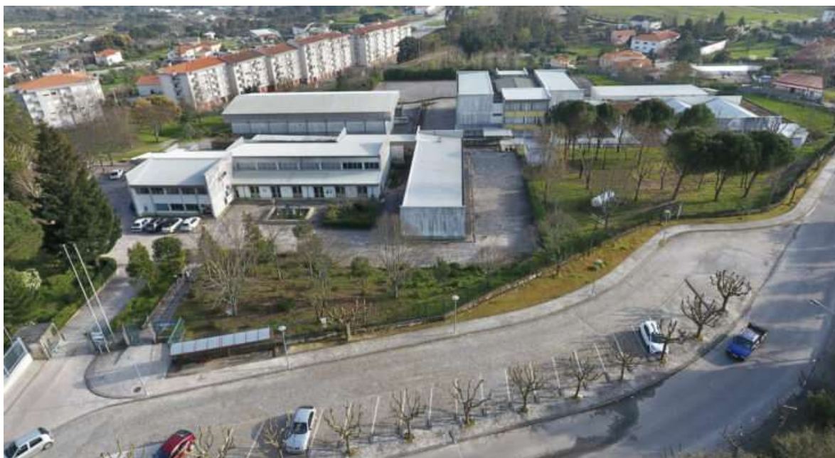
[Imagem nº 1: panorâmica da Escola Secundária de Nelas (fonte: Câmara Municipal de Nelas)]
