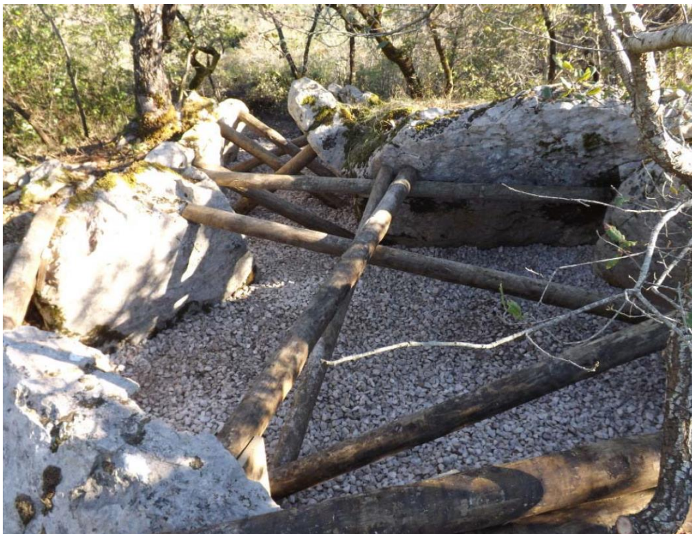
Est. XXX – Fotografia retirada ao momento da intervenção de consolidação em 2012: vista dos barrotes de suporte dos esteios e da brita colocada a cobrir o piso, na câmara funerária da Anta (ROCHA, 2012, p.7).
