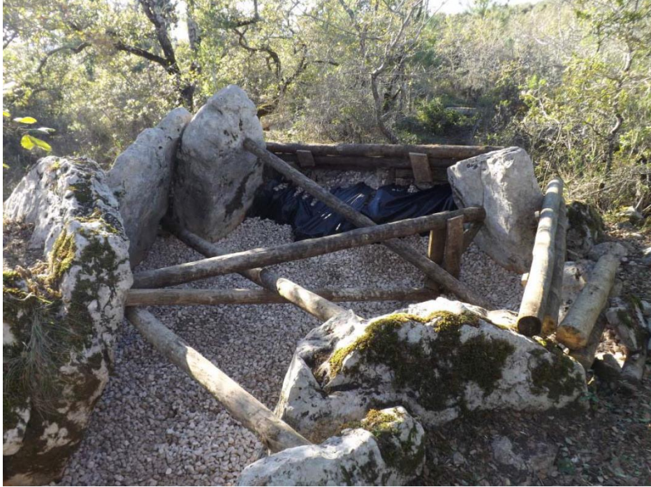
Est. XXXI – Fotografia retirada ao momento da intervenção de consolidação em 2012: vista dos barrotes de suporte dos esteios e dos colocados na lateral da câmara funerária; é ainda visível a brita colocada no piso e parte do plástico colocado na cabeceira (ROCHA, 2012, p.7).
