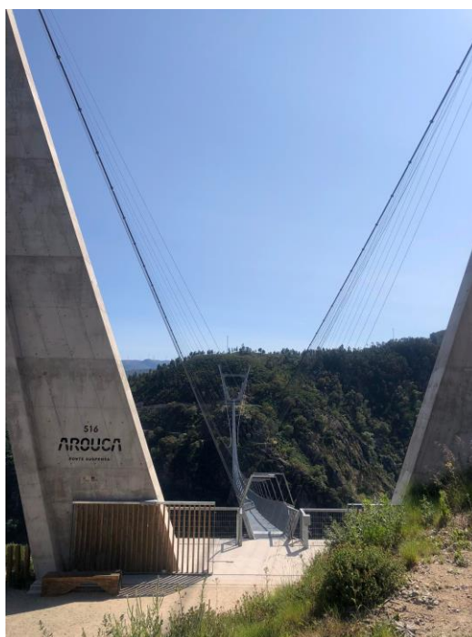
Figura 20 - Ponte 516 Arouca. Fonte própria.
