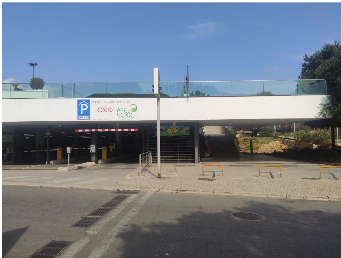
Fotografia nº 4 – Vista frontal do local: o parque de estacionamento no nível térreo, o campo de mini golfe na parte superior e o sítio do Vale da Gafaria à direita do edifício, passando despercebido. Fotografia do autor.
