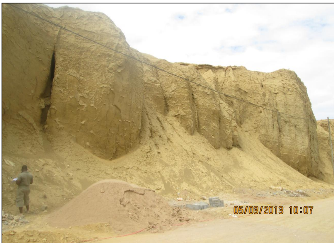
Figura 5.6 - Tipos de instabilidades mais frequentes, erosão intensa e acção antrópica.
