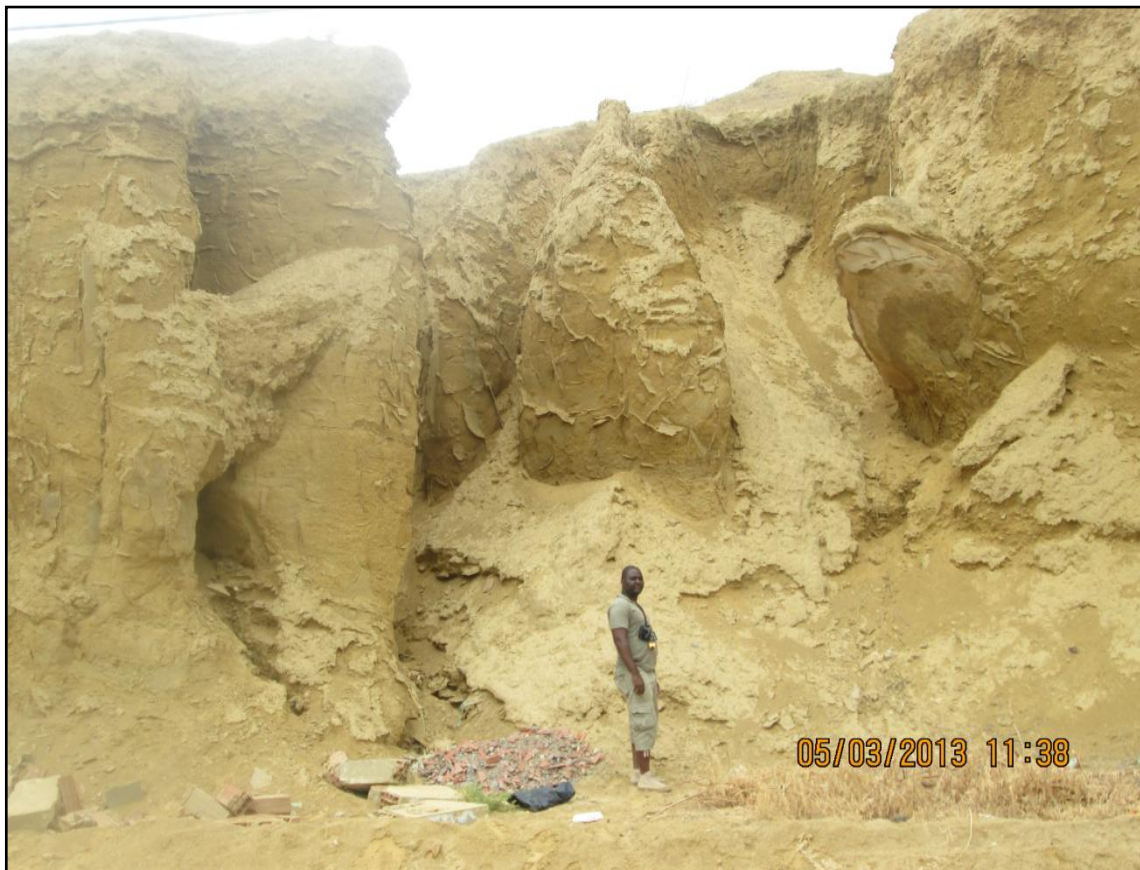
Figura 5.7 - Imagem ilustrativa da instabilização da área.
