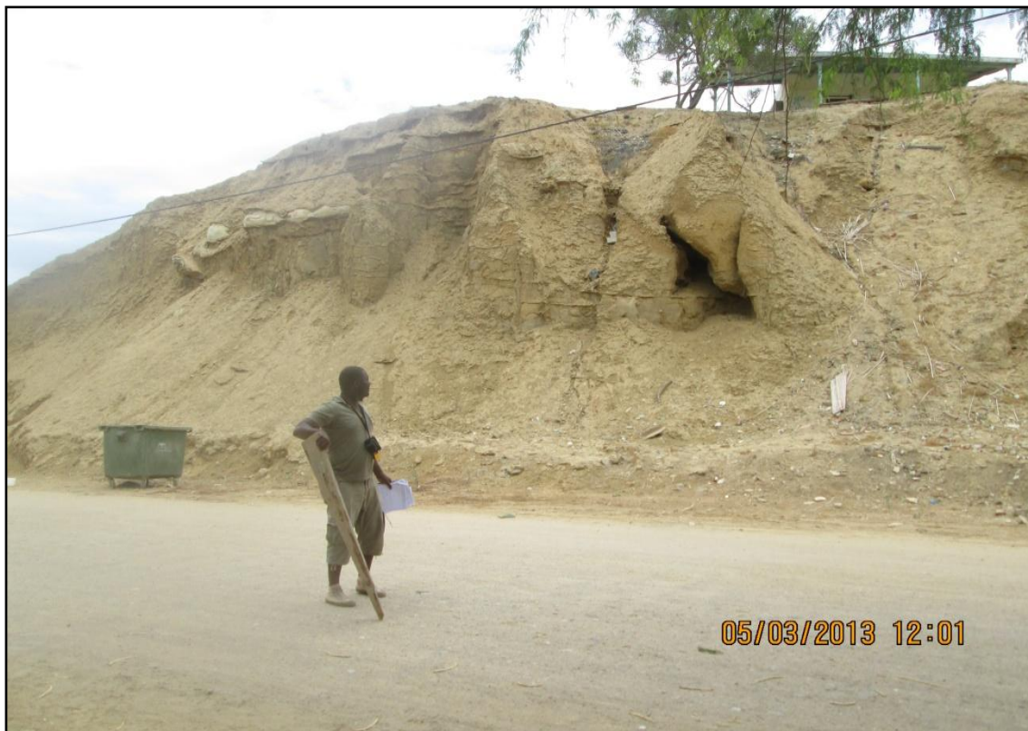
Figura 5.9 – Instabilização de uma residência.
