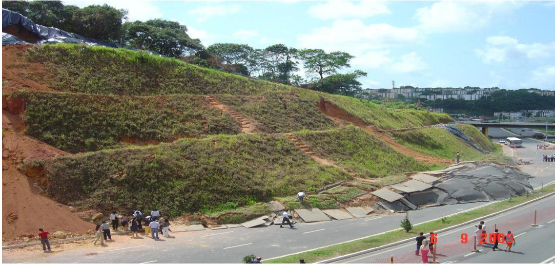
Figura 3.3 - Instabilidade de talude ocorrido em Salvador, 2005 deslizamento de solo (retirado em Gerscovich, 2009).
