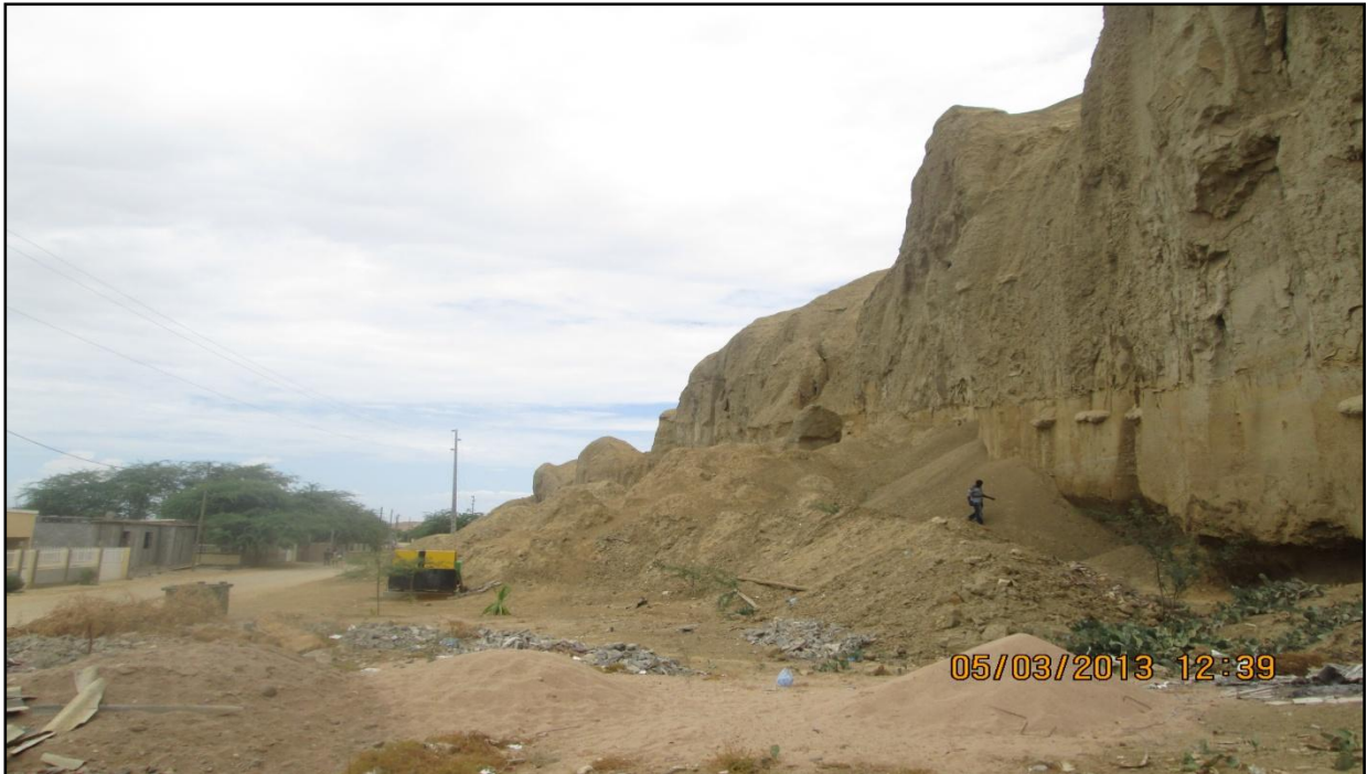
Figura 5.11 - Que ilustra a instabilidade eminente com ravinamento na base do talude, erosão intensa e desprendimento e a acção antrópica.
