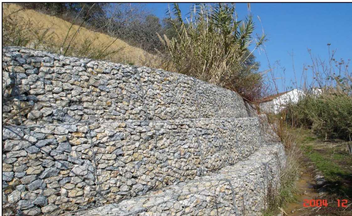
Figura 3.3.2 Imagem que ilustra o muro de gabiões (retido em Andrade, 2011)
