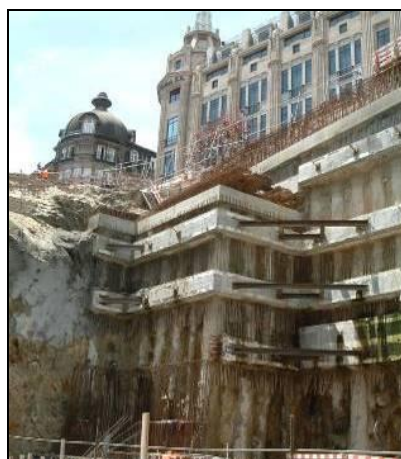
Figura 1.6 – Cortina de estacas na Estação dos Aliados, Metro do Porto (Viana da Fonseca em 12-05-2003).
