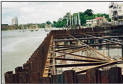
Figura 1.3 – Cortina de estacas prancha (www.franki.com).
