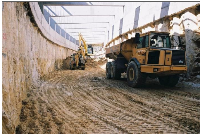
Figura 2.6 - Fotografia ilustrativa da fase de escavação da trincheira após colocação das escoras (Transmetro)
