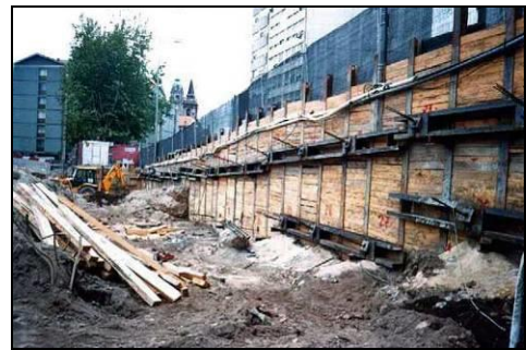
Figura 1.2 - Parede Berlim, Trindade, Metro do Porto (Viana da Fonseca em 17-8-2002).
