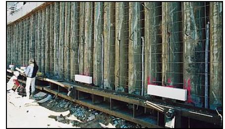
Figura 1.7 – Cortina de estacas secantes ( www.franki.com ).
