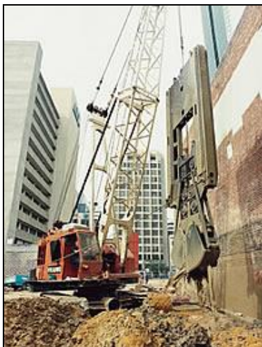
Figura 1.9 – Execução de parede moldada (www.franki.com)
