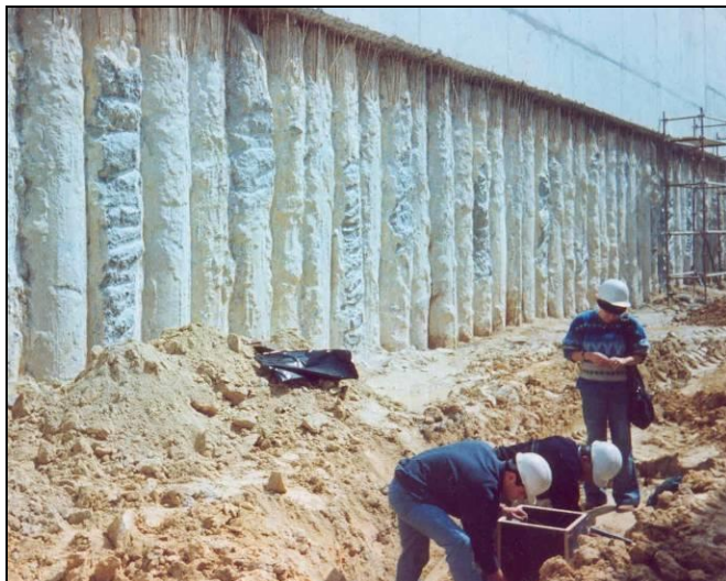
Figura 2.3 - Fotografia da cortina de estacas durante a recolha de amostras em bloco pelo Laboratório de Geotecnia da FEUP em 26-04-2002.
