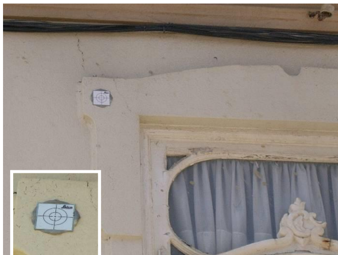
Figura 2.21 – Fotografia de um alvo topográfico colocado num edifício adjacente à escavação
