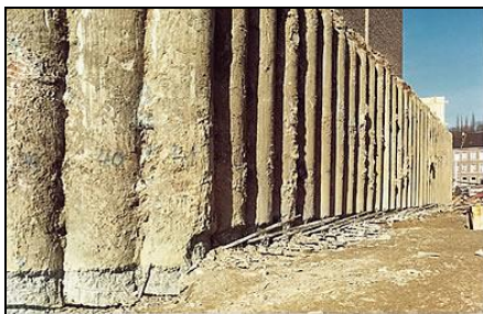
Figura 1.4 – Cortina de estacas moldadas contíguas (www.franki.com).
