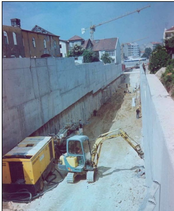
Figura 2.19 - Vista geral da escavação e edifícios adjacentes
