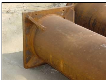
Figura 2.4 – Pormenor das escoras (CIV14)
