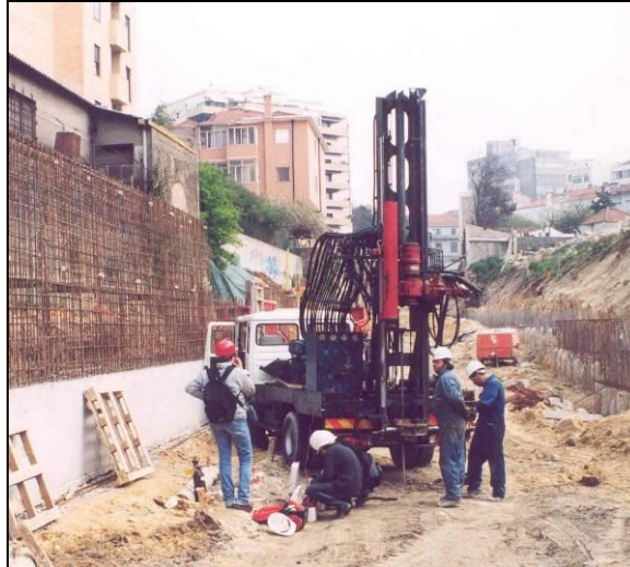
Figura 3.24 – Equipamento para cravação do amostrador SPT (Viana da Fonseca em 07-03-2002)
