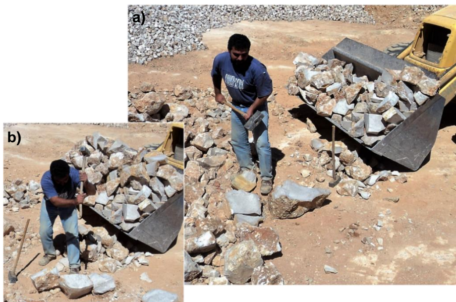
Figura 3.7 – Processo de “traçagem” dos blocos de calcário: a) subdivisão dos blocos de maior dimensão com uma marreta de 8 kg; b) subdivisão dos blocos mais pequenos com uma marreta de 4 kg.
