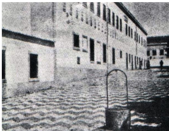
Figura 2.3 – Fotografia de 1842 com a Calçada Portuguesa em ziguezague no Castelo de São Jorge (retirado de Marta, 2006).
