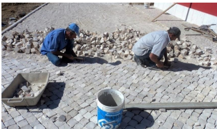
Figura 2.8 – Calceteiros a realizarem uma Calçada Portuguesa com meia-pedra de calcário vidroço branco de Alenquer.
