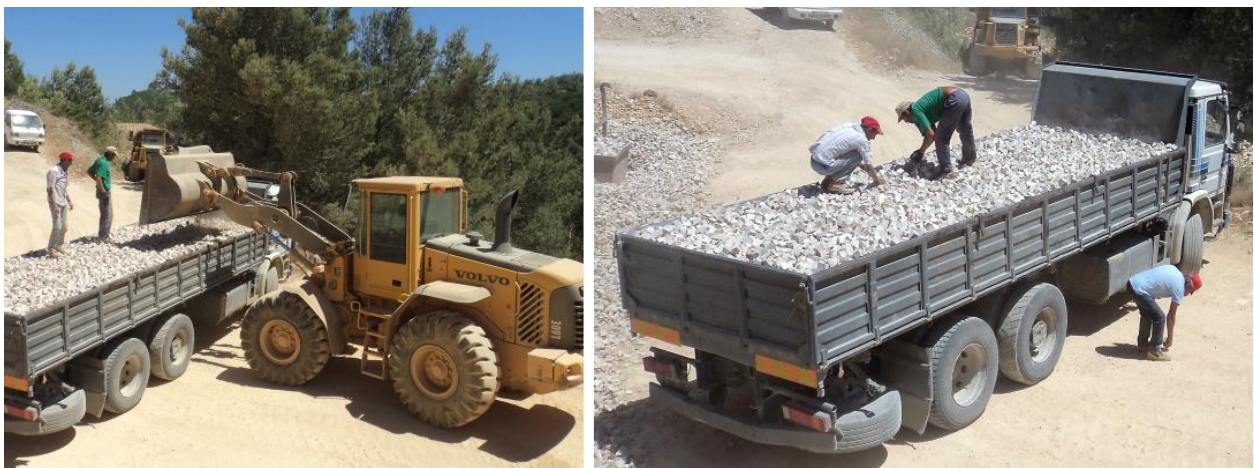
Figura 3.9 – Carregamento de pedra de calçada 5x7.
