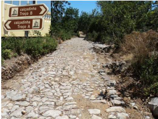
Figura 2.1 – Troço B da “Calçadinha” em São Brás de Alportel, com calcetamento lajeado. Fazia parte da via romana que ligava a cidade de Ossonoba (Faro) a Pax Julia (Beja) (Silva, 2002).
