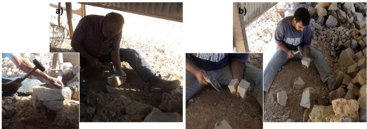
Figura 3.8 – Corte de pedra de calçada: a) talho dos blocos no chão; b) aparelhamento da pedra na concha da mão.
