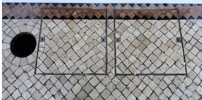
Figura 2.10 – Exemplo de um correcto contorno e preenchimento de caixas numa calçada portuguesa.
