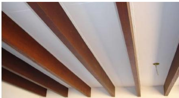
Figura 2.3 – Vista interna de uma estrutura mista madeira-betão.
