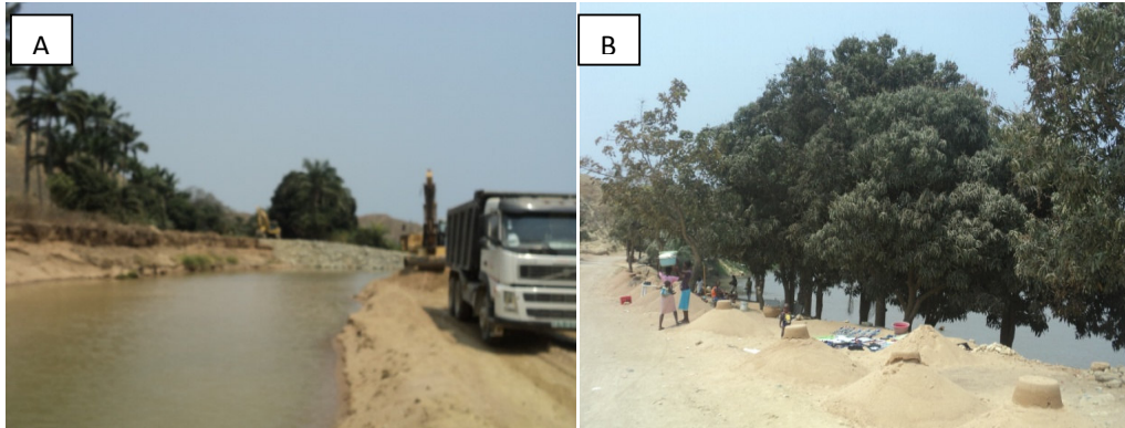
Fig. 4.11- Extração de inertes para construção no Catumbela. (A) processo industrializado; (B) venda avulso.
