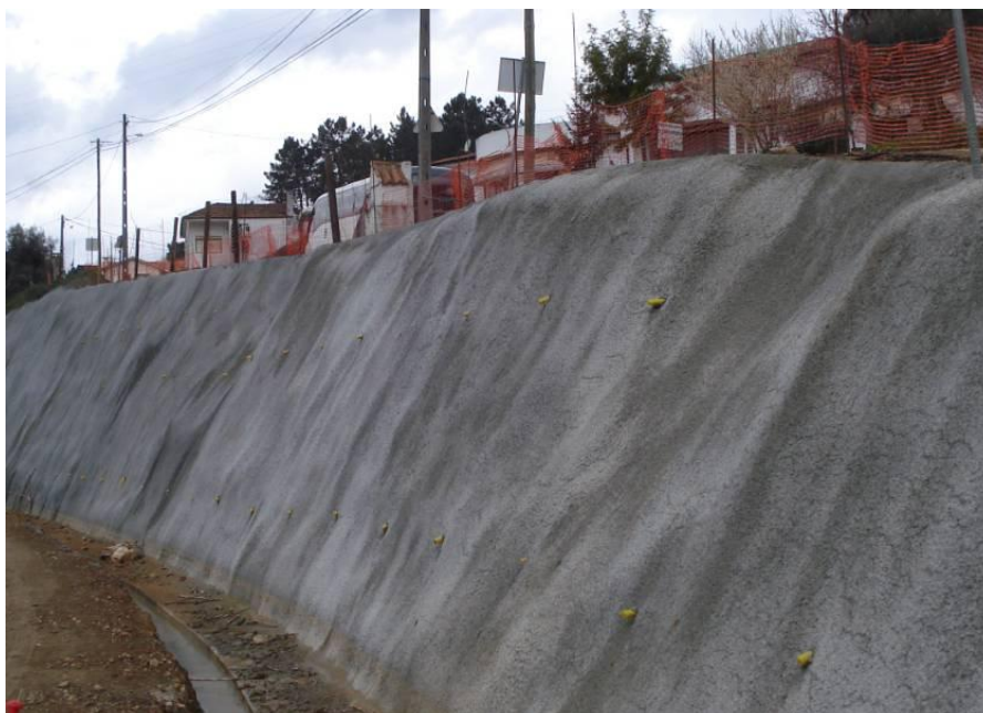
Figura 2.7 – Utilização de betão projectado num talude.
