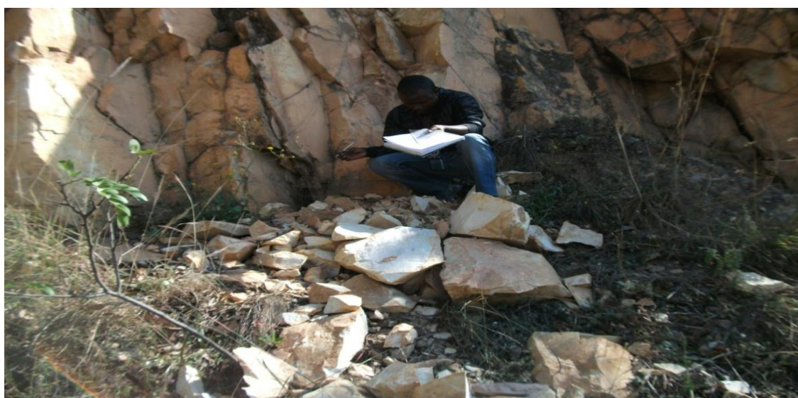
Figura 5.8 - Quedas de blocos no Talude 1 – 2º Troço, Março de 2011.
