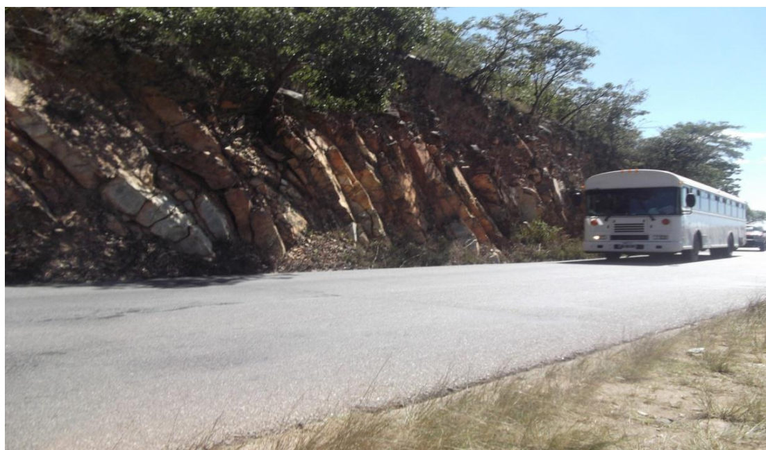
Figura 5.2 – Fotografia relativa ao Talude 2.
