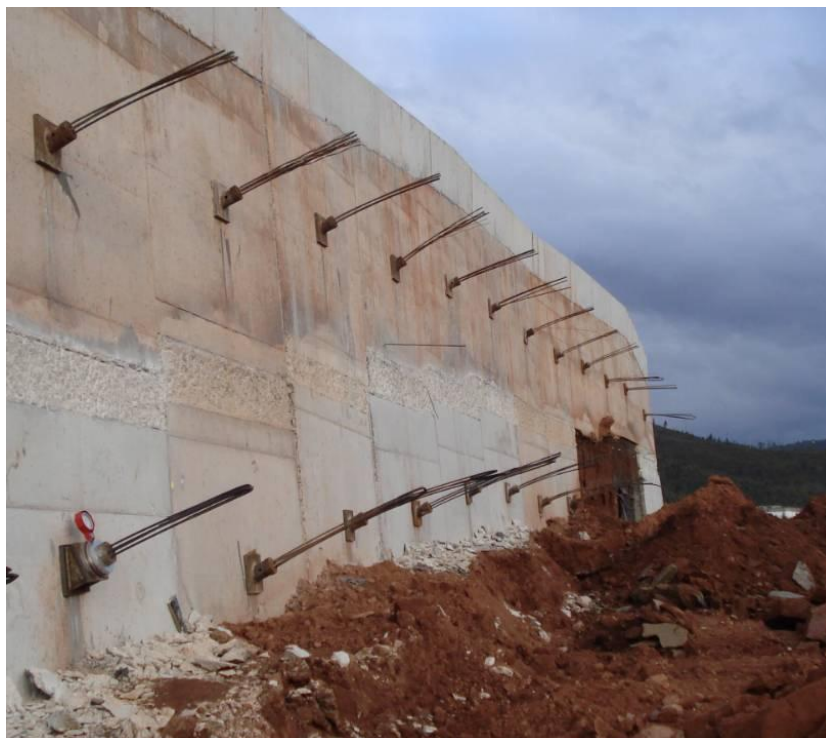
Figura 2.6 – Construção de muro de betão ancorado.
