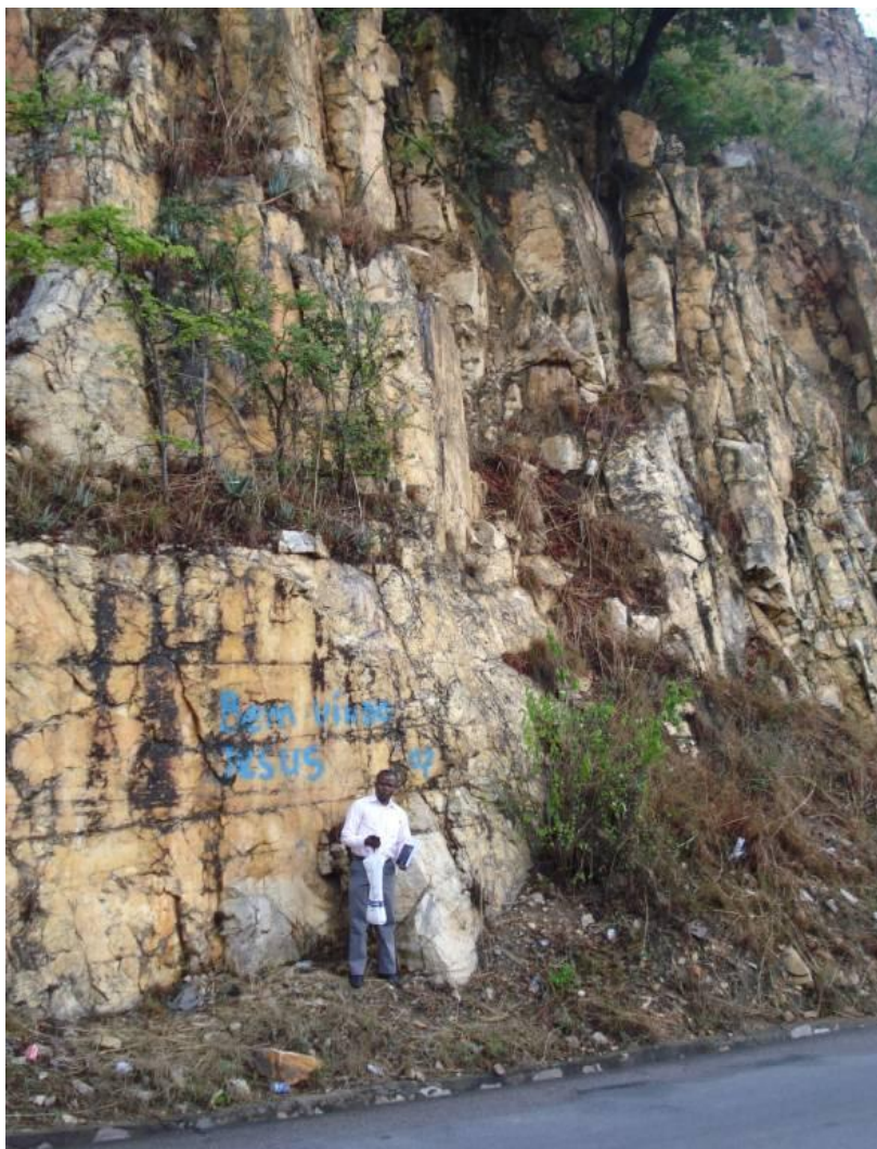
Figura 5.1 – 1º Troço do talude 1.
