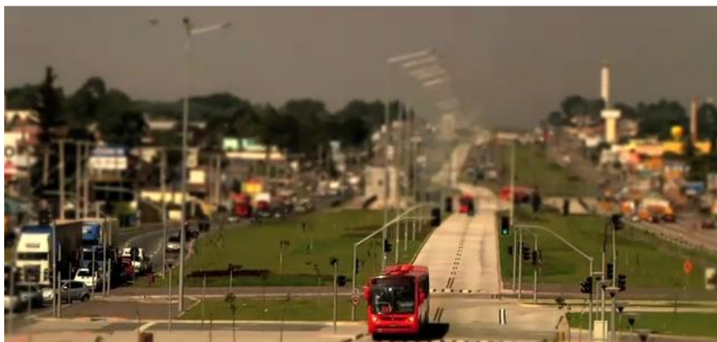
Figura 3.6 - Sistema BRT, em Curitiba, e respectiva segregação de vias (youtube.e@2011)
