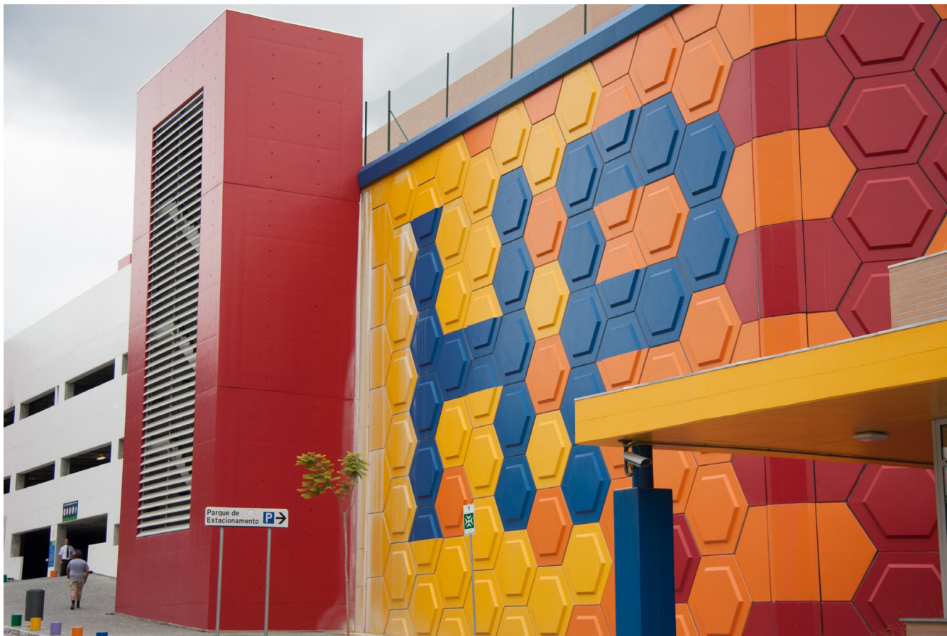
Fig. 33: Pormenor exterior do Hospital Pediátrico de Coimbra
