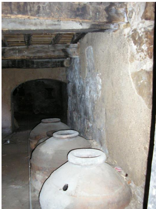
Figura 25: Vista parcial da estrutura remanescente da muralha (subcave)
