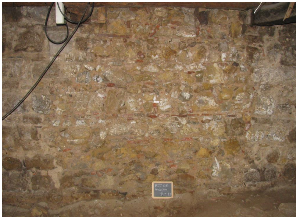
Figura 21: Vista parcial da estrutura remanescente da muralha (subcave)
