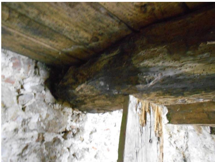
Figura 20: Fotografia da estrutura de madeira da cave (vista pela subcave) (07 Mar. 2013)
