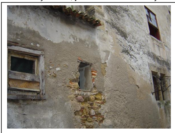
Figura 37: Pormenor da parede externa – Casa das Talhas, alçado oeste
