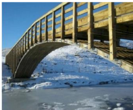
Figura 2.1-Tabuleiro de madeira lamelada pré-esforçada transversalmente (Ritter, 1990)
