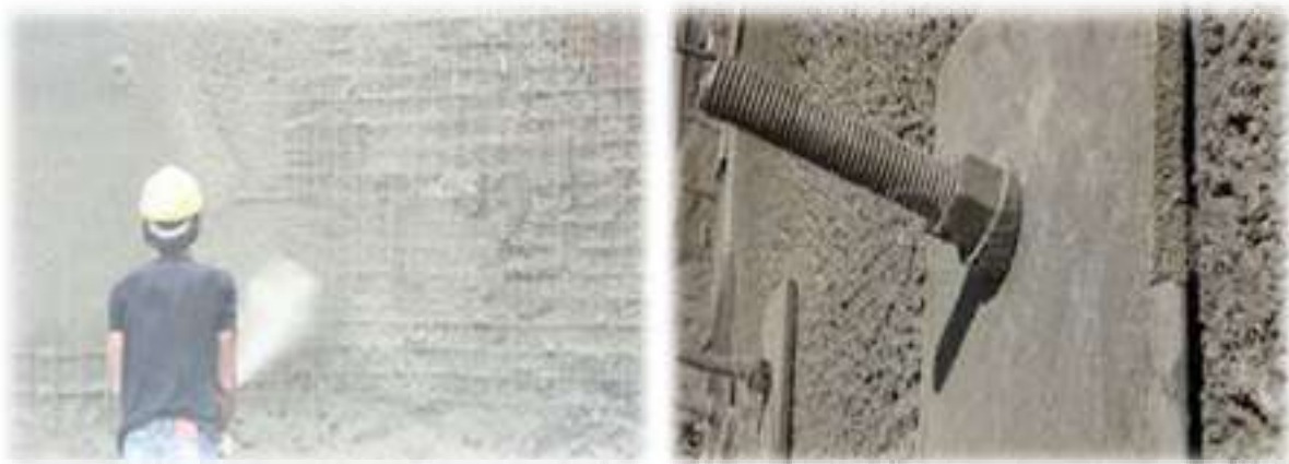
تصویر ۲-۱۶) نمایی از اجرای شاتکریت و اتصال صفحه باربر به صفحه شاتکریت
