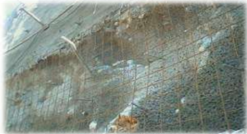
تصویر ۲-۱۹) نصب شبکه فلزی قبل از بتن پاشی
