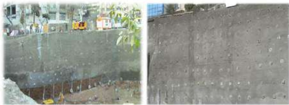
تصویر ۲-۱۲) نمایی از اجرای روش میخکوبی
