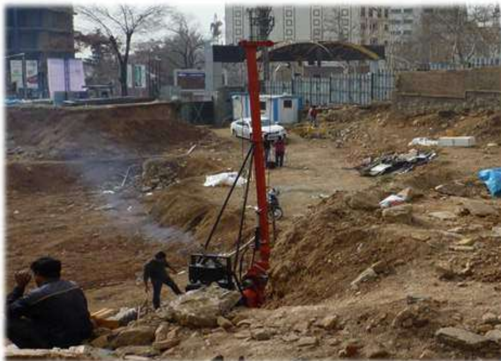
تصویر ۲-۴) نمایی از محل پروژه (در حال گمانه زنی با ماشین)
