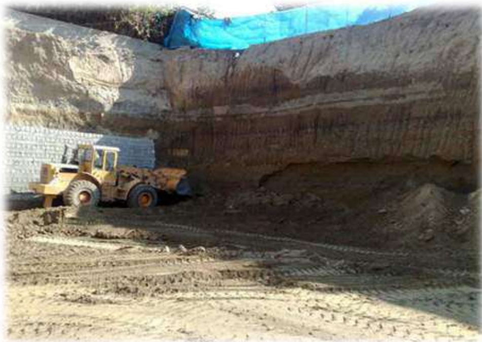
تصویر ۱-۵) وجود آب زیرزمینی در مهرشهر کرج سبب ناپایداری جداره گود شده است
