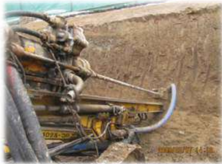
تصویر ۲-۱۸) عملیات حفر سوراخ
