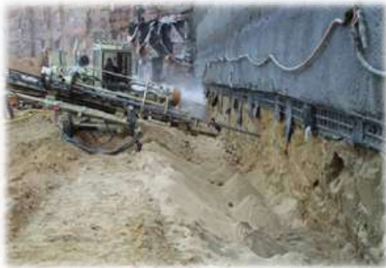
تصویر ۲-۱۷) روش میخکوبی به روش شلیک میخ
