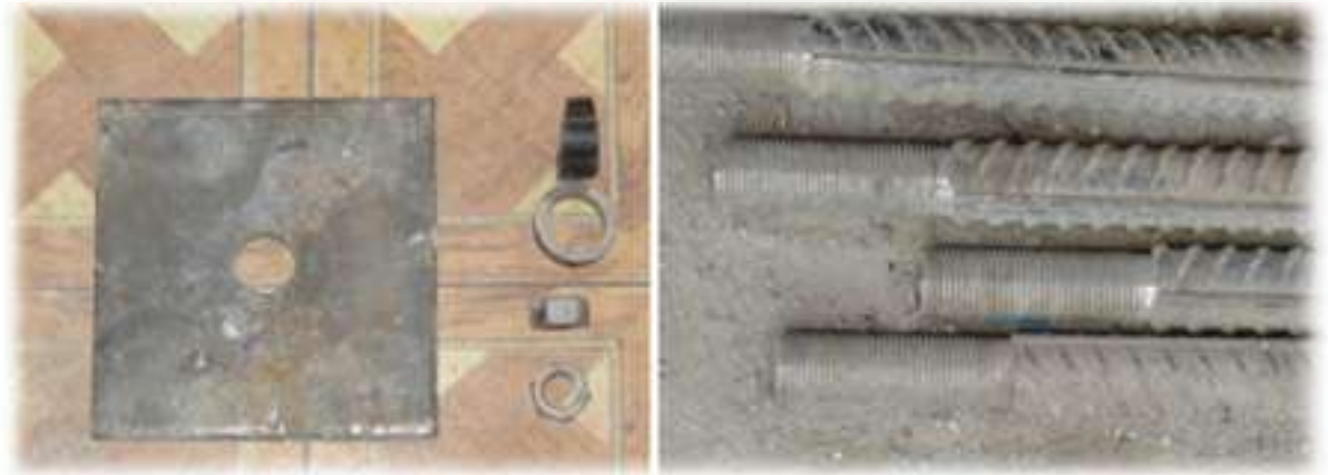
تصویر ۲-۱۵) نمایی از سر نیل رزوه شده و مجموعه صفحه باربر، واشر و مهره
