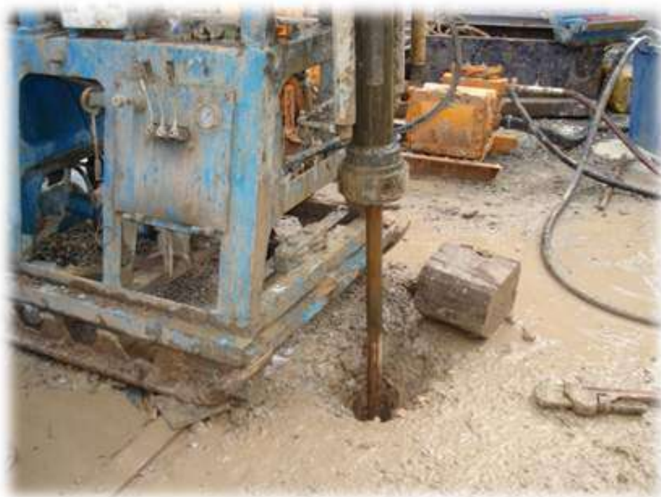
تصویر ۲-۸) نمونه گیری با ماشین (به روش مغزه گیری)
