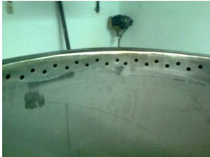
**Figura 3.5 - Drenagem de condensados de combustível (localizada no interior do depósito de combustível).**
