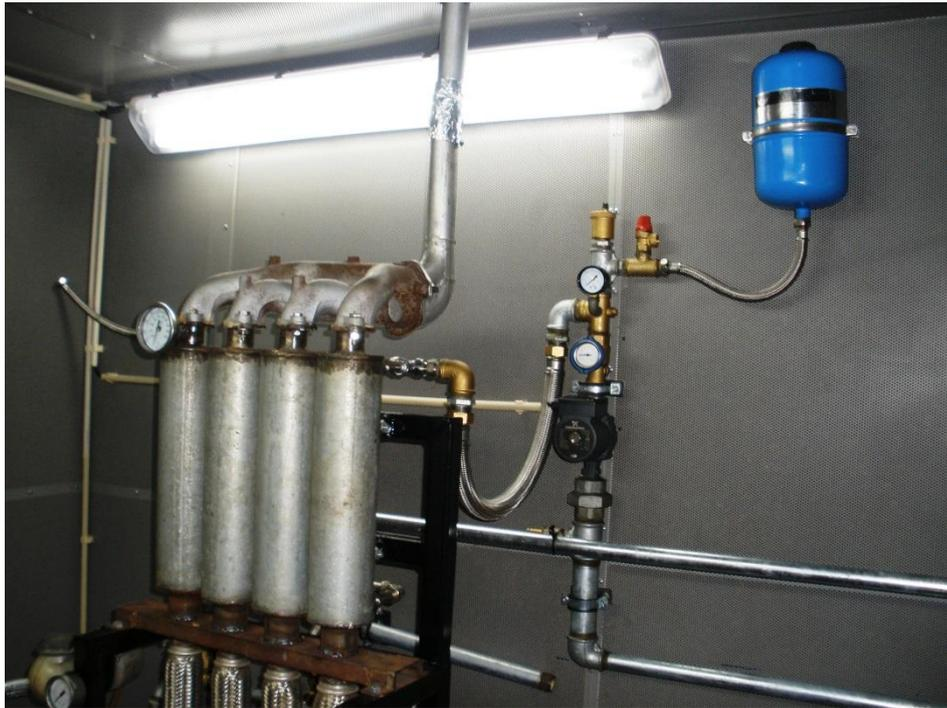
**Figura 3.11 - Vista das condutas de escape dos gases do motor.**
