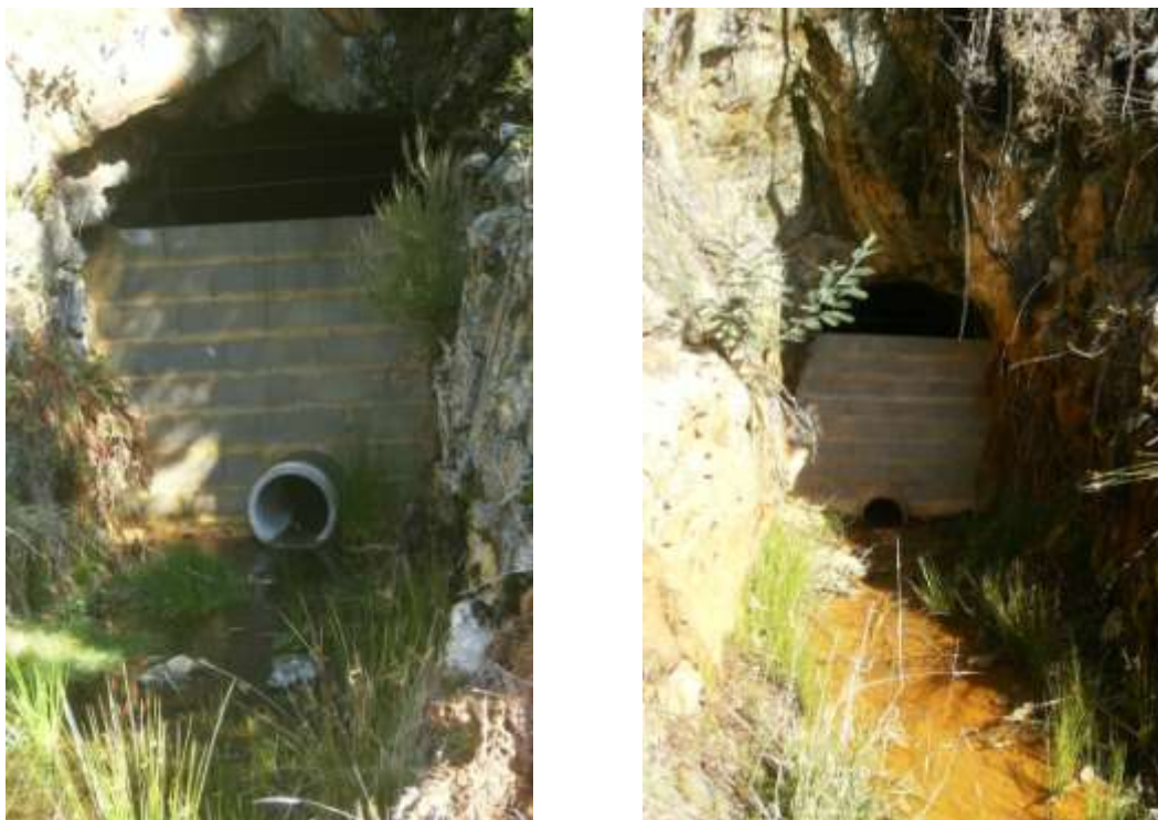
Fig. 3.1 – Escoamento de efluentes mineiros em entradas para galerias da mina da Escádia Grande. a) Coordenadas: 4437129 N, 575224 E. b) Coordenadas 4437148 N, 575254 E. (março, 2013)
