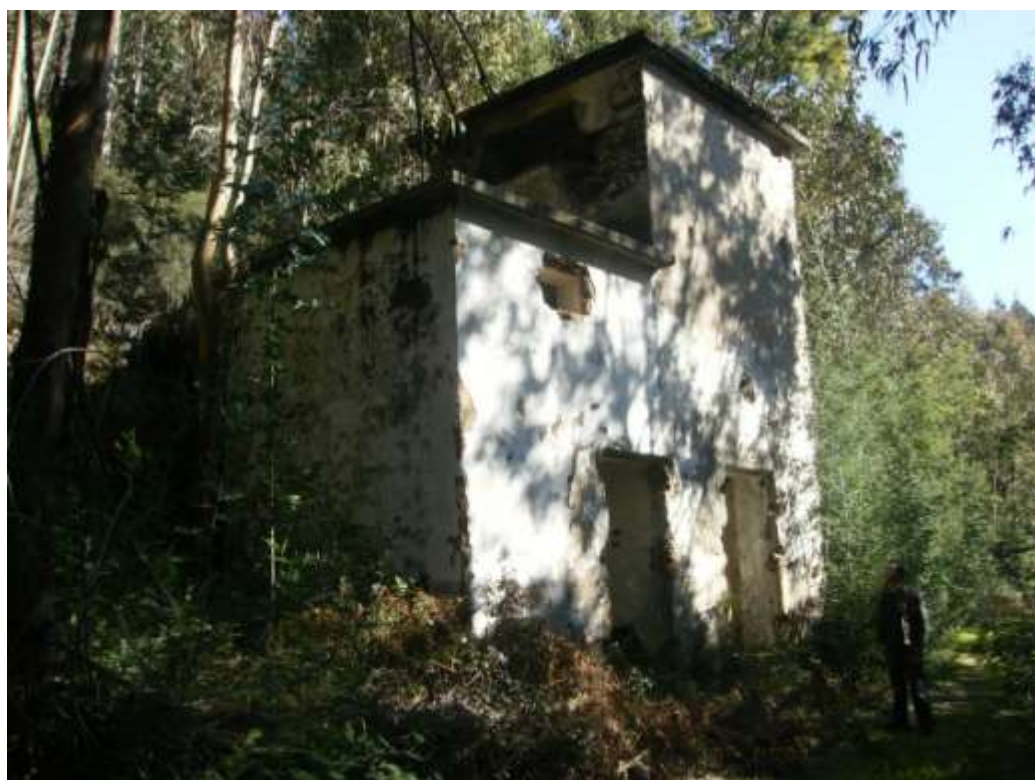
Fig. 3.4 – Edifício de alimentação elétrica da mina da Escádia Grande (março 2013).
