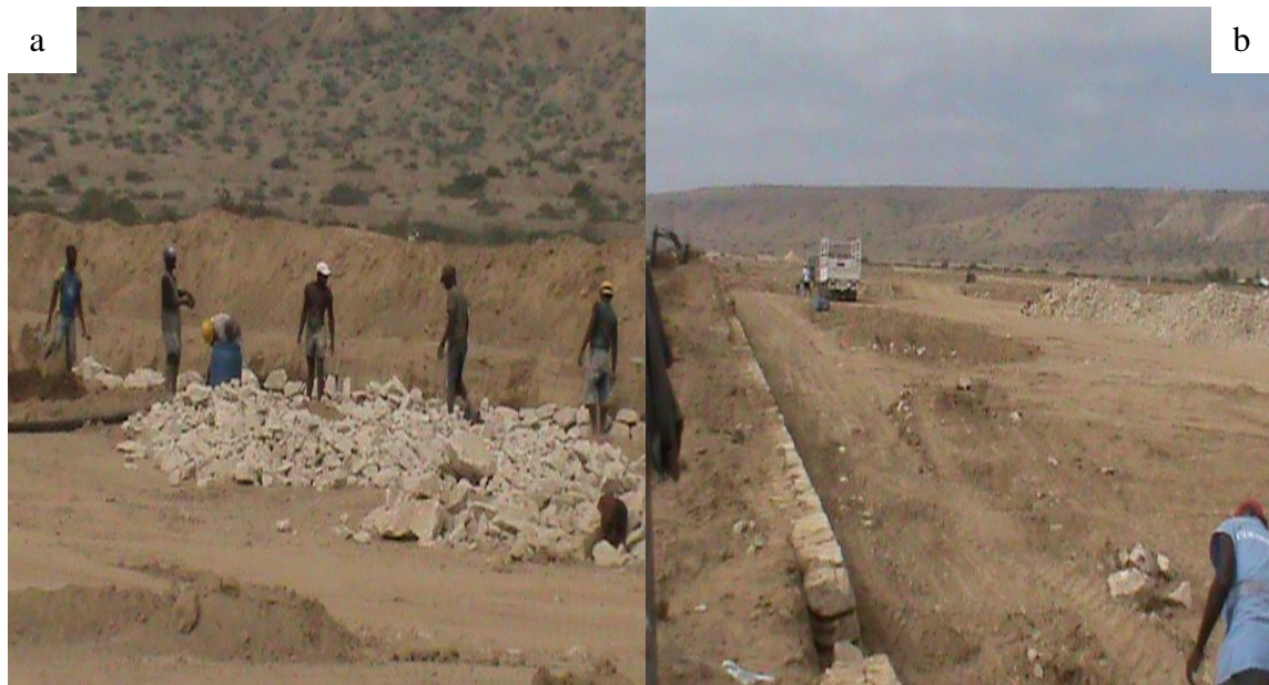
Figura III. 13 a, b- Construção da nova unidade da salina do Chamume.
