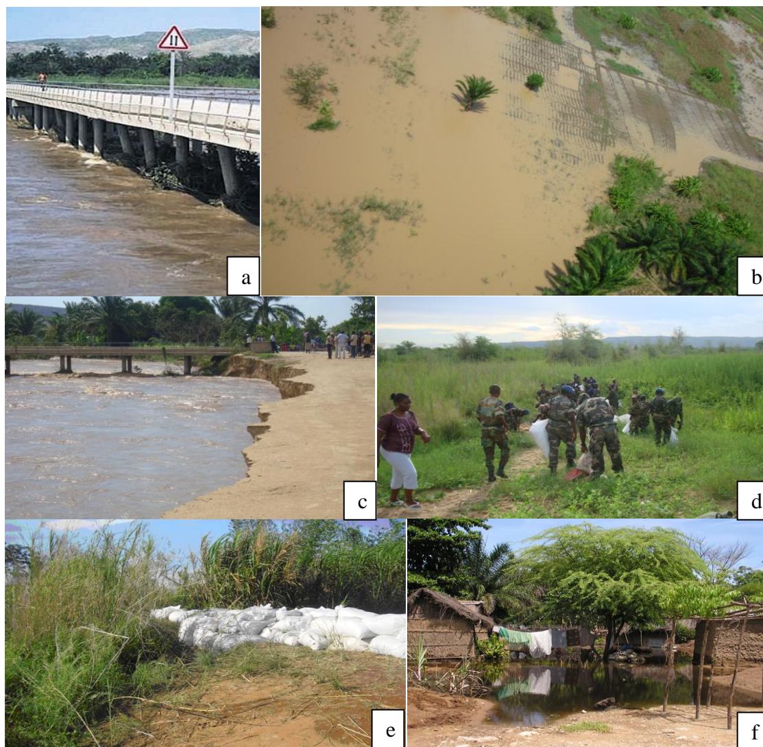
Figura IV. 15- Efeitos das cheias de Fevereiro de 2011. (a) Danos estruturais na ponte sobre o rio Copororo; (b) Imagem aérea de acmpos agrícolas inundados; (c) erosão nos bancos fluviais junto à ponte sobre o Coporolo; (d) construção de diques para proteger das cheias; (e) aspecto dos diques; (f) Imagem de casas em adobe e taipa ainda afectadas pelas cheias em Abril de 2010. As fotos (b), (c), (d) e (e) são retiradas de CPPC (2010).
