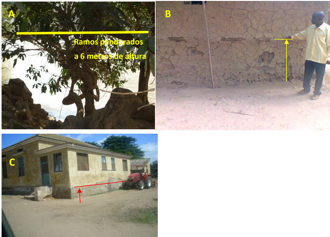
Figura 4.4: Marcas deixadas pelas inundações de 2011. (A) À saída do soco, a presença de galhos partidos em árvores mostra que as cheias alcançaram 6 metros. (B) Bairro do Soba, Dombe-Grande, onde o rio subiu 4,1 metros (C) Povoado do Luacho, onde o rio subiu 2,8 metros.
