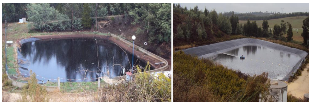
Figura 2.2- Lagoas de receção de lixiviado.
