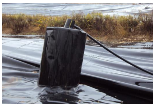
Figura 2.3- Posso de extração do biogás numa célula em processo de selagem.
