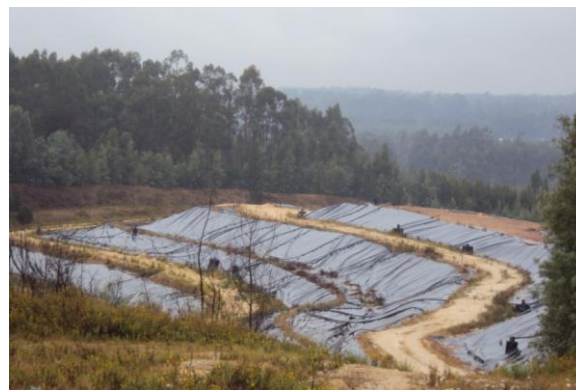
Figura 2.7- Célula de um aterro em processo de selagem.
