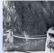
Ponte suspensa chinesa sob o rio Mekong construída por volta de 1470.
