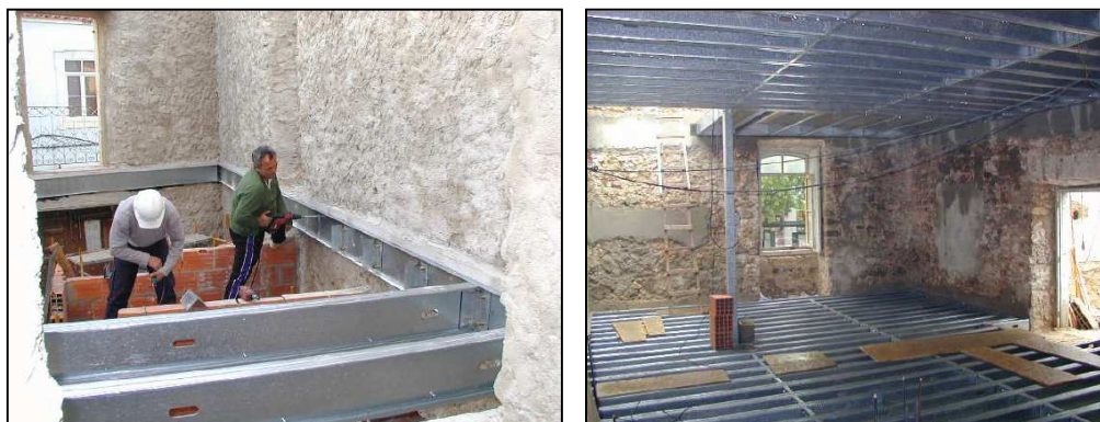
Figura 2.9 – Exemplo de reabilitação e reforço de estruturas com elementos de aço (Gervásio, 2008).
