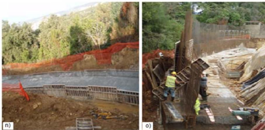
Fig. 9.6 – Finalização da sapata. n) Fase em que a sapata foi betonada; o) Início da execução da parte superior do muro com a colocação das cofragens.
