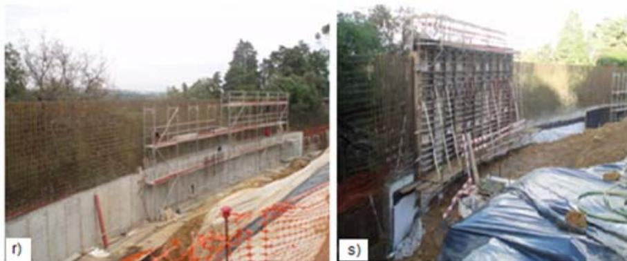
Fig. 9.8 – Construção da parte superior do muro. r) Primeiro nível do muro concluído; s) Início do segundo nível do muro concluído.
