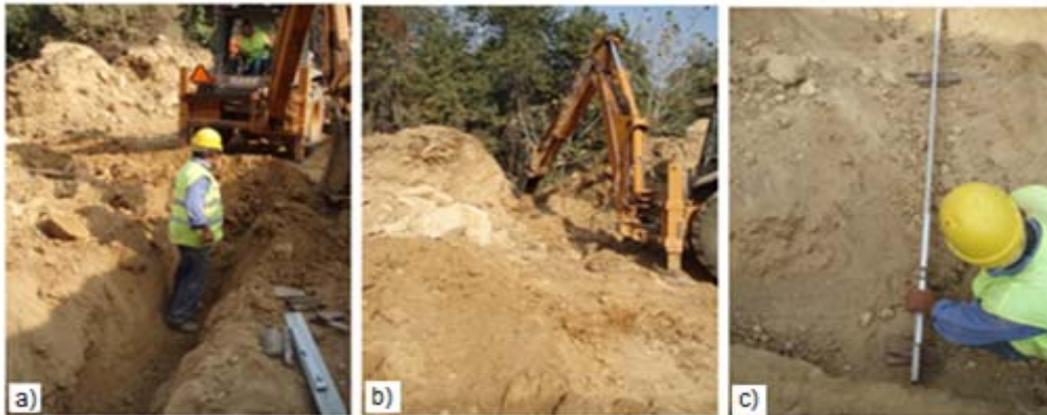
Fig. 9.1 – Trabalhos para drenagem da fundação do muro de suporte. a) e b) Abertura de valas para implementar sistema de drenagem profundo da fundação do muro; c) Verificação do ângulo de queda.
