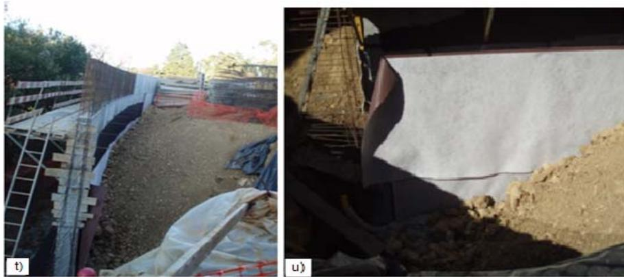
Fig. 9.9 – Sistema de impermeabilização do muro de suporte. t) Painéis drenantes e parte do material de aterro colocado a tardoz do muro; u) Pormenor da tela pitonada.
