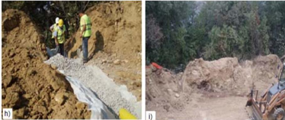
Fig. 9.3 – Trabalhos para drenagem da fundação do muro de suporte. h) Colocação de brita sobre o sistema drenante ; i) Cobertura do sistema de drenagem com solo.
