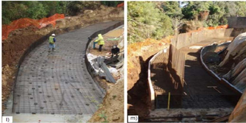
Fig. 9.5 – Preparação da sapata do muro. l) Início da execução da sapata com a colocação das armaduras; m) Sapata pronta a betonar.
