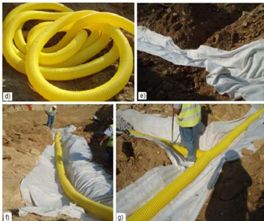
Fig. 9.2 – Trabalhos para drenagem da fundação do muro de suporte. d) Pormenor do tubo dreno aplicado; e) Pormenor da manta geotêxtil aplicada; f) e g) Aplicação do tubo dreno e da manta ao longo das valas.
