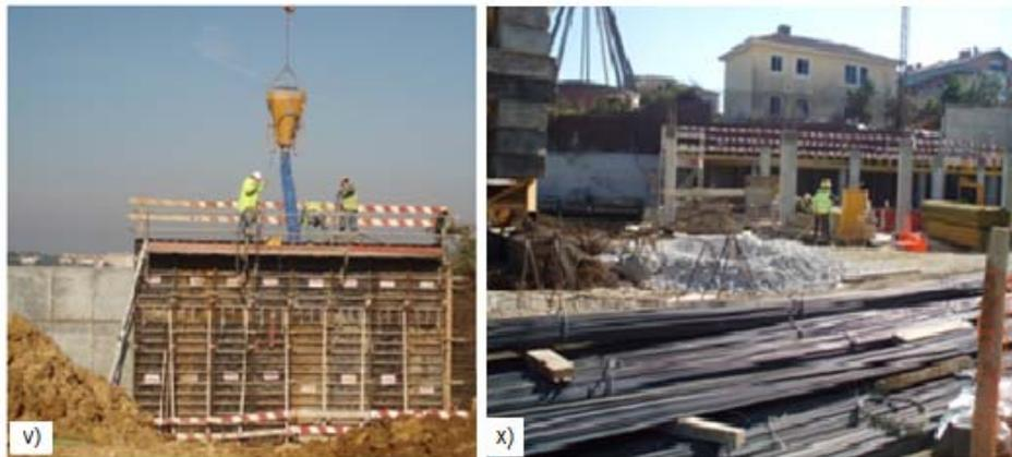
Fig. 9.10 – v) Betonagem do último trecho de muro; x) Ponto de situação da edificação.
