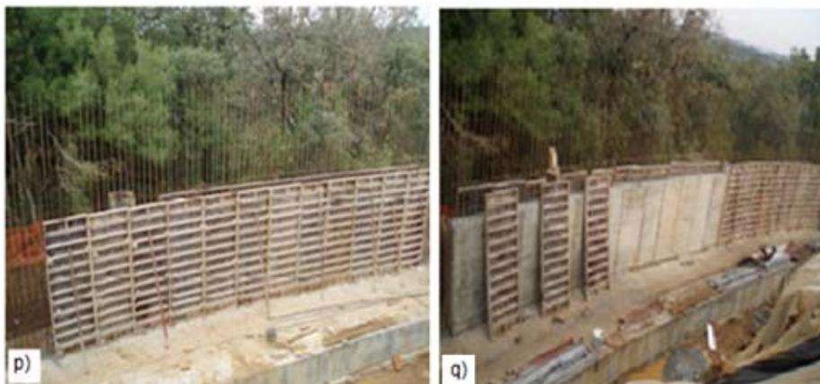
Fig. 9.7 – Construção da parte superior do muro. p) Primeiro trecho do primeiro nível do muro betonado; q) Primeiro nível do muro em fase de conclusão.
