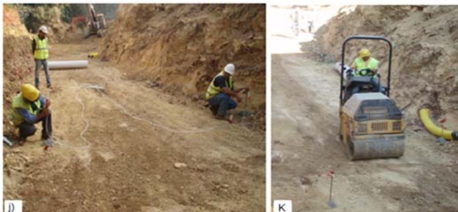
Fig. 9.4 – Uniformização da superfície. j) Nivelção aplicando o sistema de mangueira; k) Compactação.
