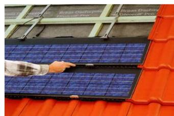
Figura 4.13 – Módulo PV integrado com solução em sandwich para utilizar como telha. [S-Energy@].
